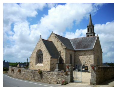
Lanarvily, église paroissiale : vue générale nord-est Phot. Gwénaél Fauchille IVR53_20082906321NUCA
