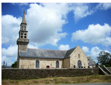
Lanarvily, église paroissiale : vue générale sud-ouest Phot. Gwénaél Fauchille IVR53_20082906320NUCA
