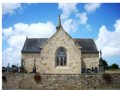
Lanarvily, église paroissiale : élévation est Phot. Gwénaél Fauchille IVR53_20082906322NUCA
