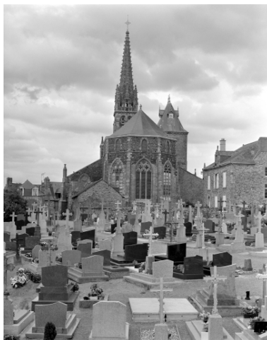
Elévation Ouest : vue générale
