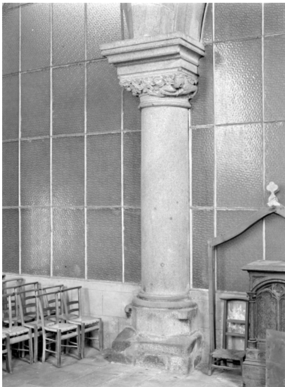
Intérieur, coté Sud, pilier n°1 : vue générale.
