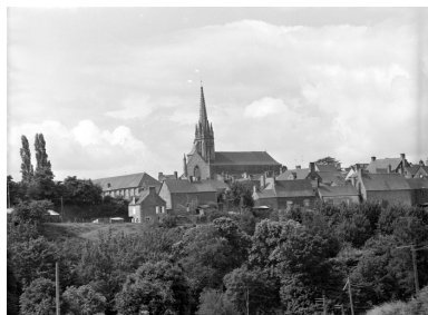
Elévation Nord-Est : vue de situation
