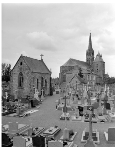
Elévation Ouest : vue de situation
