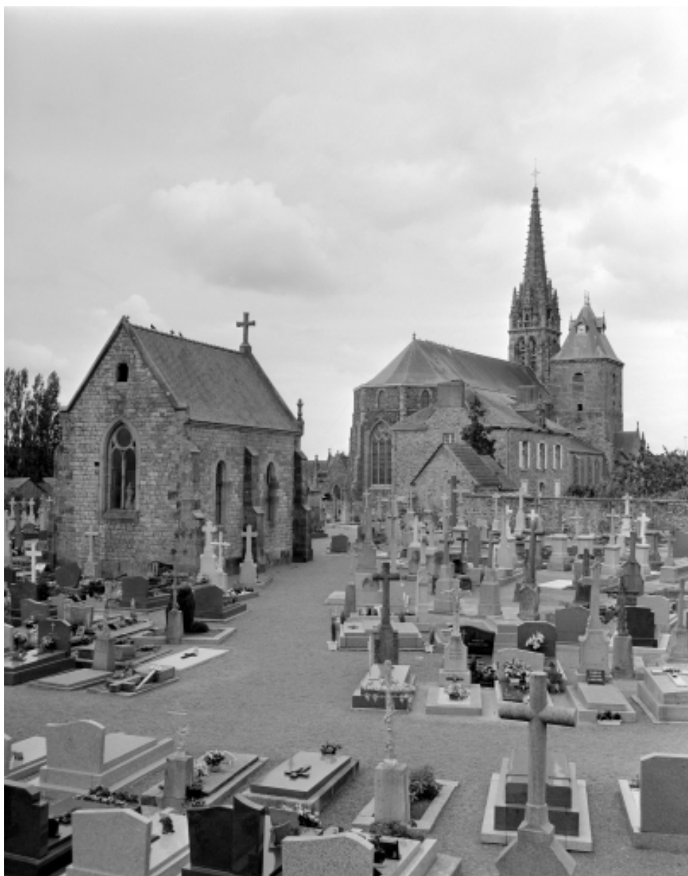
Elévation Ouest : vue de situation
