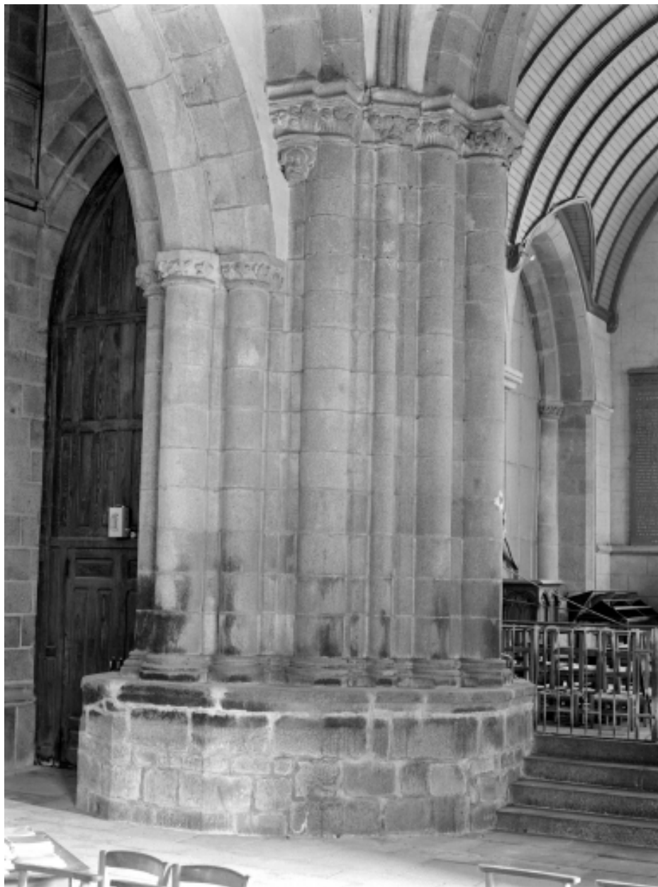
Intérieur, coté Sud, pilier n°2 : vue générale.
