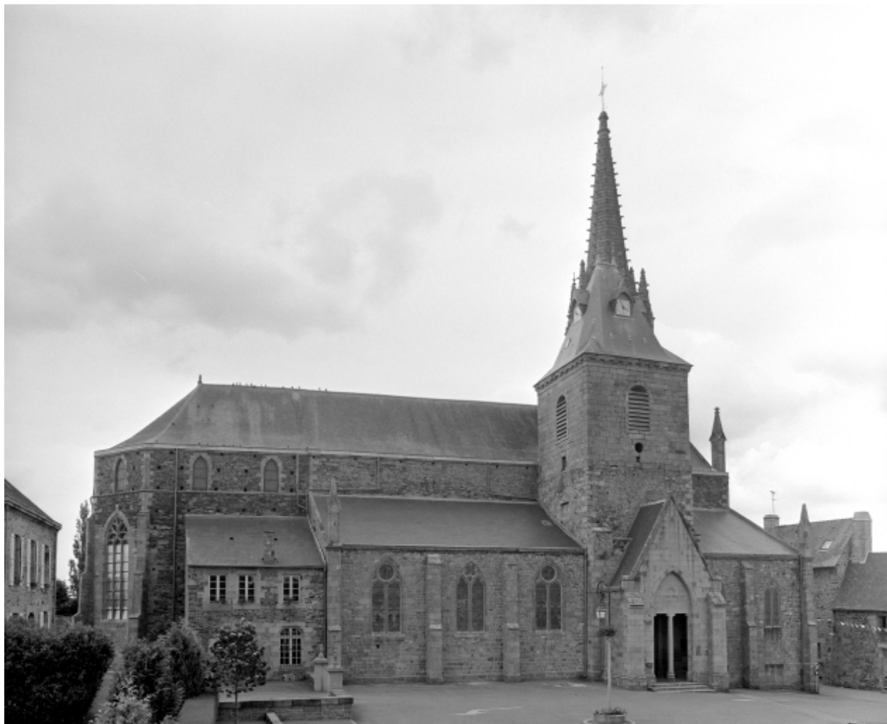
Elévation Sud : vue générale
