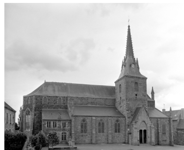
Elévation Sud : vue générale
