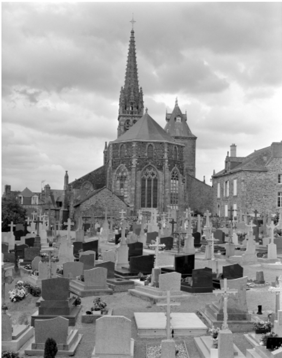
Elévation Ouest : vue générale
