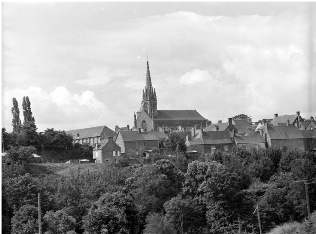
Elévation Nord-Est : vue de situation
