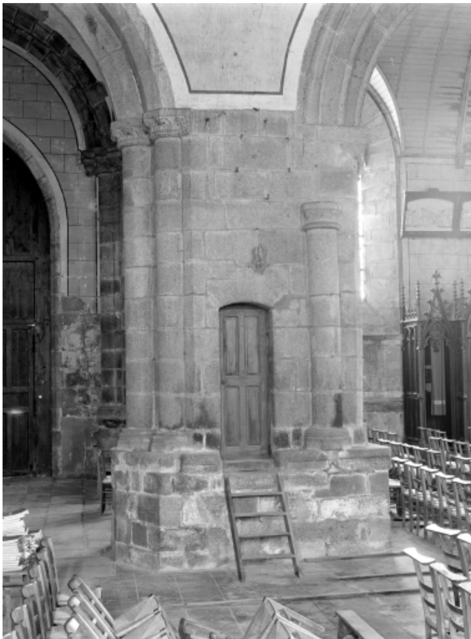
Intérieur, pile 3, côté Sud : vue générale.
