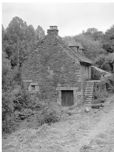
Vue générale ouest. Phot. Jean-Pierre Ducouret IVR53_19862200321X
