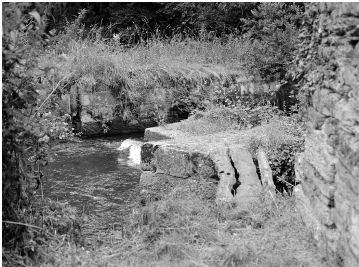
Détail des vannages.
