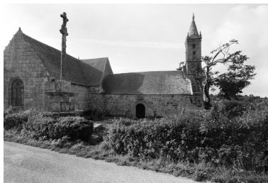
Vue de la face nord de la nef Phot. Guy Artur IVR53_19682201128V
