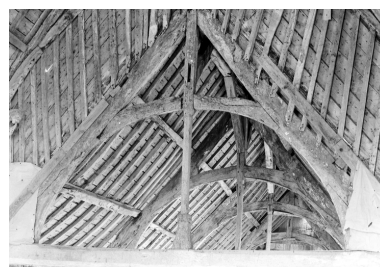
Détail de la charpente Phot. Guy Artur IVR53_19682201155V
