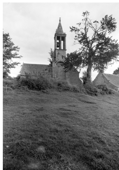
Vue générale de la face ouest Phot. Guy Artur IVR53_19682201135V
