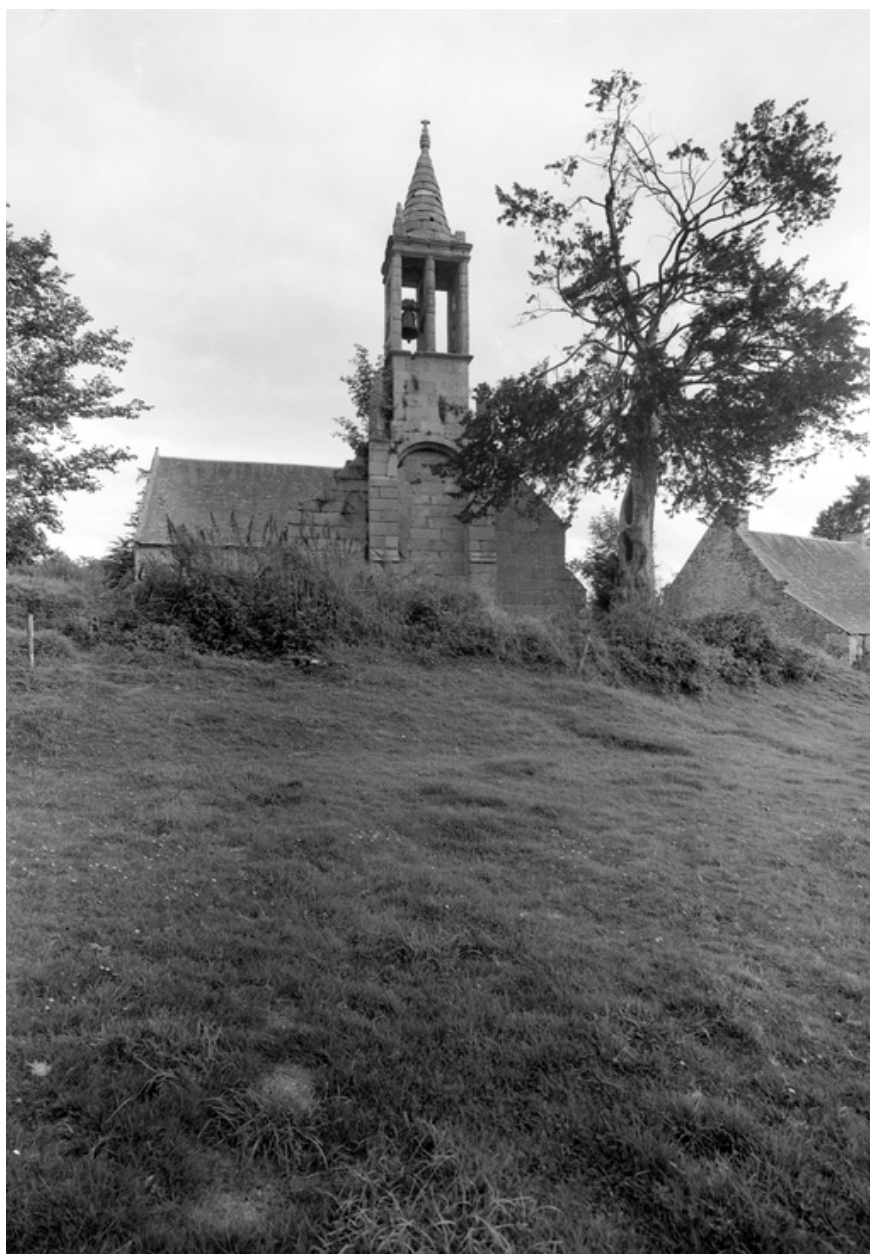
Vue générale de la face ouest
