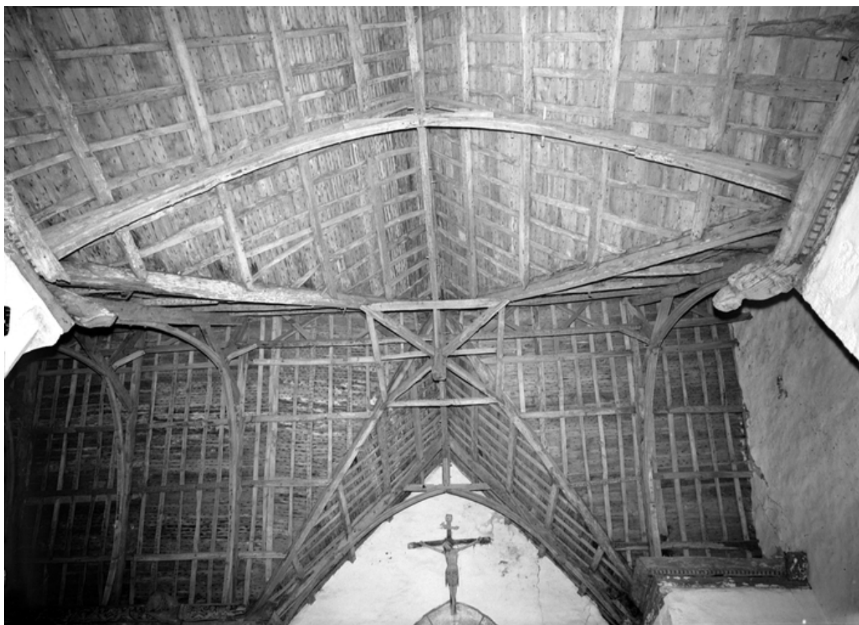
Vue de la charpente du choeur et des bras du transept
