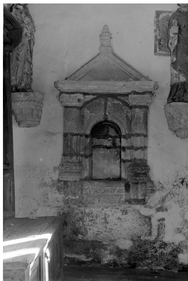
Crèche du bras nord du transept Phot. Guy Artur IVR53_19712200315V
