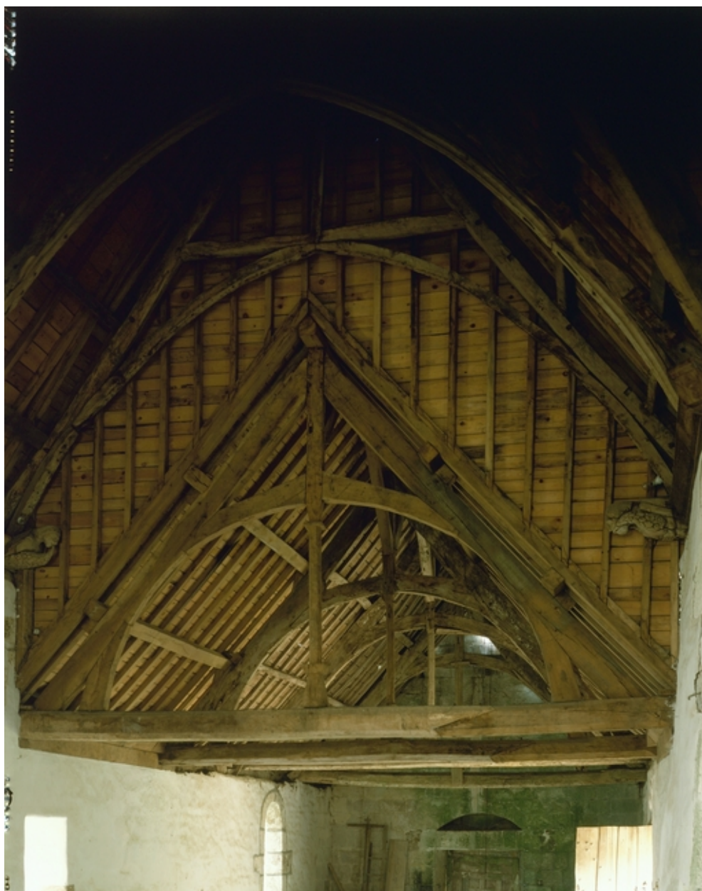
Charpente : vue vers l'ouest
