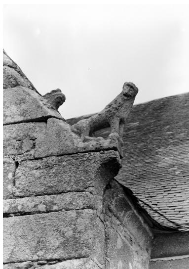
Pierre d'assise du rampant nord du pignon est du choeur Phot. Guy Artur IVR53_19682201133V
