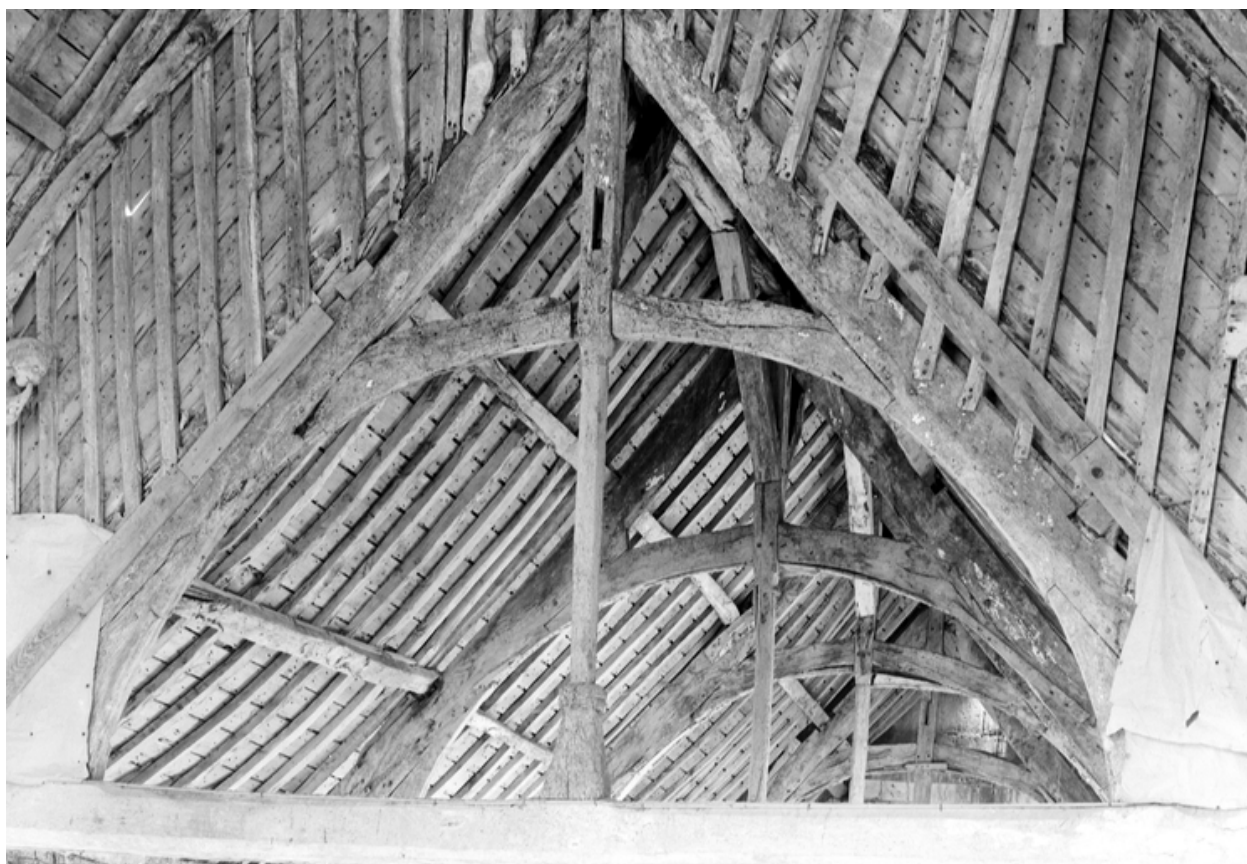
Détail de la charpente
