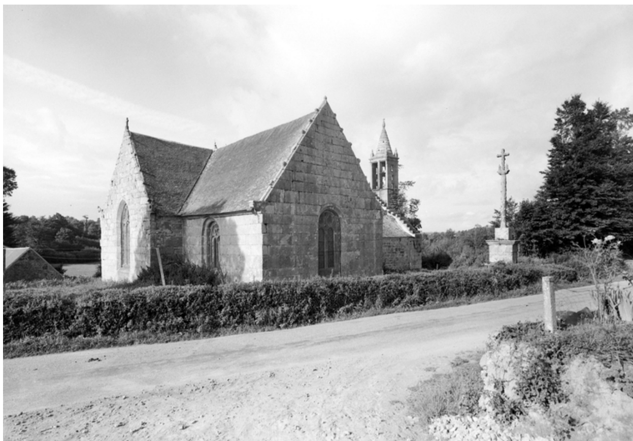
Vue d'ensemble nord-est
