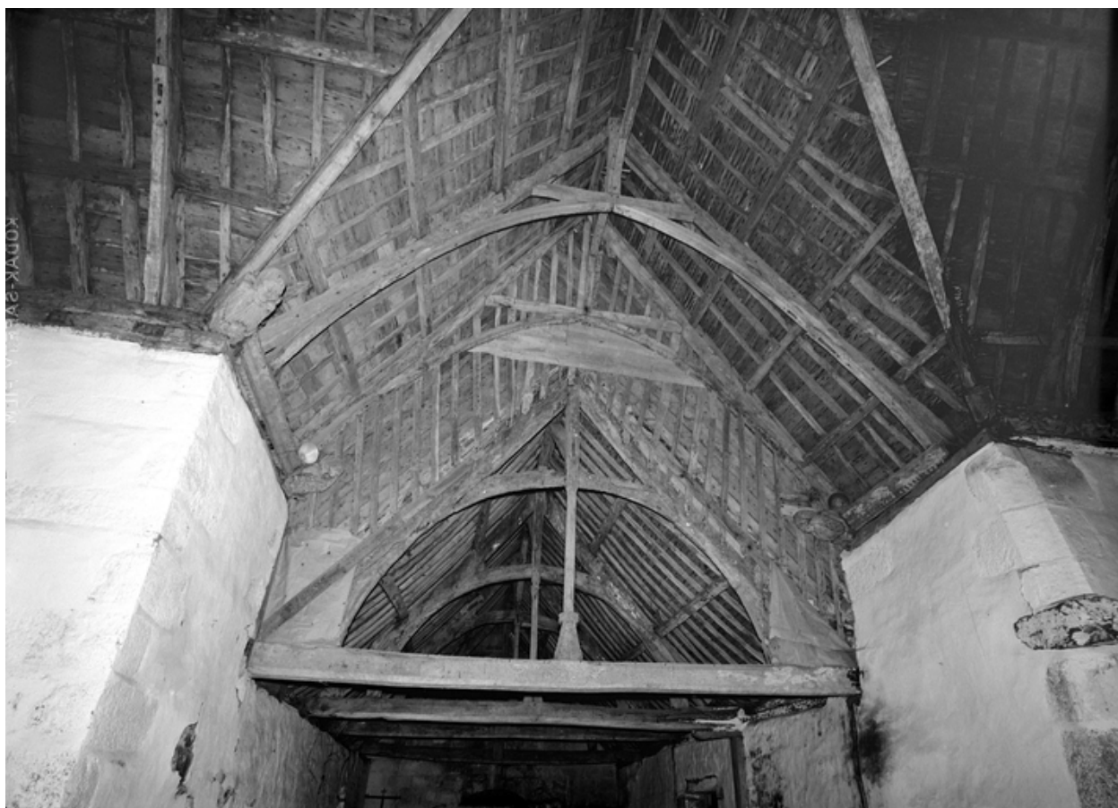
Vue de la charpente de la nef
