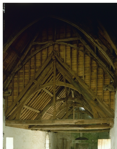
Charpente : vue vers l'ouest Phot. Service régional de l'Inventaire de Bretagne IVR53_19822200140VA
