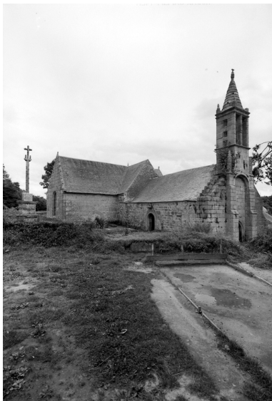
Vue d'ensemble nord-ouest Phot. Guy Artur IVR53_19682201127V
