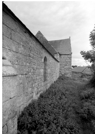
Mur ouest du bras sud Phot. Guy Artur IVR53_19682201129V
