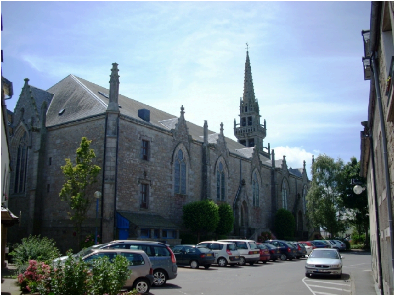
Cléder, église paroissiale Saint-Pierre : vue générale nord-est
