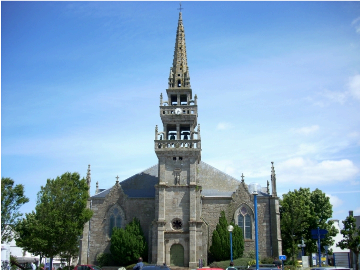
Cléder, église paroissiale Saint-Pierre : élévation ouest
