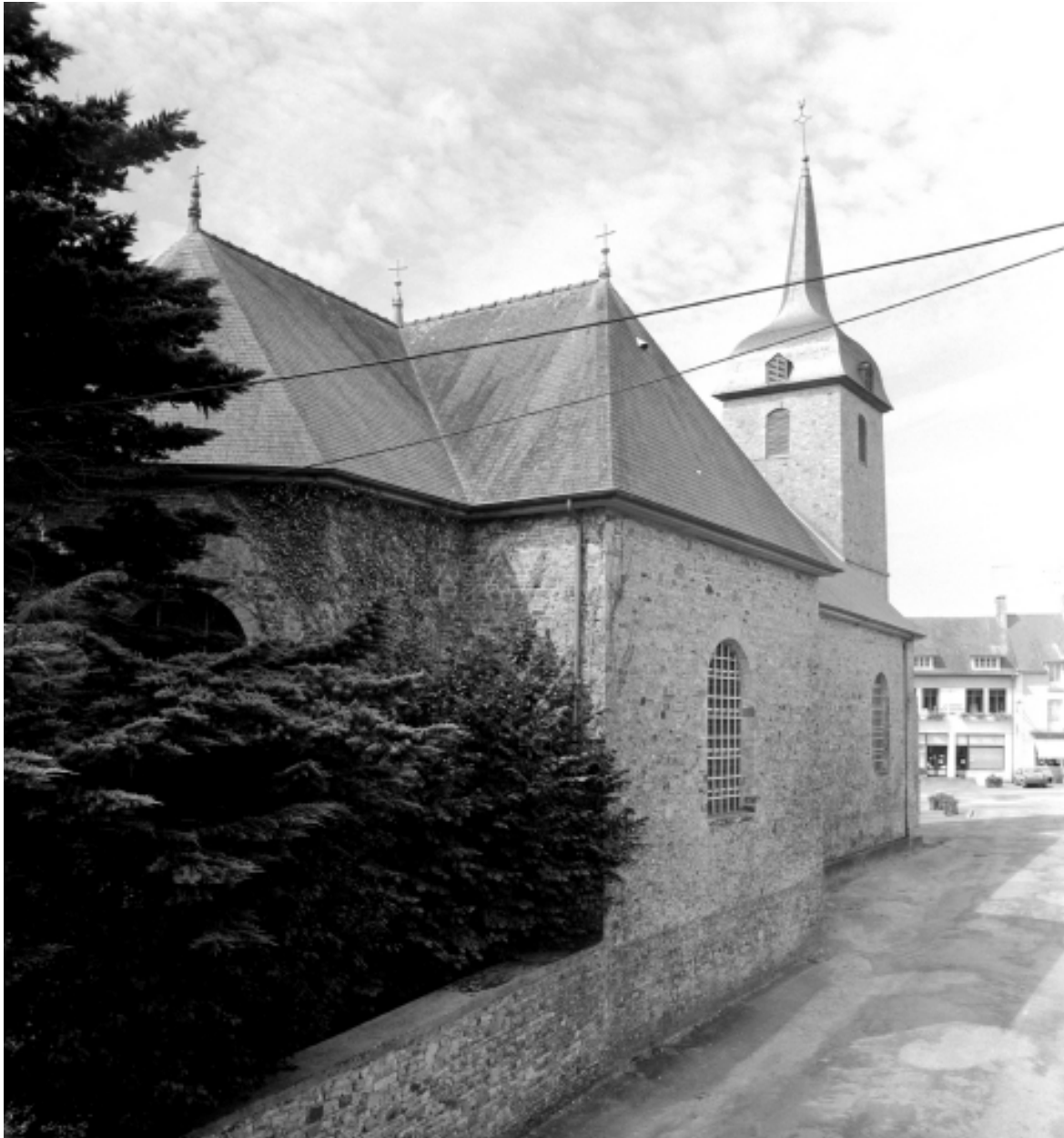
Elévation nord : vue générale
