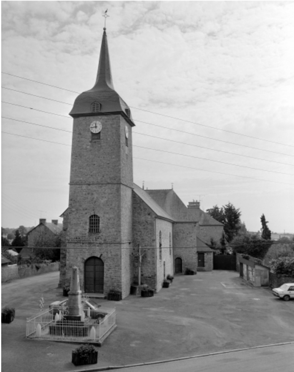
Elévation ouest : vue générale
