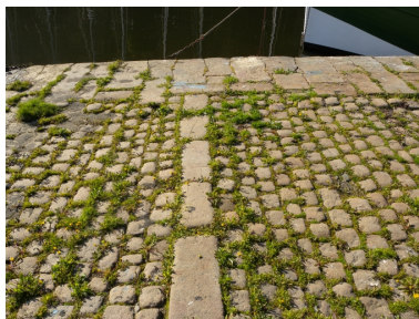
Vue de l'agencement des pavés en granite de la cale d'aval Phot. Guy Prigent IVR53_20082213000NUCA
