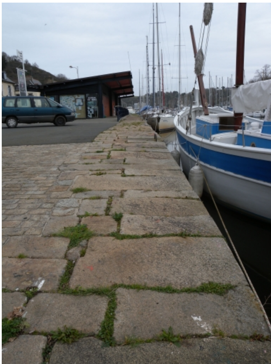
Vue de l'agencement des dalles de granite du quai d'Aiguillon
