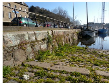
Vue des pavés de granite qui recouvrent la cale d'aval Phot. Guy Prigent IVR53_20082212998NUCA
