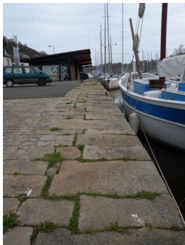
Vue de l'agencement des dalles de granite du quai d'Aiguillon Phot. Guy Prigent IVR53_20082212999NUCA
