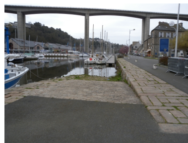
Vue de la vieille cale d'amont du quai d'Aiguillon Phot. Guy Prigent IVR53_20082212993NUCA
