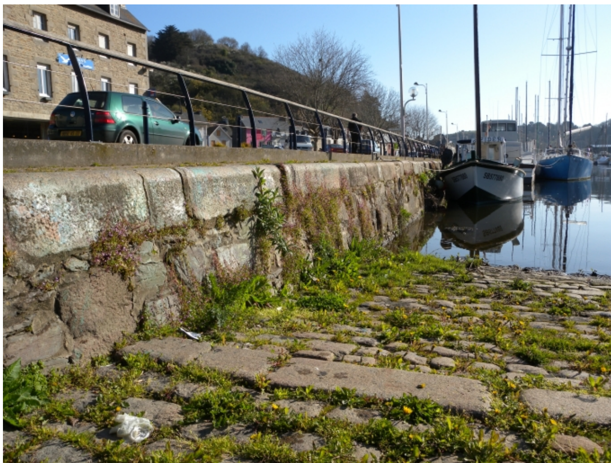
Vue des pavés de granite qui recouvrent la cale d'aval
