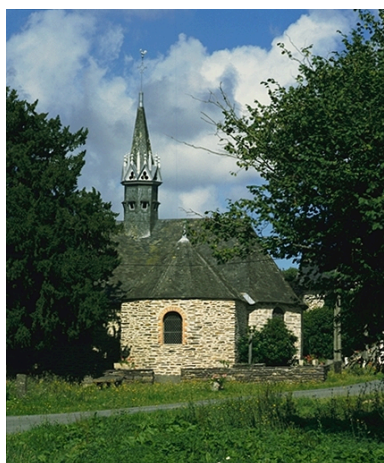
Vue générale sud Phot. Guy Artur, Phot. Norbert Lambart IVR53_19993500683XA
