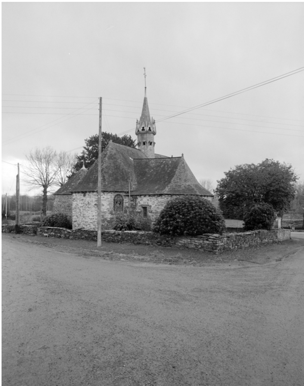
Vue de situation nord-est
