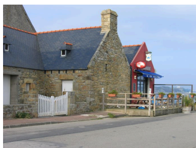
Vue latérale de l'Hôtel de la Terrasse Phot. Françoise Péron IVR53_20062908552NUCA
