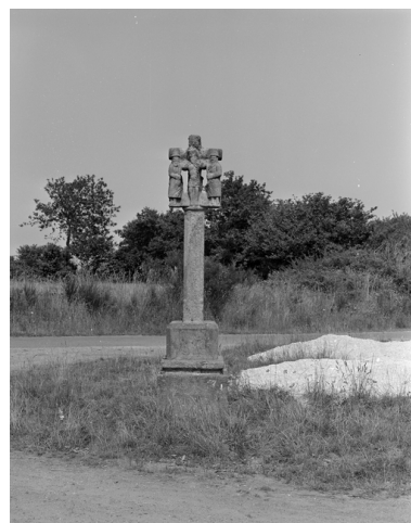
Vue générale nord Phot. François Dagorn IVR53_19752200561X
