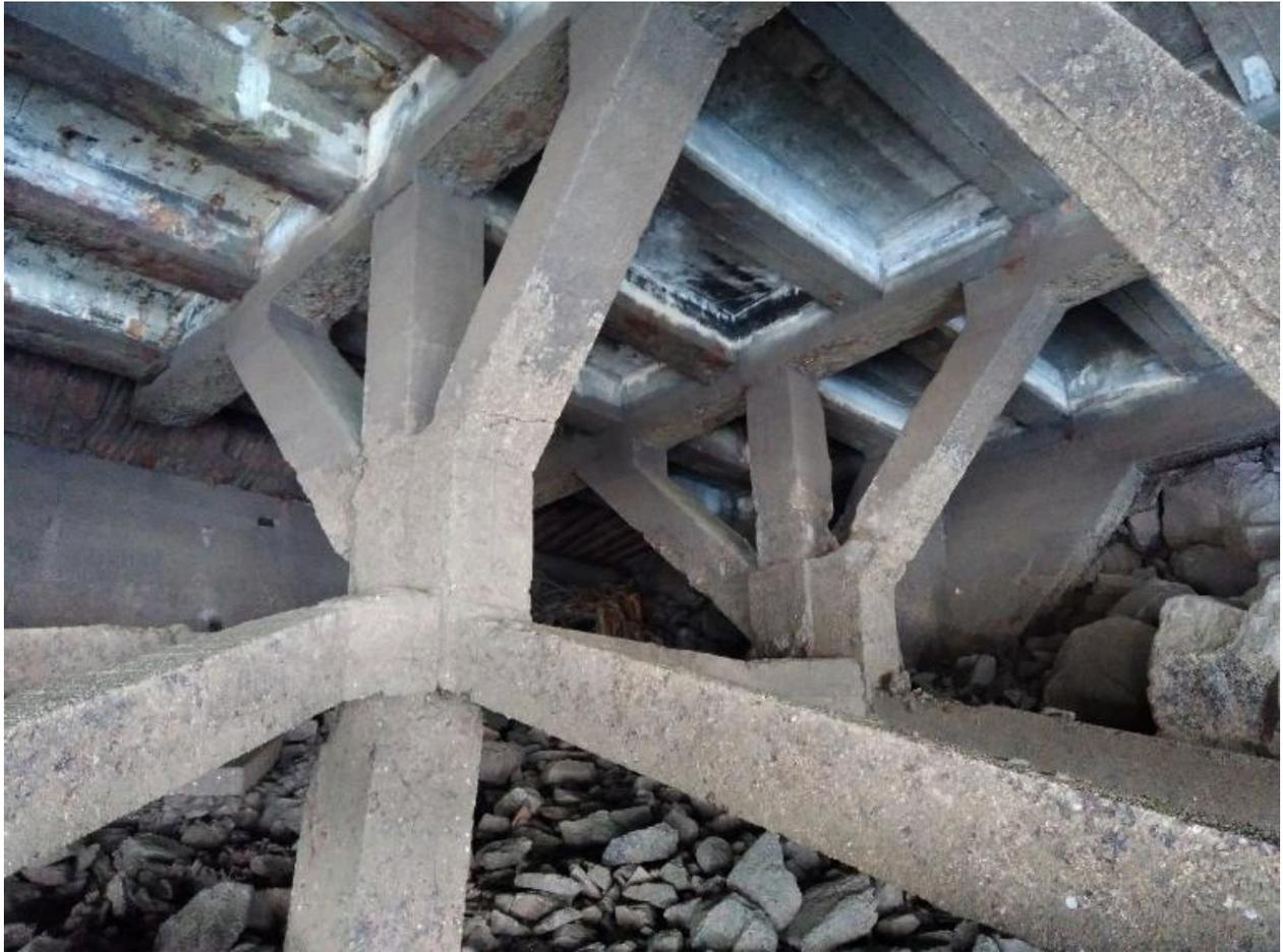
Treillis ou claire-voie en béton armé
