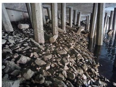
Pieux octogonaux en béton armée, talus en enrochement
