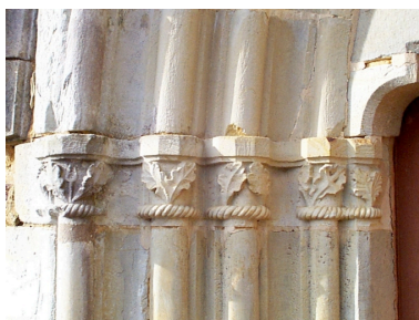
Chapiteaux du vieux porche : détail Phot. Xavier Gilbert IVR53_19993503326NUCA
