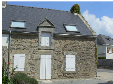
Vue générale de la maison de pêcheur du 4 rue de la Pointe du Bill Phot. Johan Vincent IVR53_20075605703NUCA
