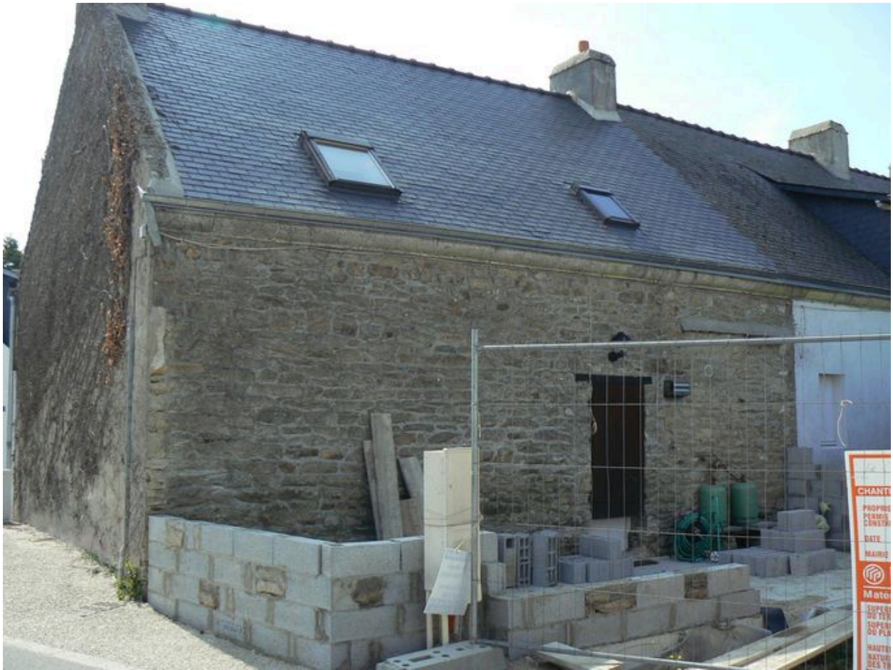
Vue arrière de la maison de pêcheur du 4 rue de la Pointe du Bill
