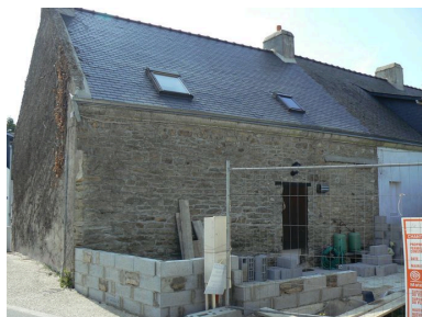
Vue arrière de la maison de pêcheur du 4 rue de la Pointe du Bill Phot. Johan Vincent IVR53_20075605702NUCA
