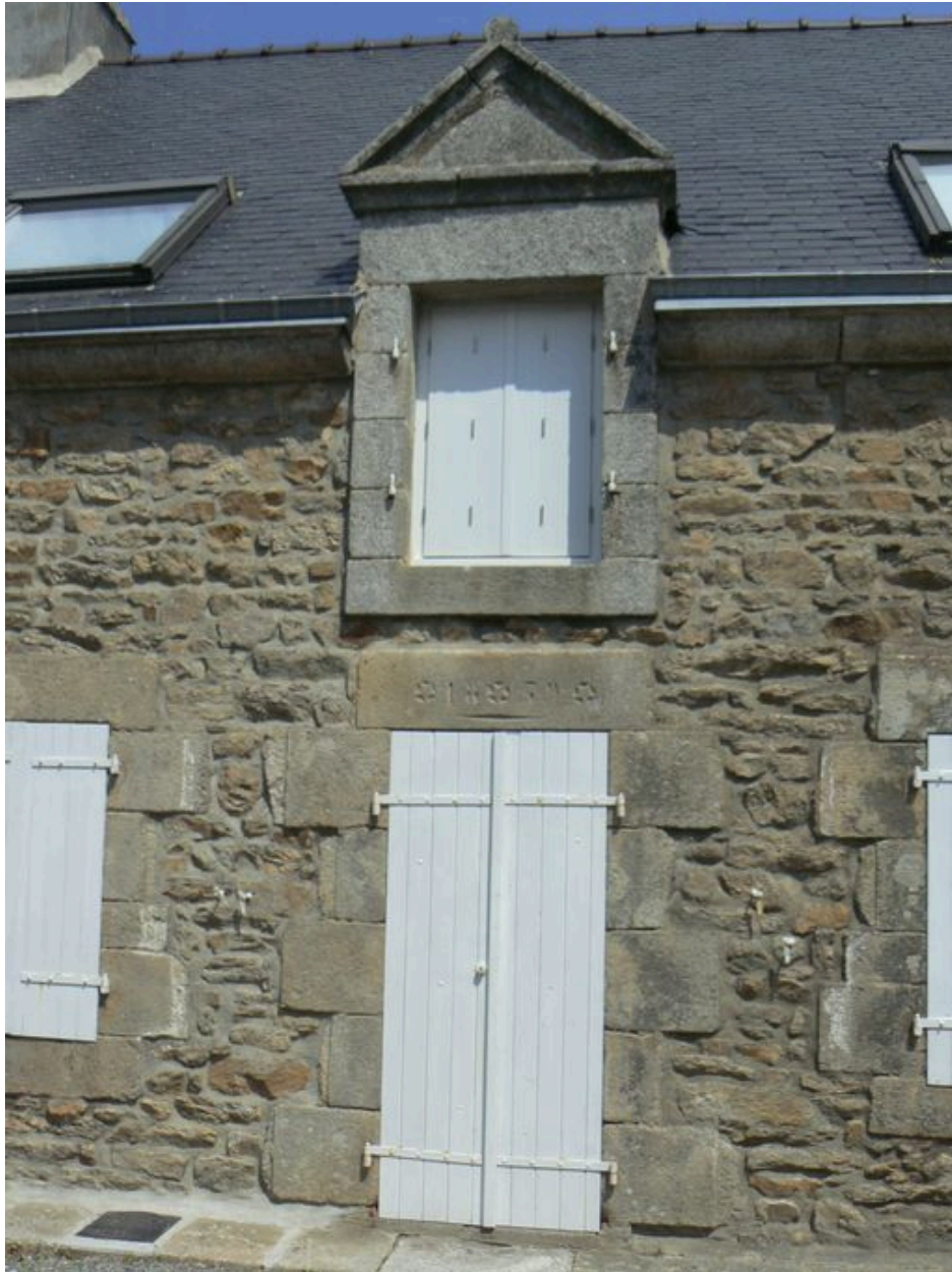
Maison de pêcheur du 4 rue de la Pointe du Bill
