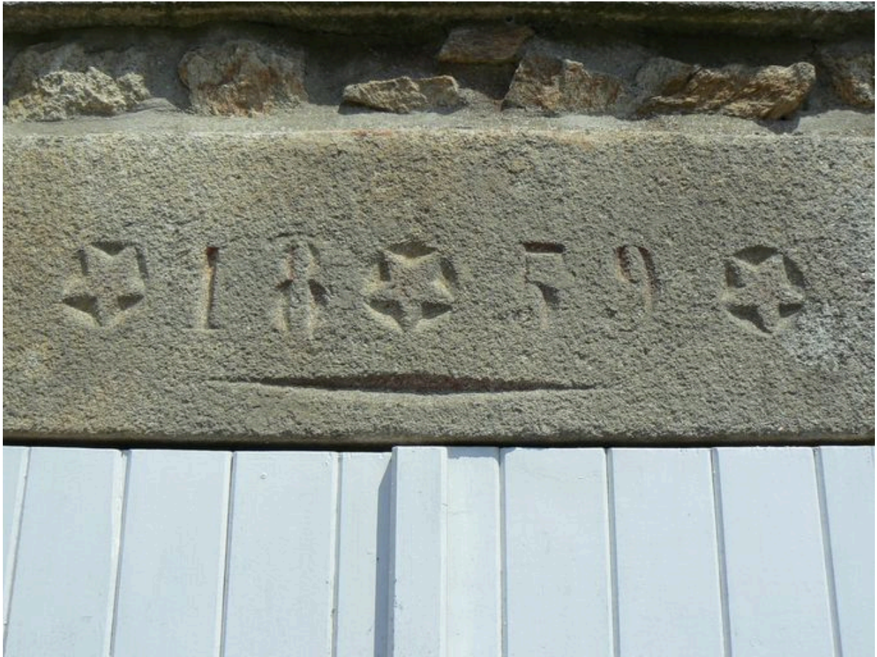
Détail de la maison de pêcheur du 4 rue de la Pointe du Bill
