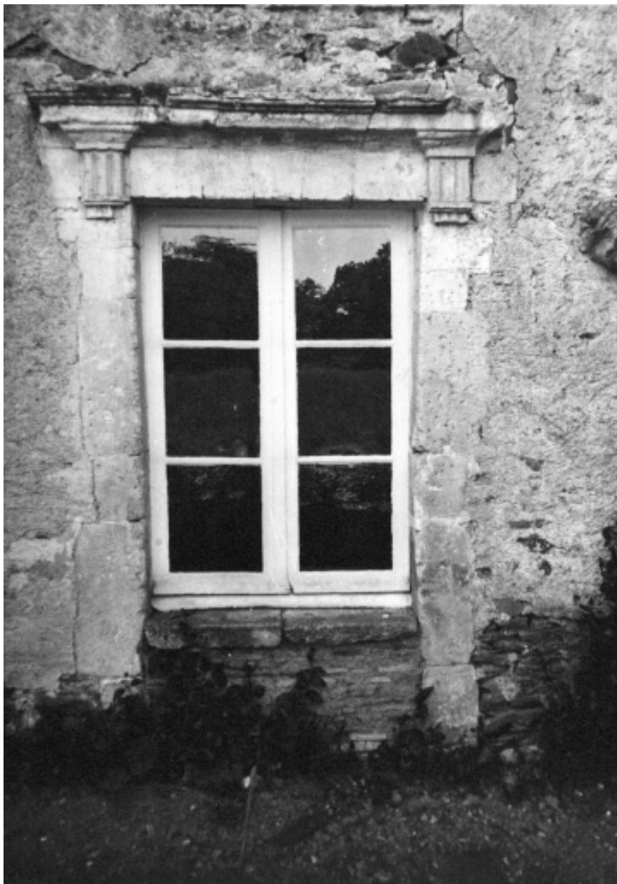
Tour, façade ouest : porte partiellement murée
