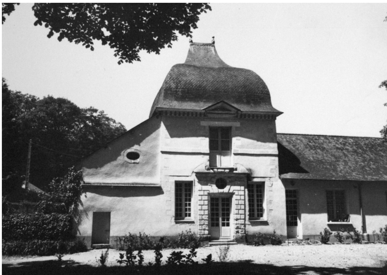
Pavillon isolé : façade est (état en 1974)
