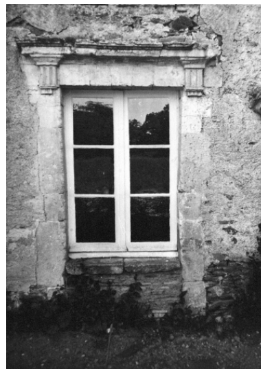
Tour, façade ouest : porte partiellement murée Phot. Jeannik Le Goux IVR53_19743500629Z
