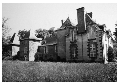
Façade ouest Phot. Jeannik Le Goux IVR53_19743500626Z
