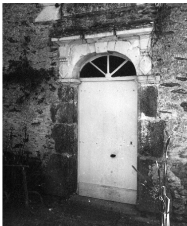
Tour ; façade ouest, porte Phot. Jeannik Le Goux IVR53_19743500628Z
