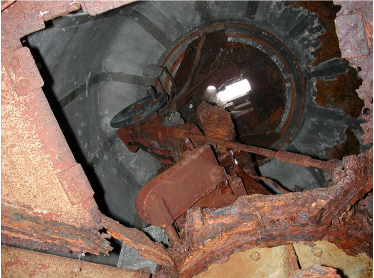
Vue du bunker de type 633 pour mortier (M19) du parc à carburant de Maison Blanche : cloche blindée, affût du mortier automatique
