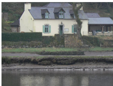
Vue générale de l'ancienne maison du passeur de Saint-Maurice Phot. Julien Amghar IVR53_20082908672NUCA
