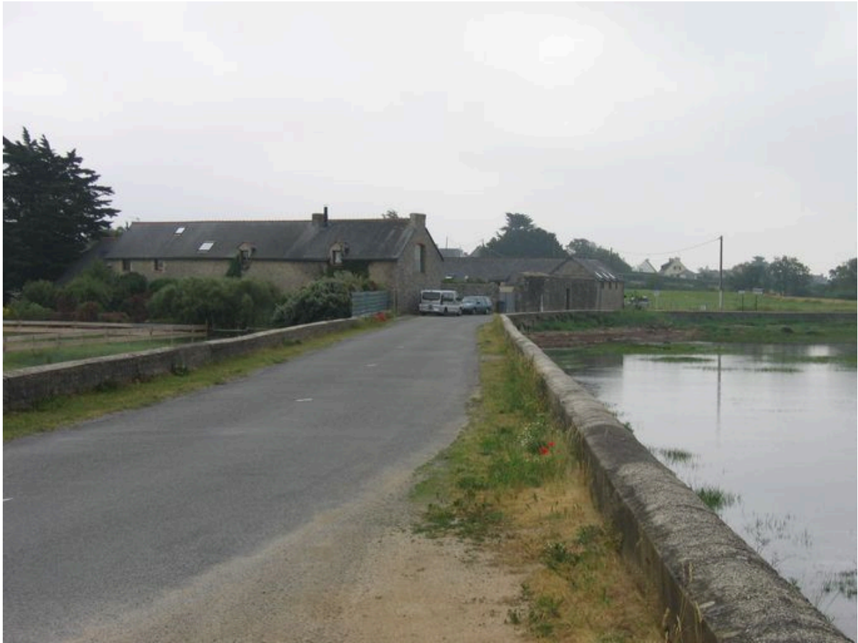
Vue générale de la digue-route d'Herbon
