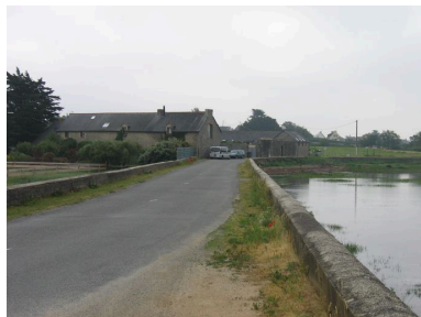
Vue générale de la digue-route d'Herbon Phot. Françoise Péron IVR53_20075605699NUCA
