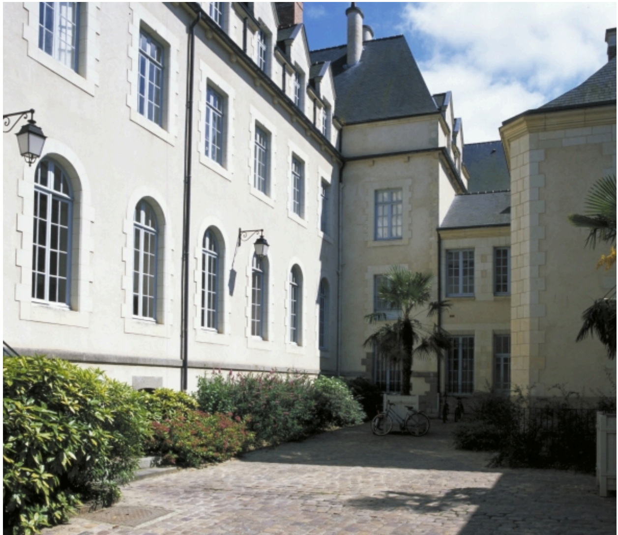
Vue sur cour intérieure
