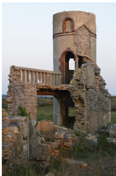
Vue d'une tourelle Phot. Bernard Bègne IVR53_20102900182NUCA
