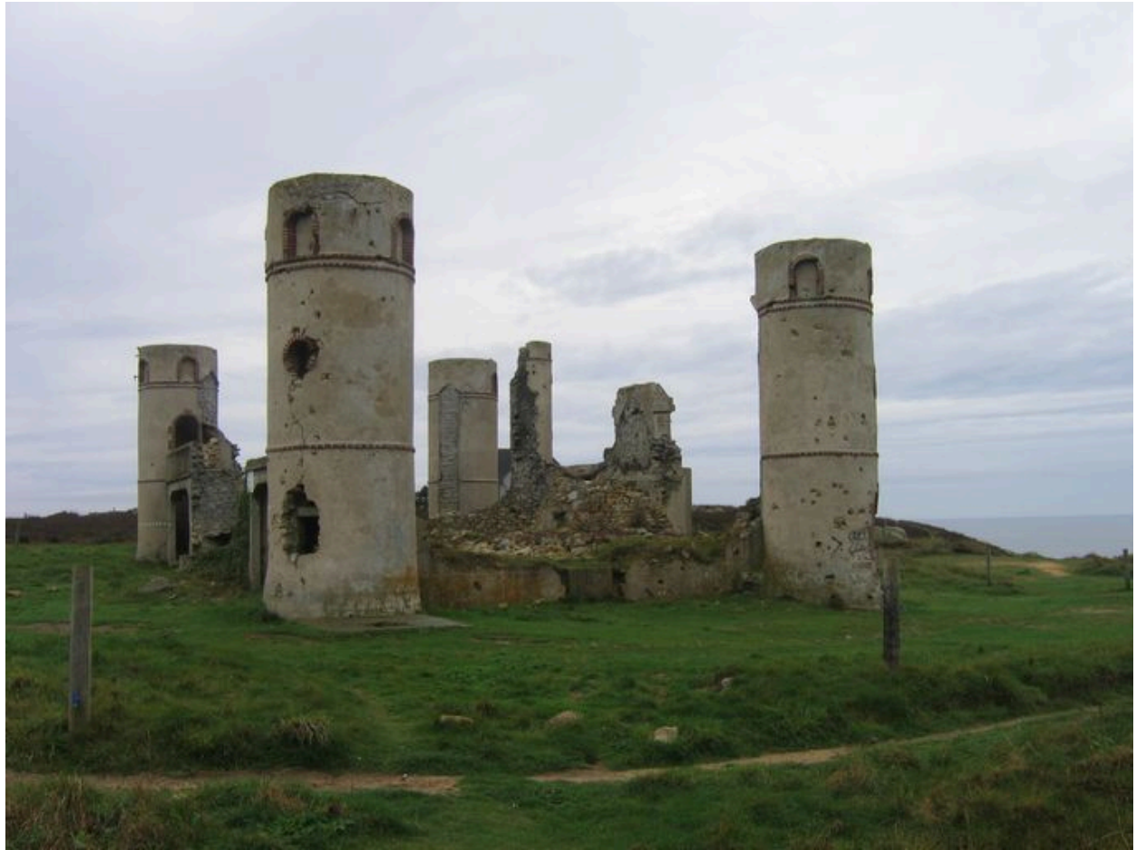
Vue latérale nord des vestiges du manoir de Boul tous
