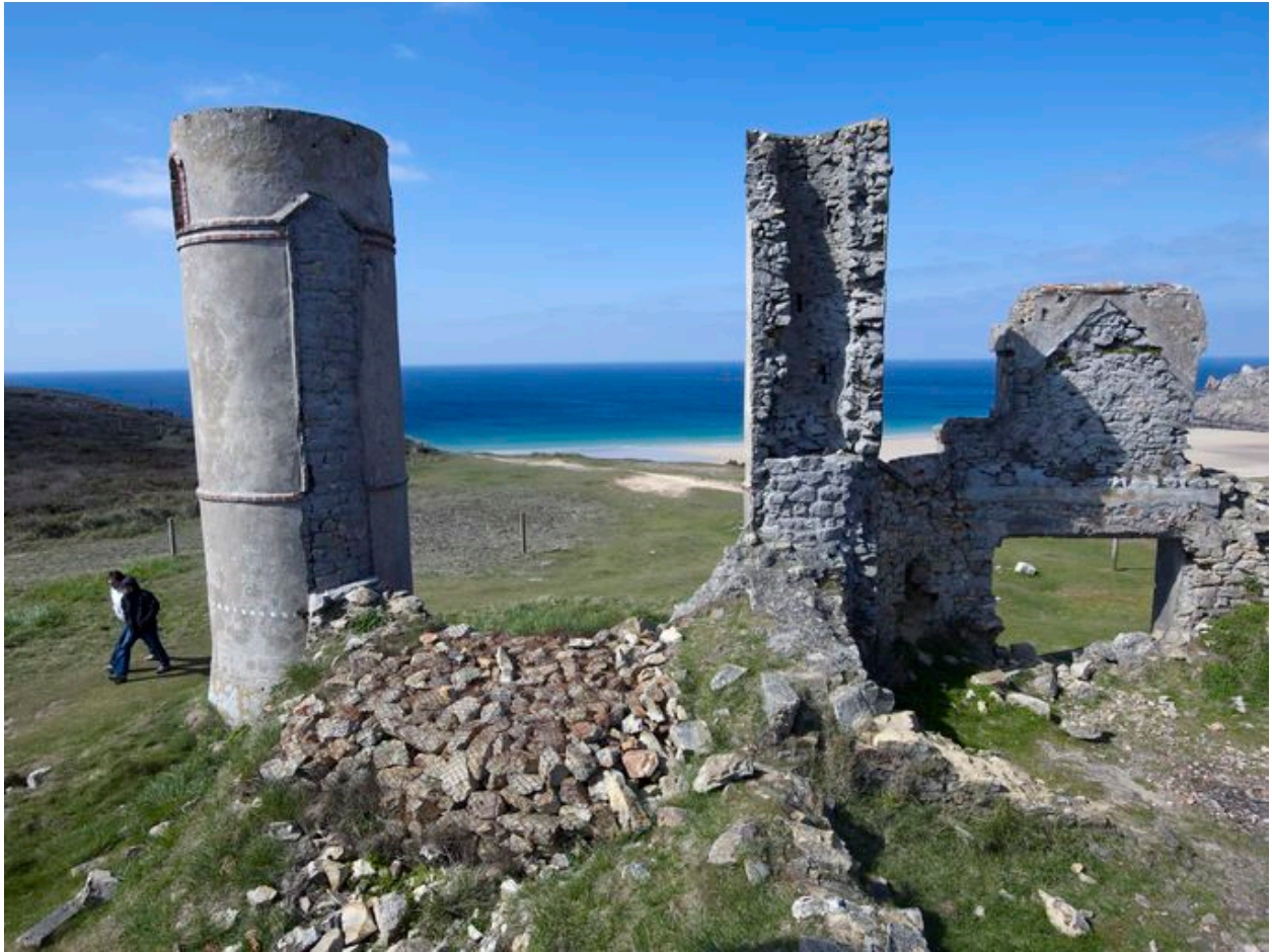
Vue des vestiges du revers de la façade ouest
