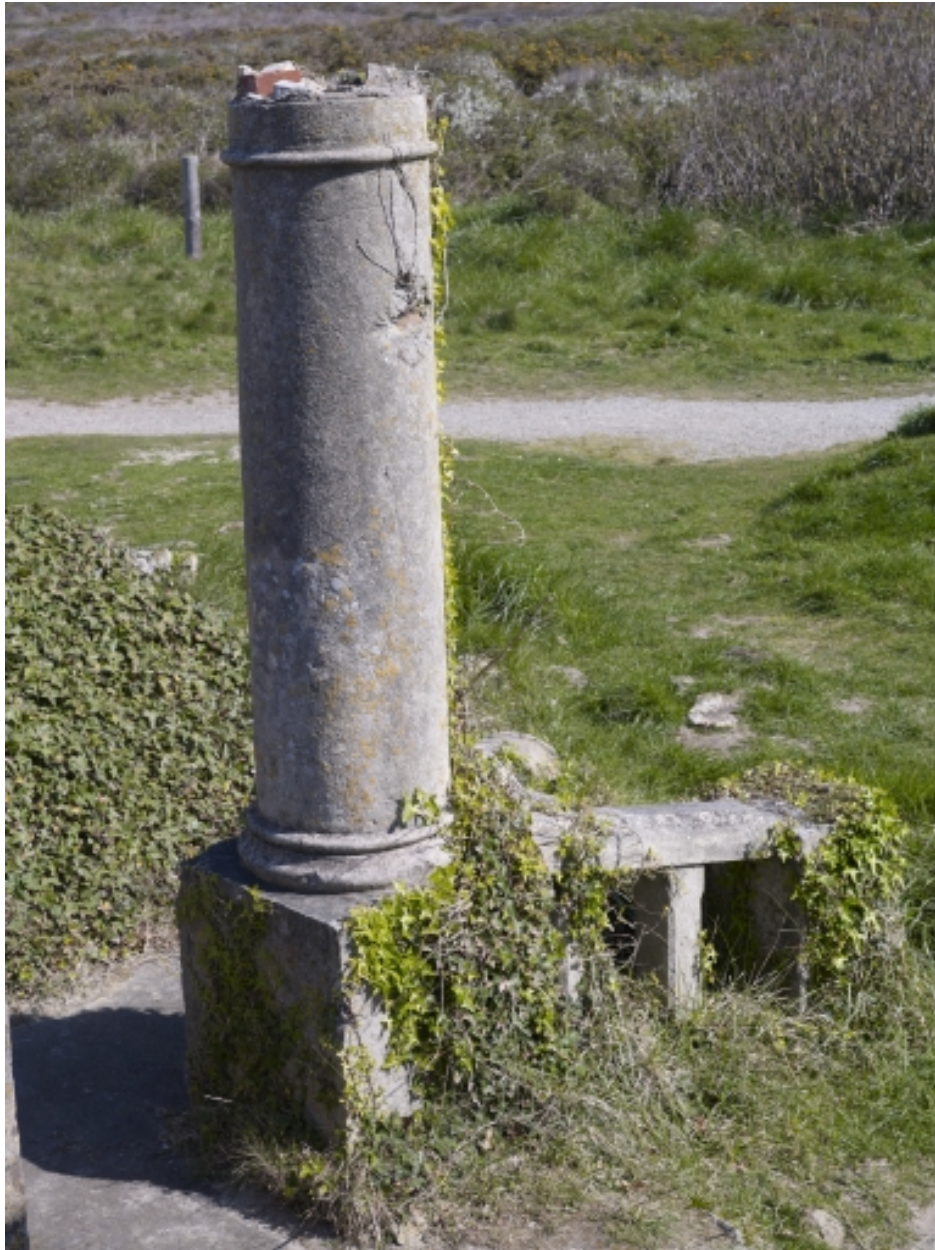
Détail d'une colonne de l'ancien porche de la façade est
