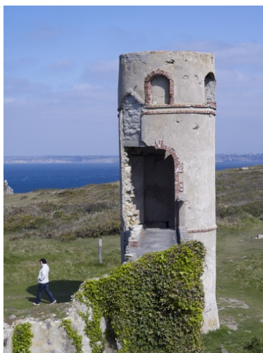
Détail d'une tourelle Phot. Bernard Bègne IVR53_20122900444NUCA
