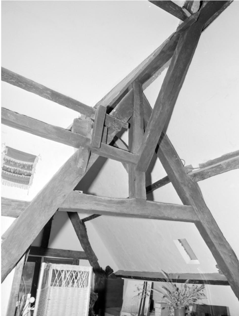
Charpente, ferme intermédiaire avec noe du toit perpendiculaire (1978).
