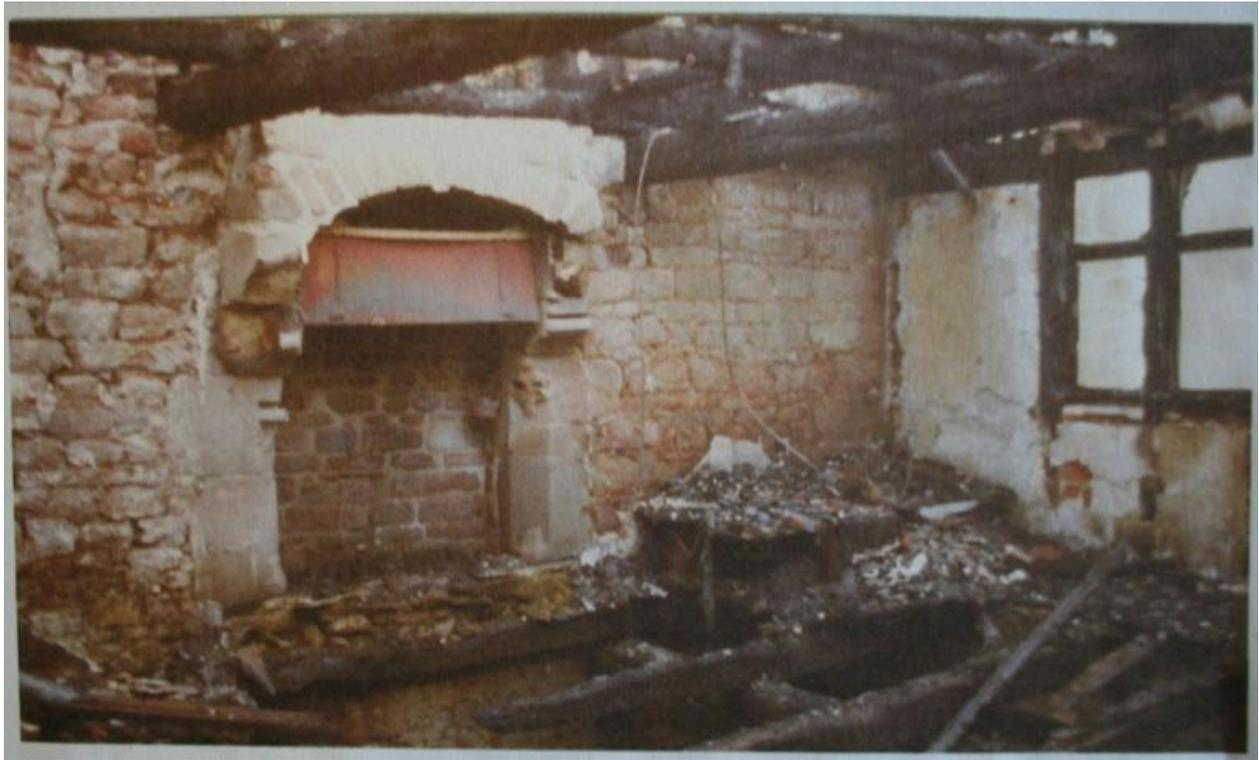
L'incendie a détruit les charpentes et poutraisons, ainsi qu'une partie de la cheminée maçonnée.
