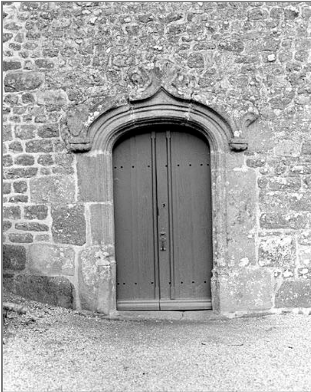
Elévation Sud, porte Est : vue générale
