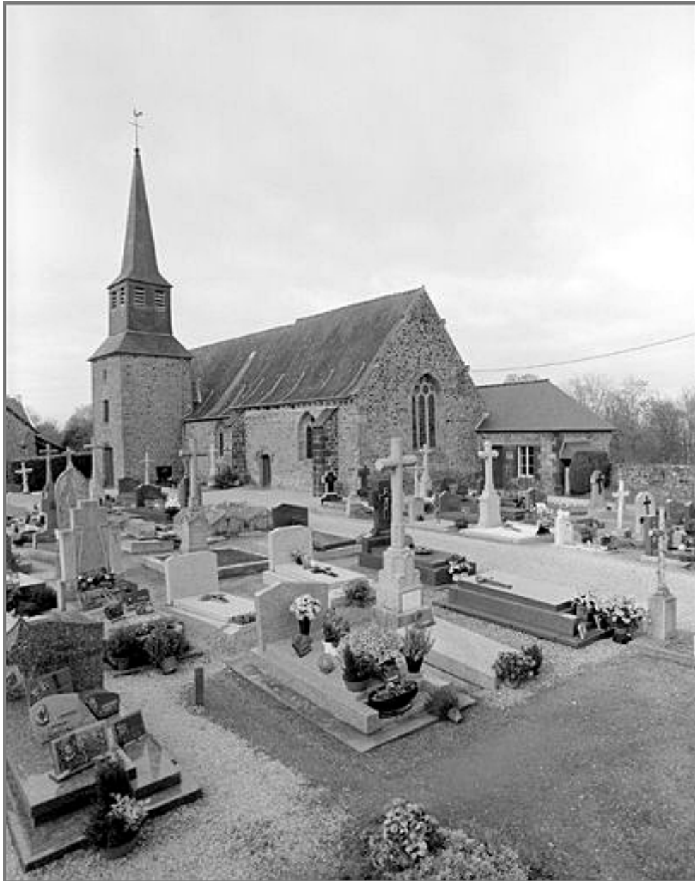
Elévation Sud-Est : vue générale
