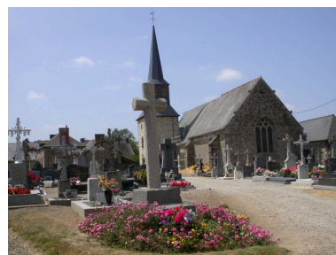
Vue générale sud-est Phot. Stéphanie Ménard IVR53_20053518509NUCA
