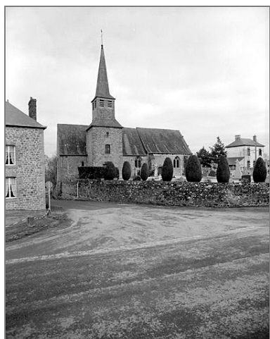
Elévation Sud-Ouest : vue générale Phot. Bernard Bègne, Phot. M. Loyon IVR53_19943500029X
