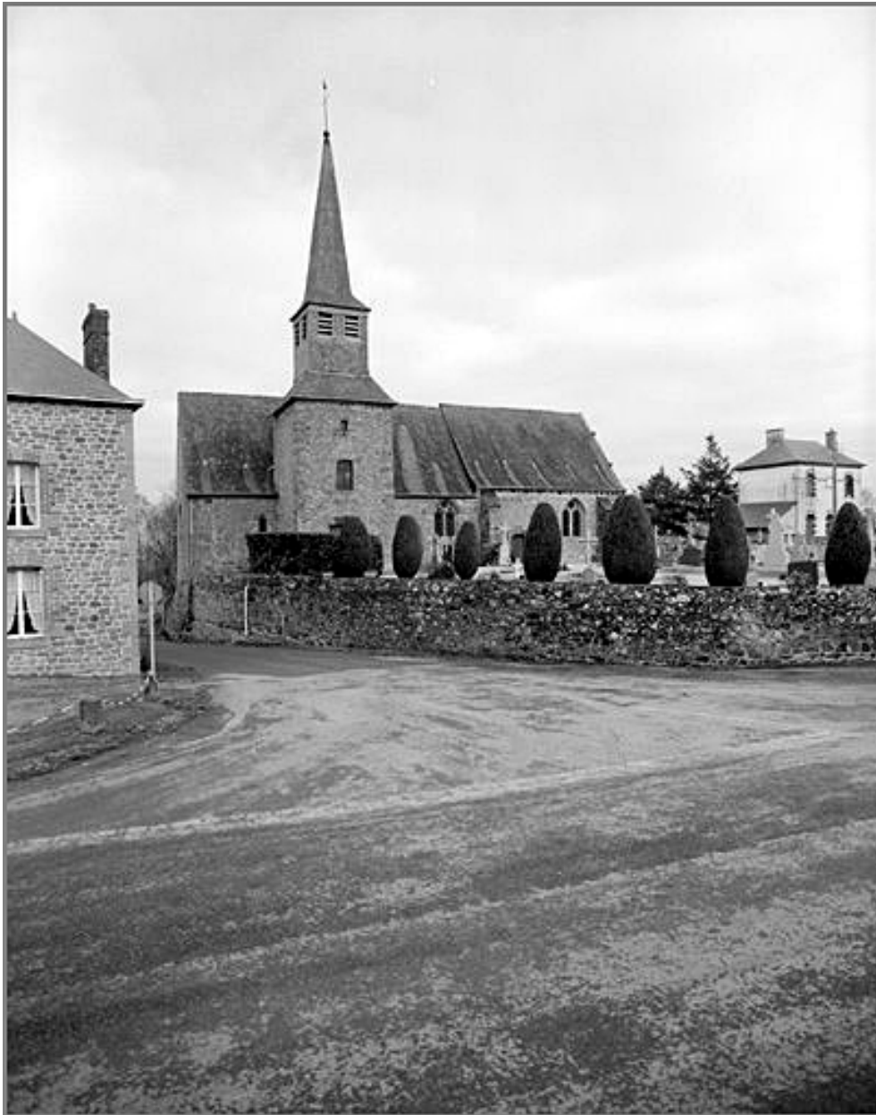
Elévation Sud-Ouest : vue générale
