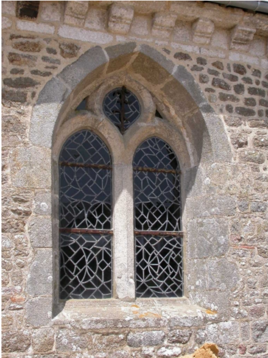
Détail d'une fenêtre du sud
