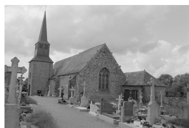
Vue générale sud-est Phot. J. R. Trochet IVR53_19753500954Z
