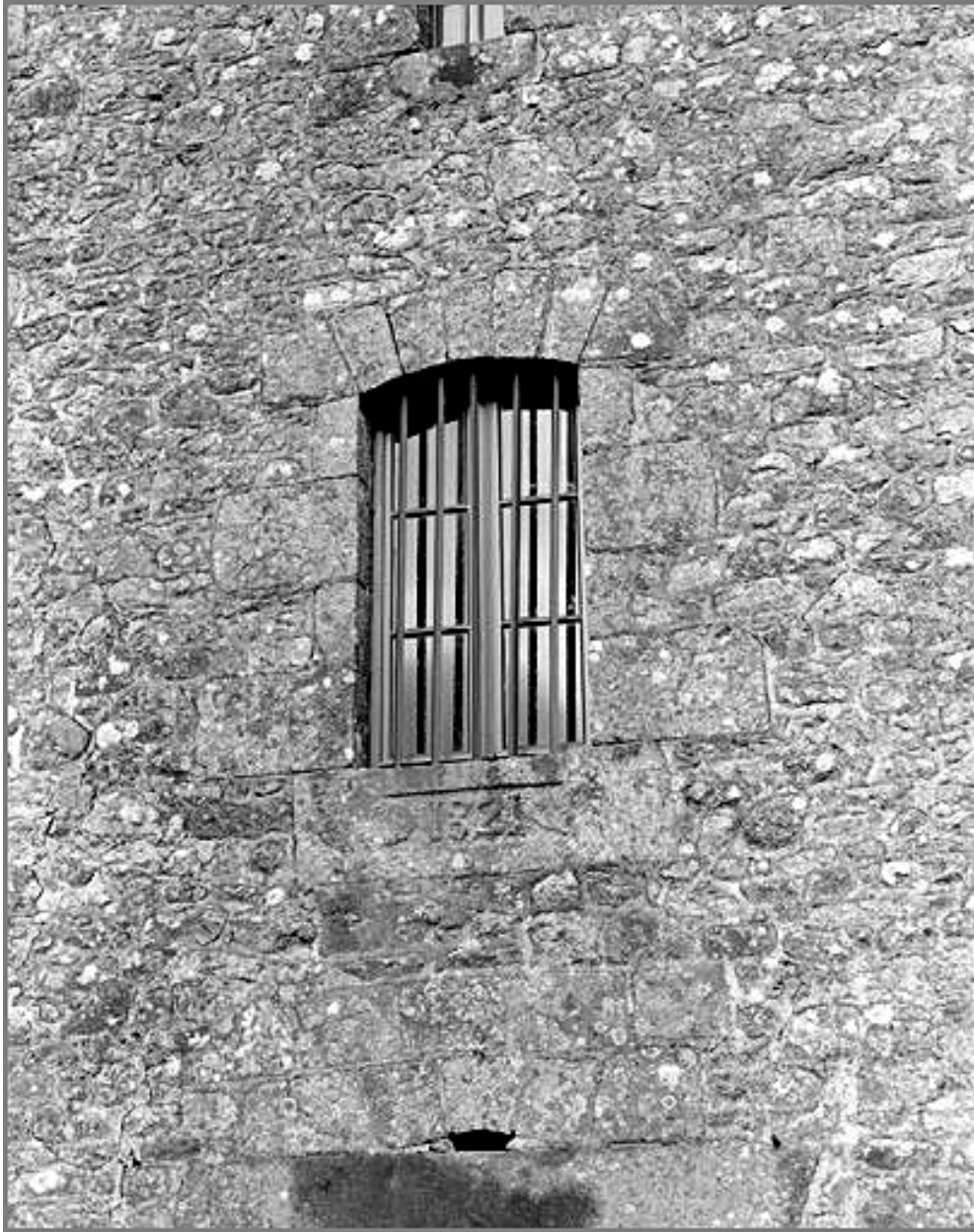
Elévation Sud, clocher, premier étage, fenêtre : vue générale
