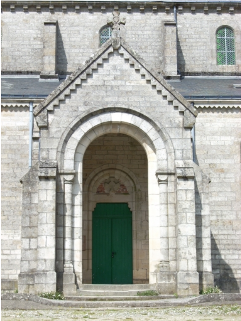
Scaër, église paroissiale Sainte-Candide : détail porche sud
