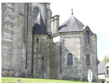
Scaër, église paroissiale Sainte-Candide : sacristie : vue générale sud-est Phot. Gwénaél Fauchille IVR53_20082905526NUCA
