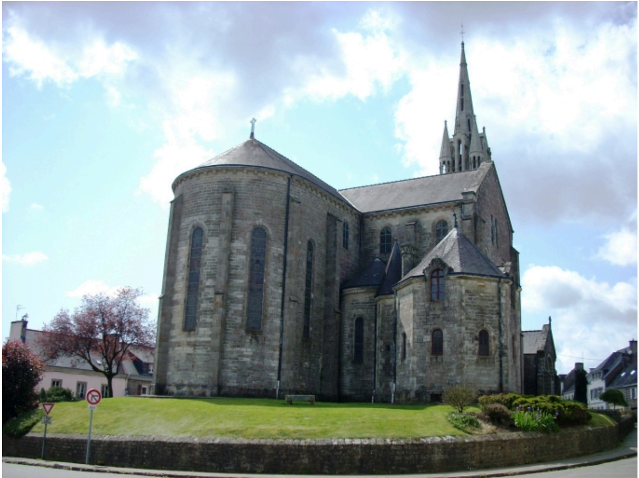
Scaër, église paroissiale Sainte-Candide : vue générale nord-est
