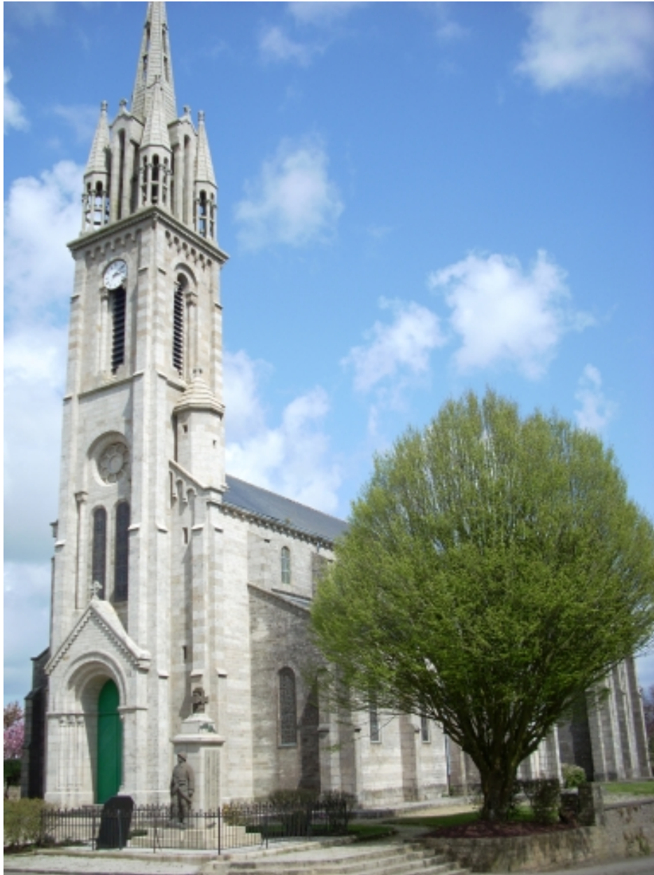
Scaër, église paroissiale Sainte-Candide : vue générale sud-ouest
