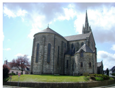
Scaër, église paroissiale Sainte-Candide : vue générale nord-est Phot. Gwénaél Fauchille IVR53_20082905524NUCA
