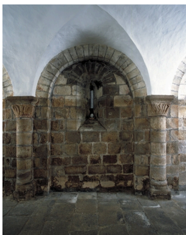
Quimperlé, église paroissiale Sainte-Croix : crypte, mur sud, partie centrale, état en 2002 Phot. Bernard Bègne
