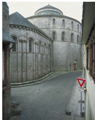
Quimperlé, église paroissiale Sainte-Croix : vue générale nord-est, état en 2001 Phot. Bernard Bègne IVR53_20012900327XA
