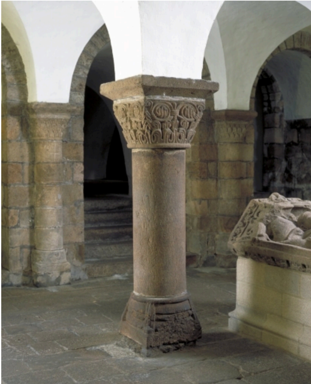
Quimperlé, église paroissiale Sainte-Croix : crypte, travée sud, pilier ouest, état en 2002
