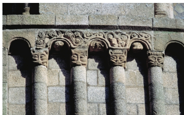
Quimperlé, église paroissiale Sainte-Croix : élévation nord-ouest, détail, état en 2002 Phot. Bernard Bègne IVR53_20022900508XA
