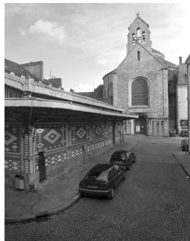
Quimperlé, église paroissiale Sainte-Croix : élévation ouest, état en 2000 Phot. Bernard Bègne IVR53_20002900747X
