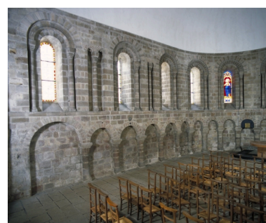
Quimperlé, église paroissiale Sainte-Croix : chœur, vue nord-est, état en 2002 Phot. Bernard Bègne IVR53_20022900144XA
