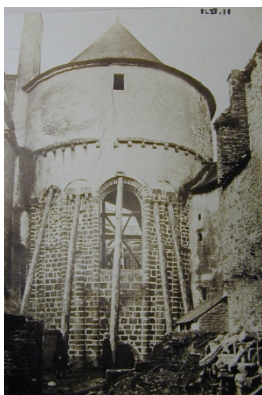
Quimperlé, église paroissiale Sainte-Croix : élévation est de l'abside du choeur après le sinistre de 1862. Photographie de Villard (A.E. Quimper, Fonds Bigot), reproduction de 2004 Repro. Christel Douard, Autr. Archives de l'Evêché de Quimper IVR53_20042903264NUC
