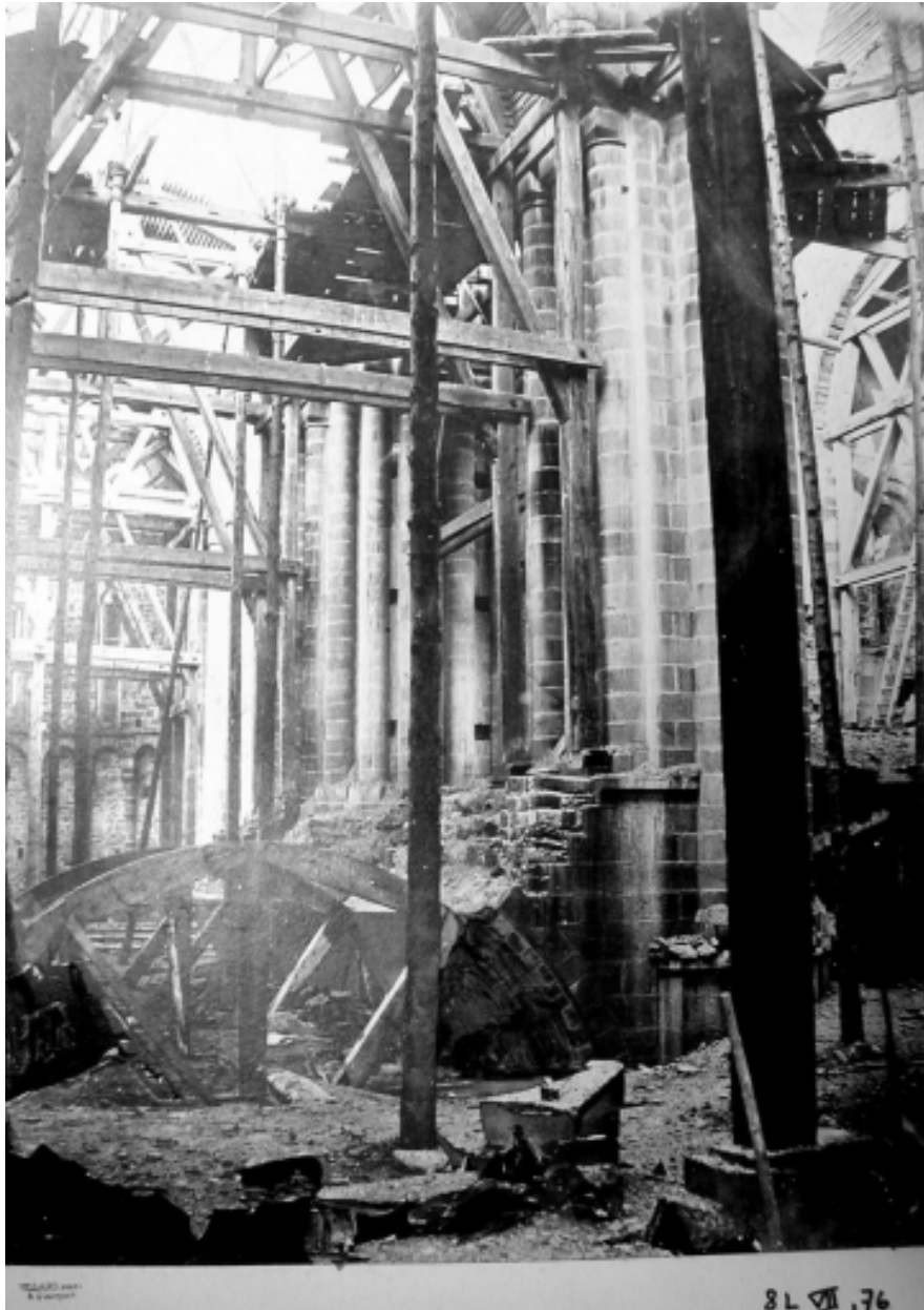
Quimperlé, église paroissiale Sainte-Croix : vue d'intérieure après le sinistre de 1862. (A.E. Quimper, Fonds Bigot), reproduction de 2004
