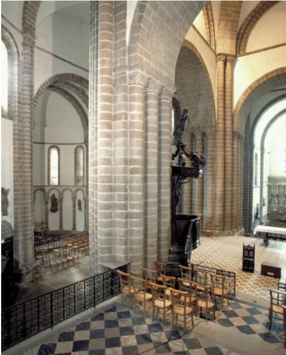
Quimperlé, église paroissiale Sainte-Croix : vue depuis la croisée vers le sud et l'ouest, état en 2002
