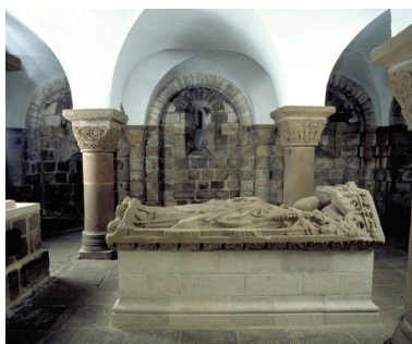
Quimperlé, église paroissiale Sainte-Croix : crypte, vue vers le sud, état en 2002 Phot. Bernard Bègne IVR53_20022900172XA
