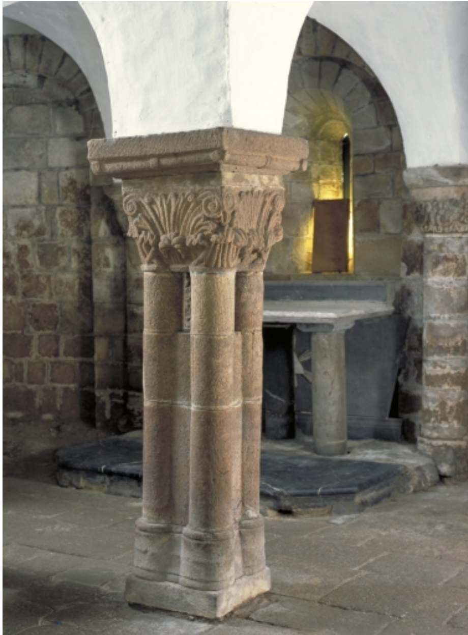
Quimperlé, église paroissiale Sainte-Croix : crypte, pilier sud-est, état en 2002
