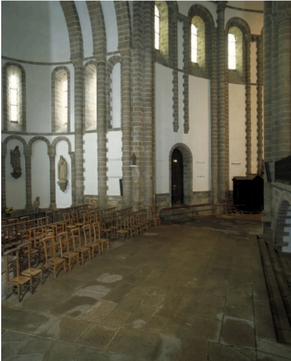
Quimperlé, église paroissiale Sainte-Croix : bas-côté nord, état en 2002
