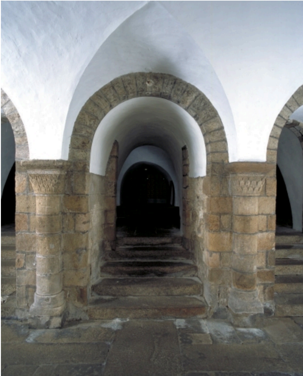
Quimperlé, église paroissiale Sainte-Croix : crypte, travée centrale et mur ouest avec accès, état en 2002
