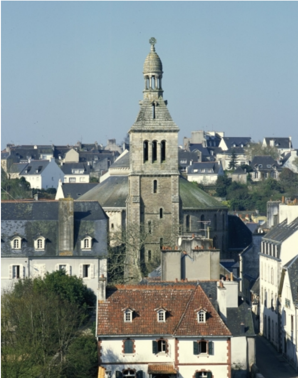
Quimperlé, église paroissiale Sainte-Croix : vue de situation nord avec le clocher isolé, état en 2002
