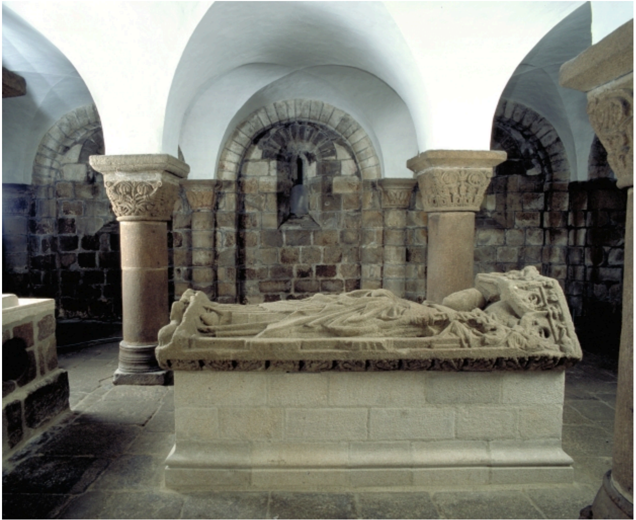
Quimperlé, église paroissiale Sainte-Croix : crypte, vue vers le sud, état en 2002
