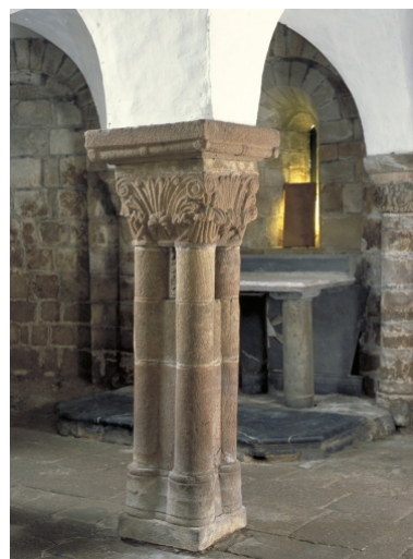
Quimperlé, église paroissiale Sainte-Croix : crypte, pilier sud-est, état en 2002 Phot. Bernard Bègne IVR53_20022900165XA
