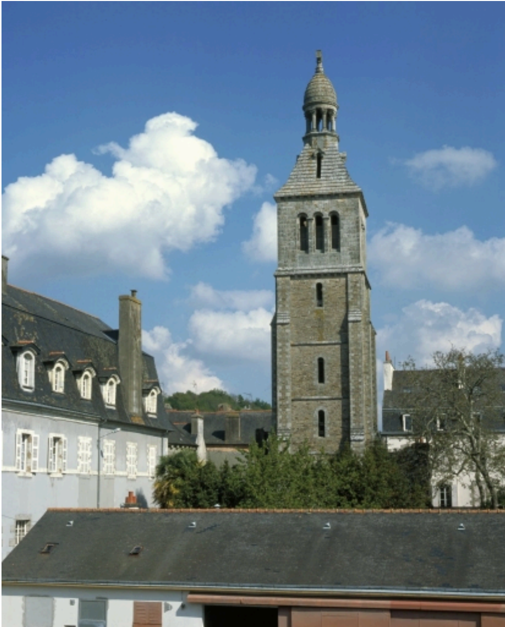
Quimperlé, église paroissiale Sainte-Croix : clocher isolé, élévation sud, état en 2002
