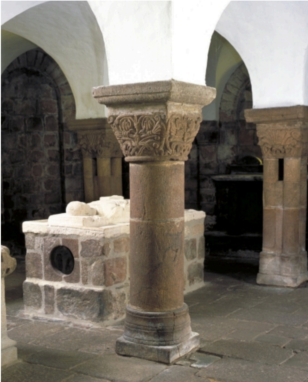
Quimperlé, église paroissiale Sainte-Croix : crypte, travée sud, pilier central, état en 2002
