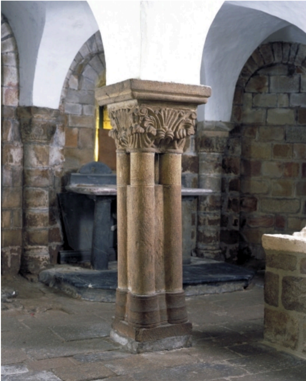
Quimperlé, église paroissiale Sainte-Croix : crypte, pilier nord-est, état en 2002
