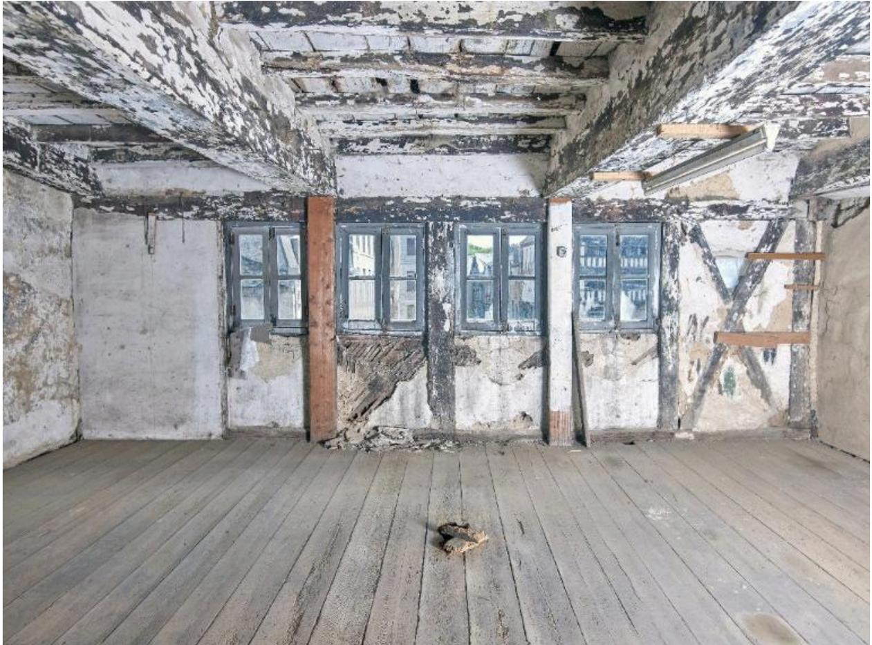
Second étage du bâtiment sur rue : les poteaux soutiennent une sablière sur laquelle reposent les poutres dont le débord crée l'encorbellement.
