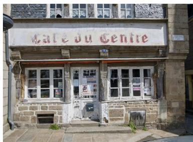
Des poteaux de bois moulurés soutiennent l'encorbellement du premier étage. Le mur-bahut maçonné a été repris.
