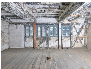
Second étage du bâtiment sur rue : les poteaux soutiennent une sablière sur laquelle reposent les poutres dont le débord crée l'encorbellement.
