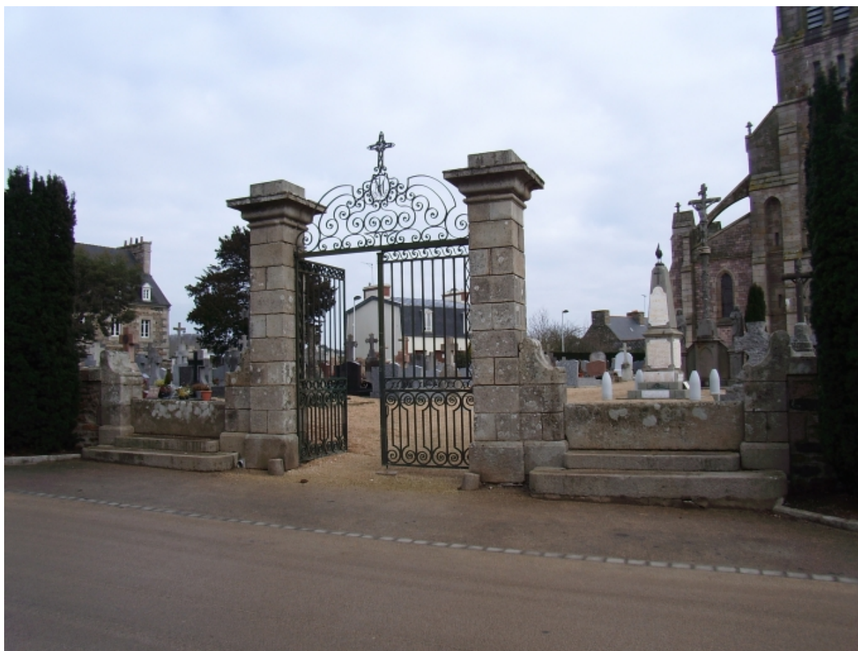
Vue générale (situation)
