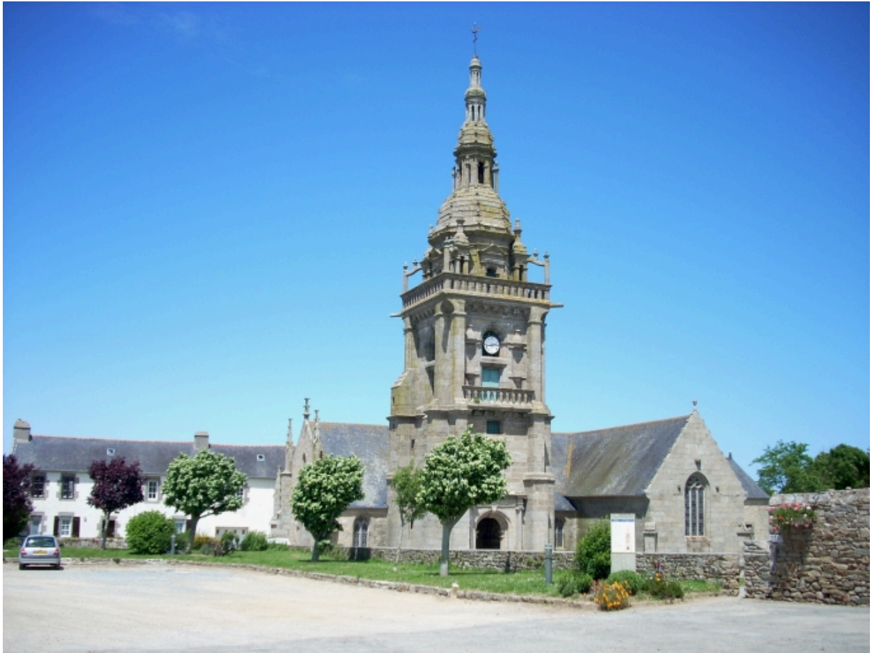
Lampaul-Ploudalmézeau, église paroissiale : vue générale sud-ouest
