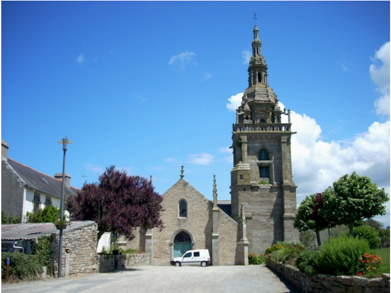
Lampaul-Ploudalmézeau, église paroissiale : élévation ouest
