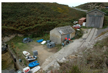
Port-abri du Stiff, la station de sauvetage, cale et terre-plein Phot. Guillaume Lécueillier IVR53_20062903525NUCA
