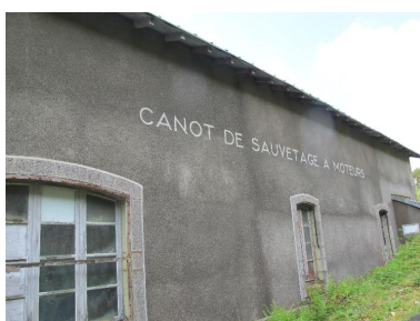
Inscription portée sur la station de sauvetage du Stiff : canot de sauvetage à moteurs Phot. Erwana L'Haridon IVR53_20152905342NUCA
