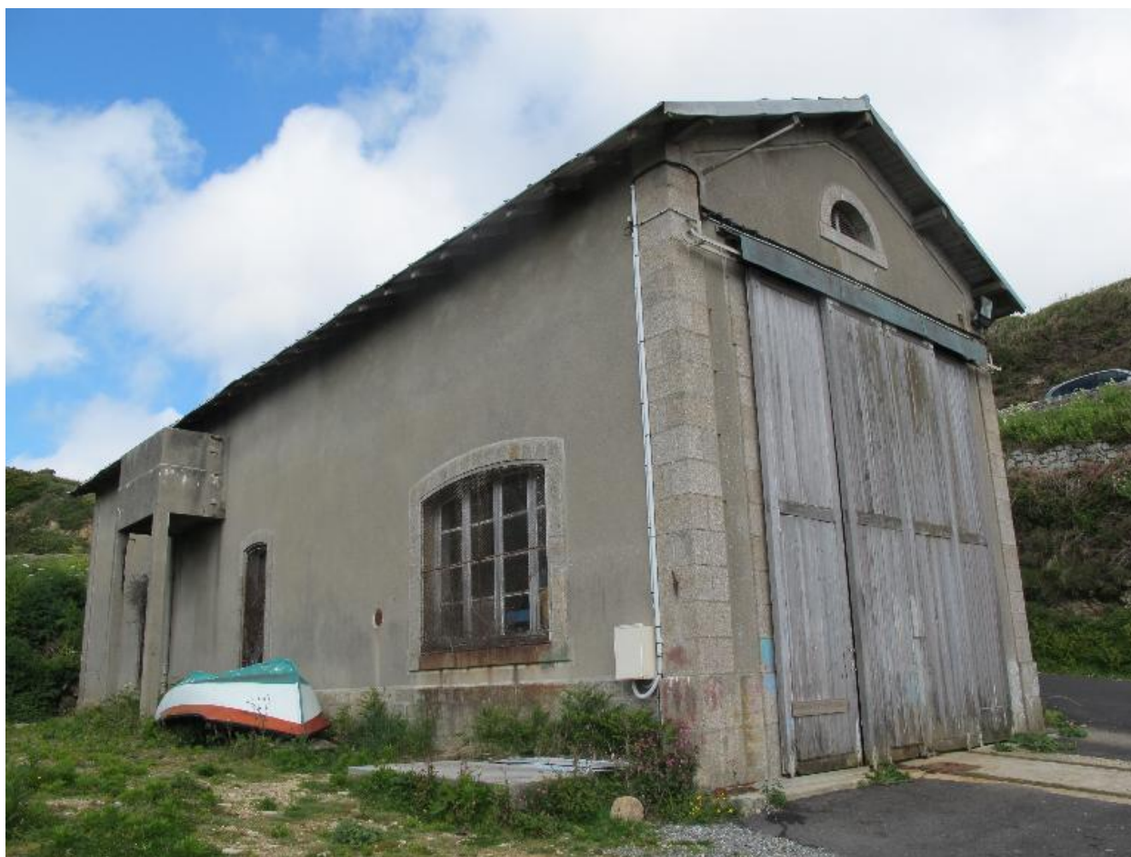
Station de sauvetage n°2 du port du Stiff
