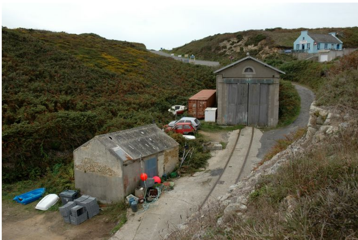
Vue du port-abri du Stiff, la station de sauvetage et sa cale
