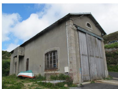
Station de sauvetage n°2 du port du Stiff Phot. Erwana L'Haridon IVR53_20152905341NUCA
