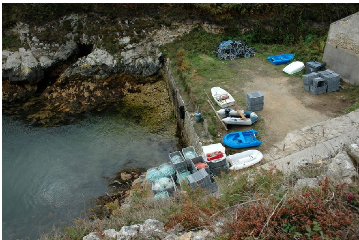
Port-abri du Stiff : terre-plein, digue de soutènement et cale de la station de sauvetage
