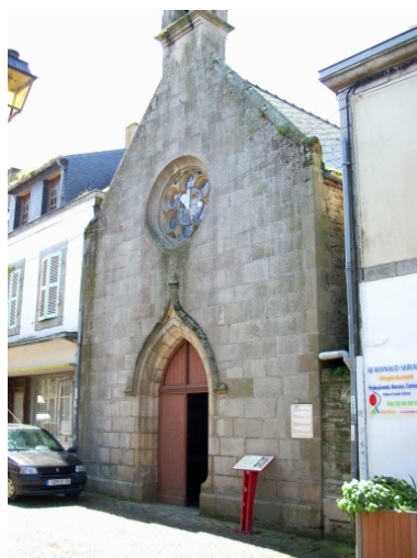
Carhaix, chapelle Sainte- Anne : vue générale nord-ouest Phot. Gwénaél Fauchille IVR53_20082905801NUCA
