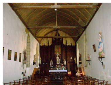
Carhaix, chapelle Sainte- Anne : vue axiale est Phot. Gwénaél Fauchille IVR53_20082905802NUCA
