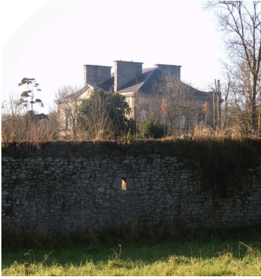
Vue générale (façade postérieure) Phot. Patrick Pichouron IVR53_20082206957NUCA
