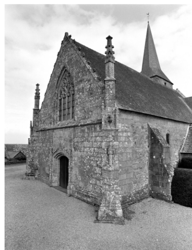
Vue générale ouest Phot. Guy Artur, Phot. Norbert Lambart IVR53_19943500754X
