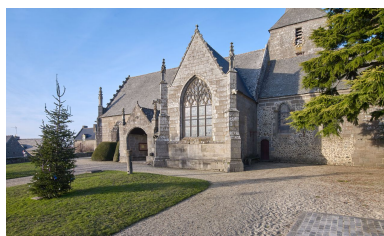
Façade sud depuis l'est Phot. Bernard Bègne IVR53_20223500055NUCA
