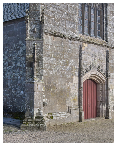
Contrefort nord ouest de l'église Phot. Bernard Bègne IVR53_20223500256NUCA
