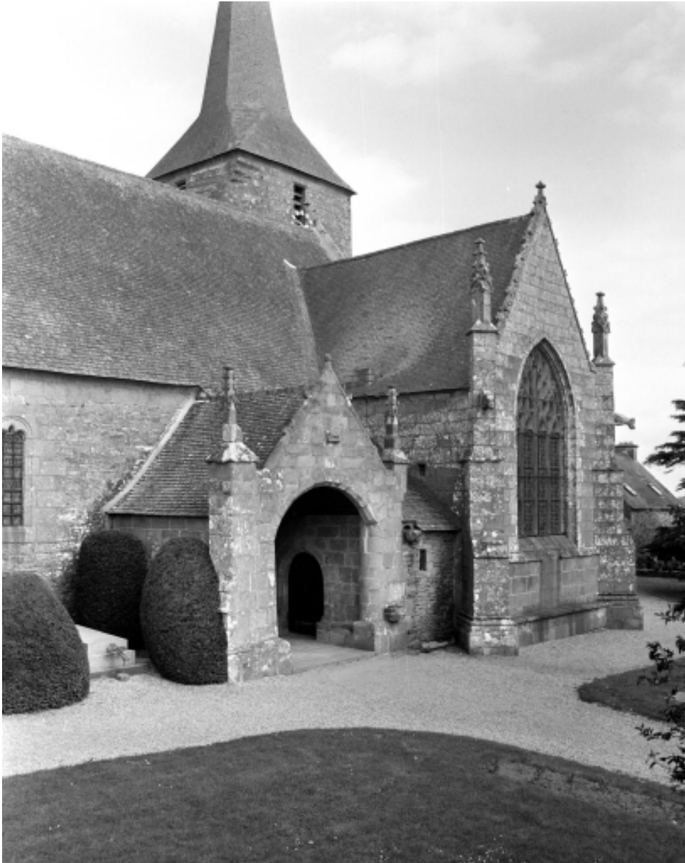
Vue partielle nord ouest
