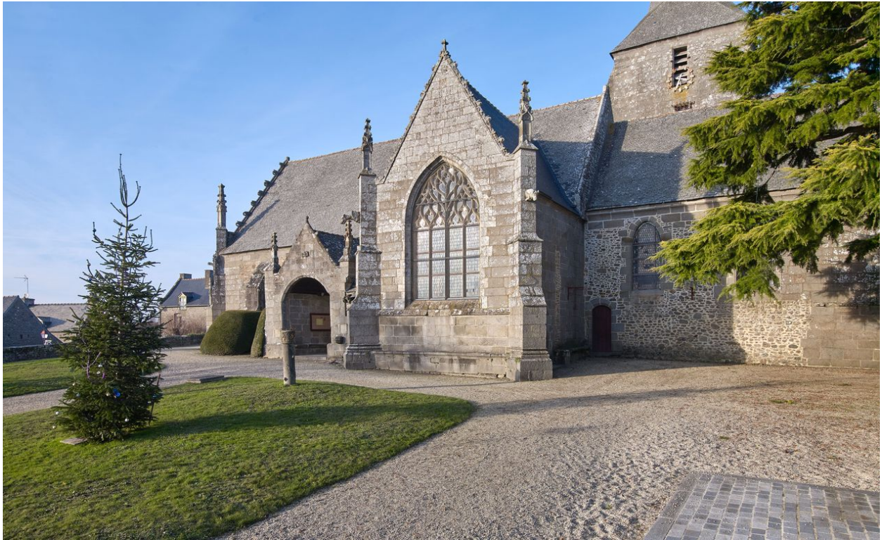
Façade sud depuis l'est
