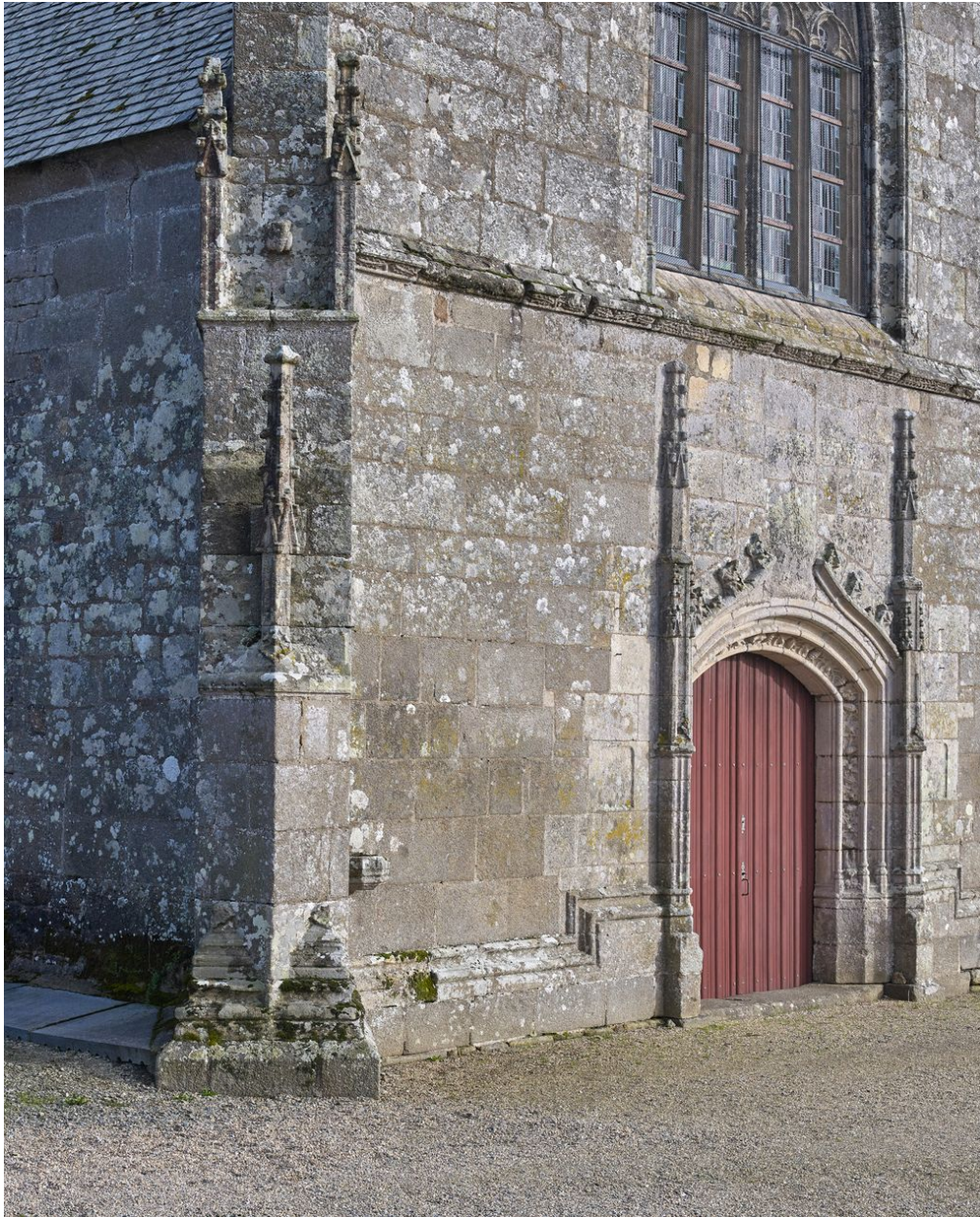
Contrefort nord ouest de l'église
