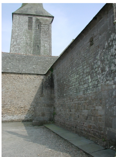
Vue partielle sud ouest Phot. Claude Quillivic IVR53_20013517923NUCA
