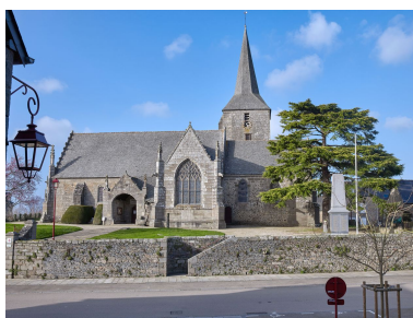
Vue générale sud Phot. Bernard Bègne IVR53_20223500251NUCA
