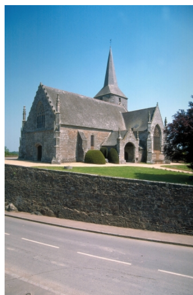
Vue générale sud ouest Phot. Claude Quillivic IVR53_19943502970ZA
