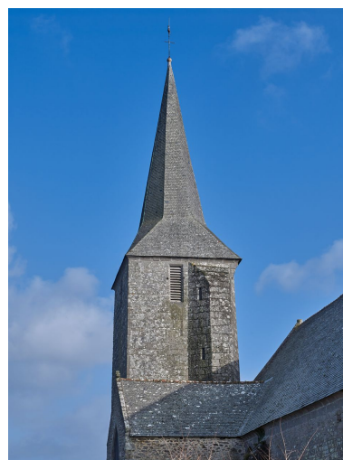
Tour du clocher Phot. Bernard Bègne IVR53_20223500248NUCA
