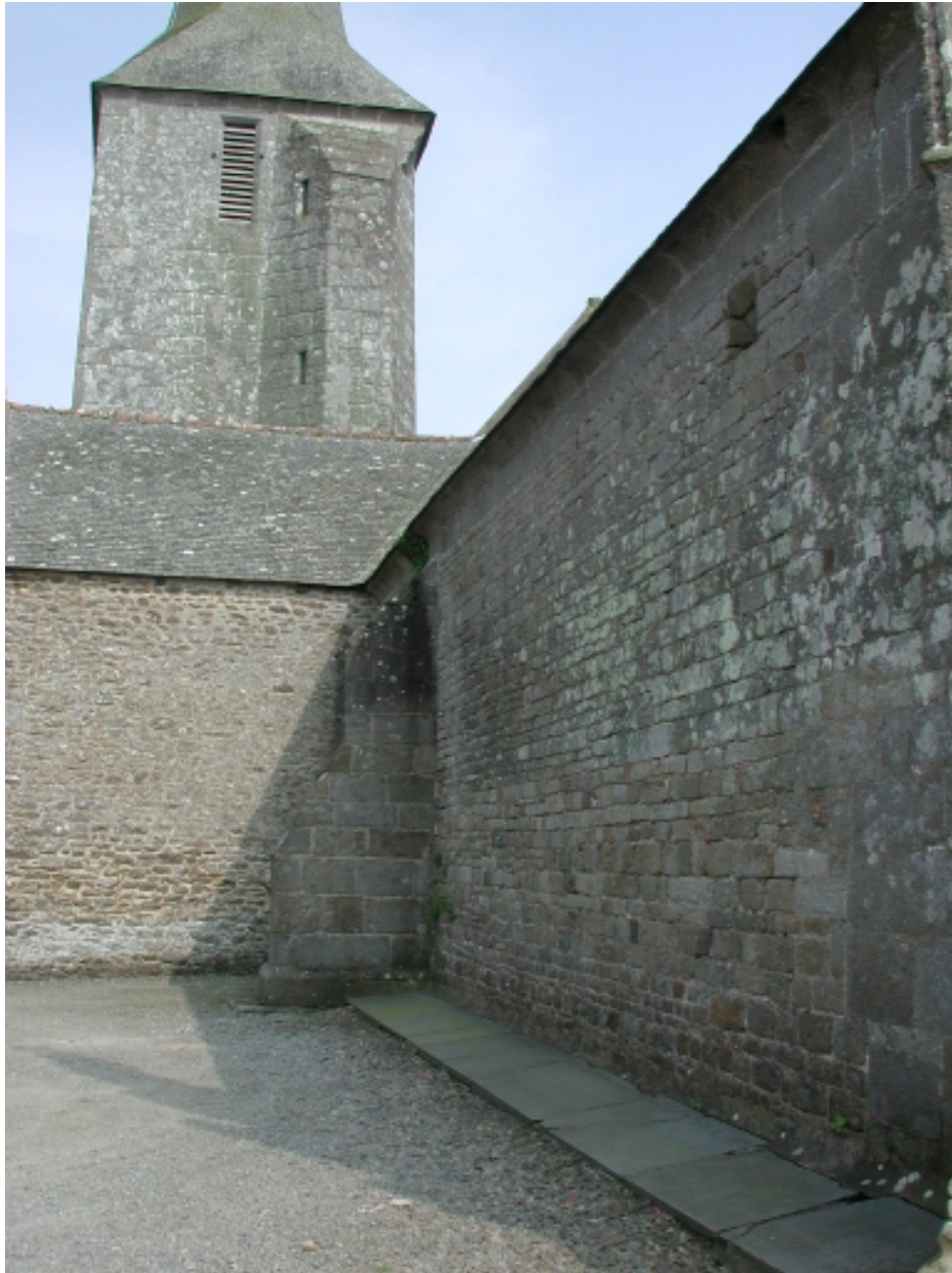
Vue partielle sud ouest
