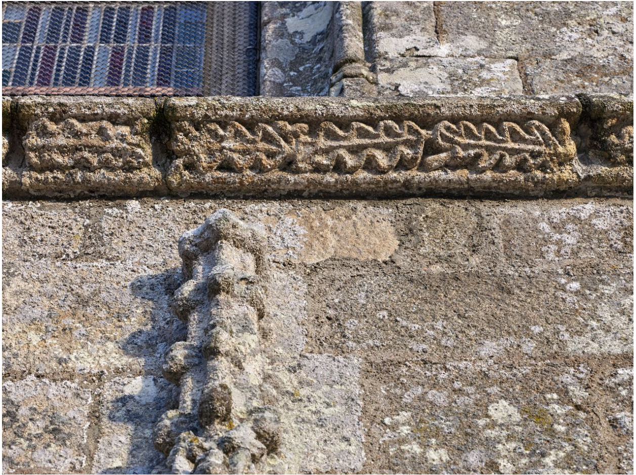
Façade occidentale, détail de la frise sculptée sous la verrière
