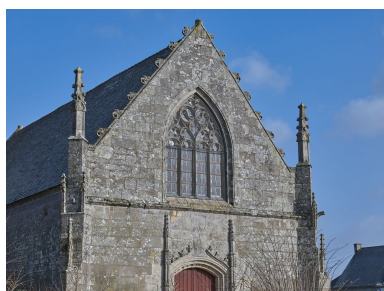
Façade occidentale, porte et verrière Phot. Bernard Bègne IVR53_20223500250NUCA
