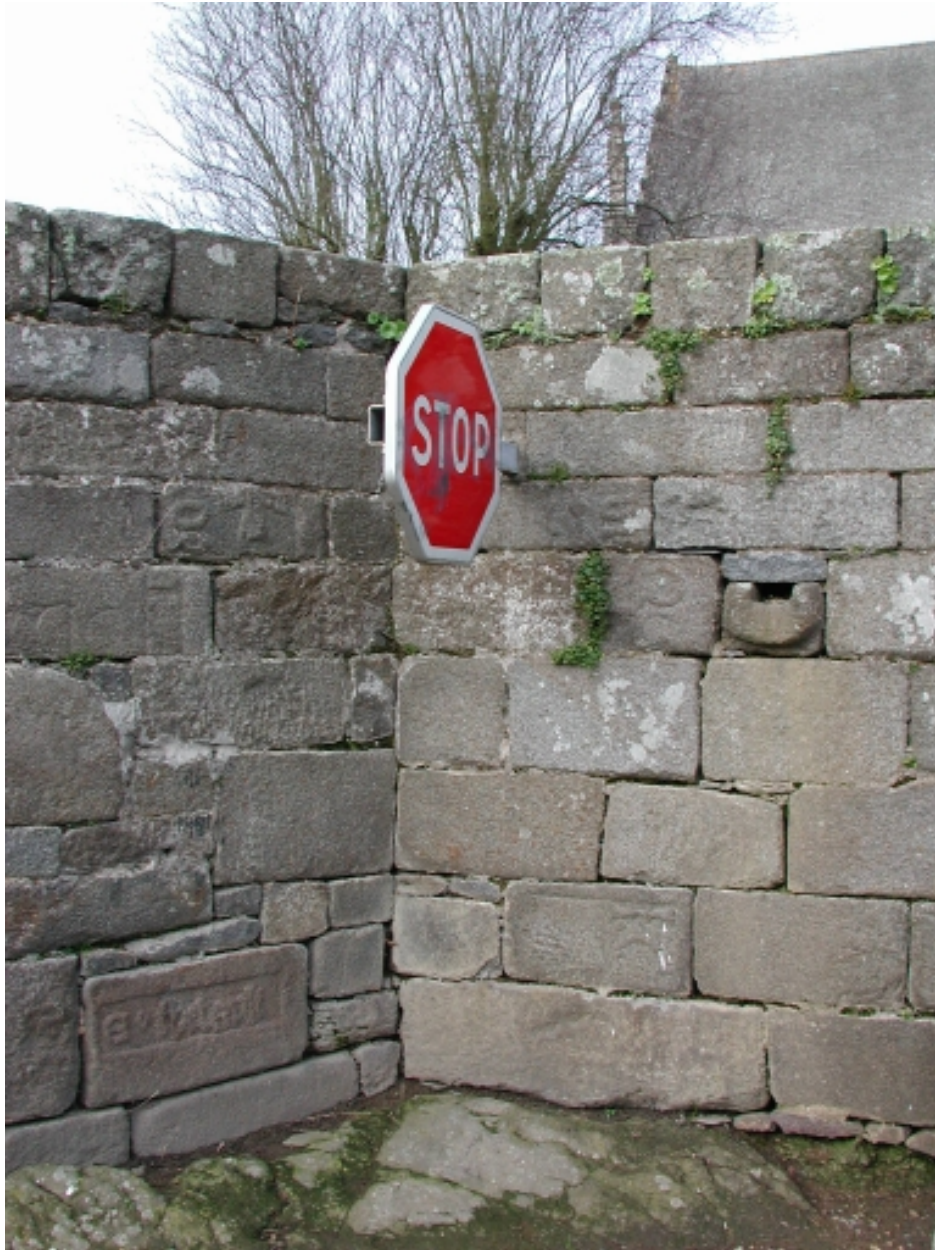
Mur de l'enclos ; pierres en remploi
