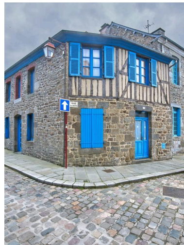
Le pan de bois visible au premier étage était enduit à l'origine. Phot. Bernard Bègne IVR53_20243501075NUCA
