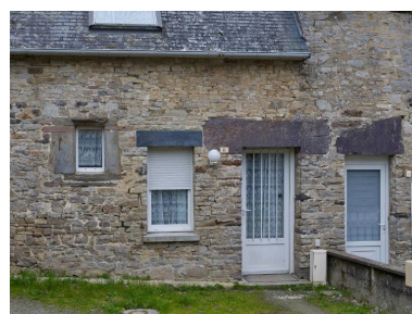
Exemples de linteaux en bloc monolithe du schiste pourpre, 8 impasse des Jardins Phot. Bernard Bègne IVR53_20263500496NUCA
