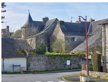
Vue de la tour à l'arrière du 8 rue de la Mairie Phot. Bernard Bègne IVR53_20263500479NUCA
