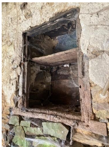
La ferme ancienne de la Gandouflais (détail de l'armoire murale) Phot. Enguerrand ROUZIC IVR53_20263510522NUCA
