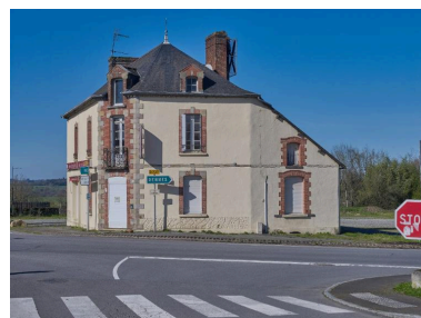
Ancien restaurant routier de Poligné (périphérie du bourg, sur l'ancienne route de Rennes à Nantes) Phot. Bernard Bègne
