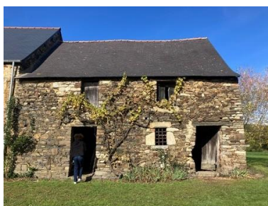
La ferme ancienne à la Gandouflais : La partie droite est le logement, la partie gauche est réservée aux bêtes, le comble sert au stockage des récoltes. Les éléments architecturaux permettent de placer cet édifice dans la deuxième moitié du 17 e siècle
