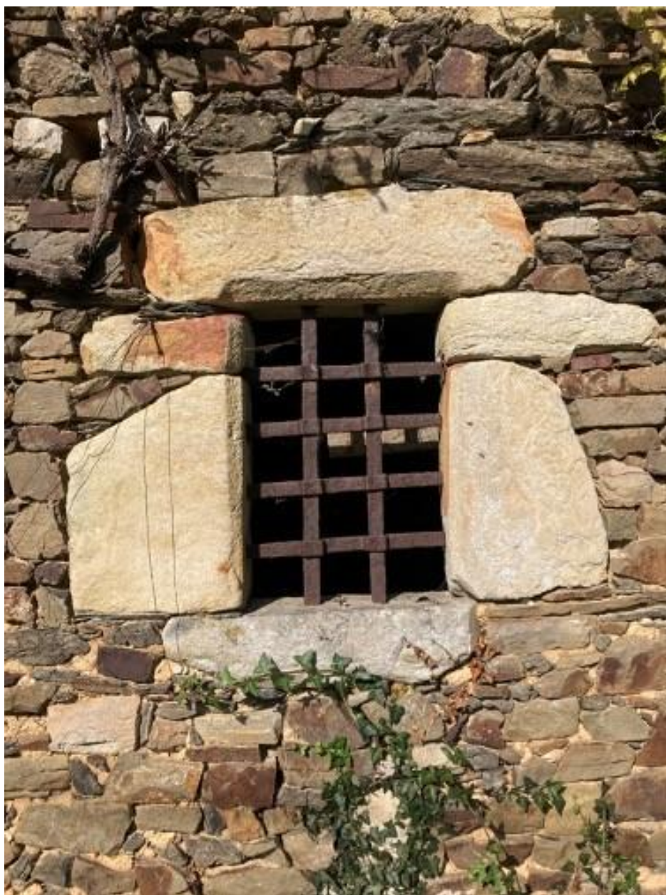
La ferme ancienne de la Gandouflais (détail de la baie du rez-de-chaussée)
