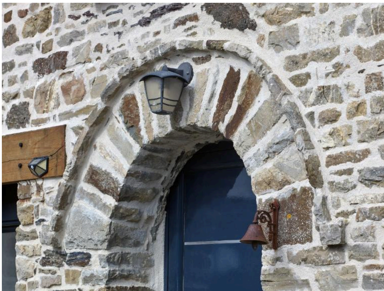
Arc en plein cintre surmonté d'un larmier, La Violais
