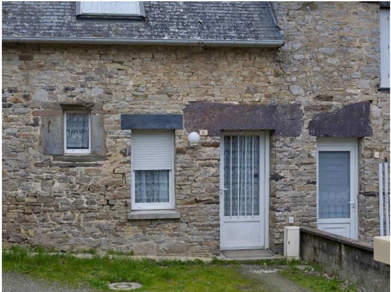
Exemples de linteaux en bloc monolithe du schiste pourpre, 8 impasse des Jardins
