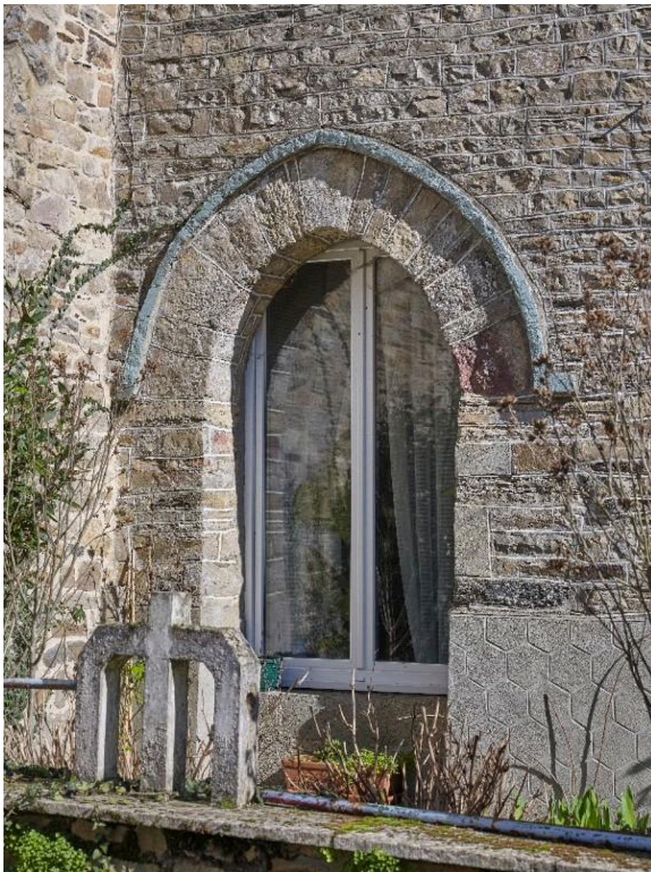
Arc brisé surmonté d'un larmier en schiste – 8 rue de la Mairie
