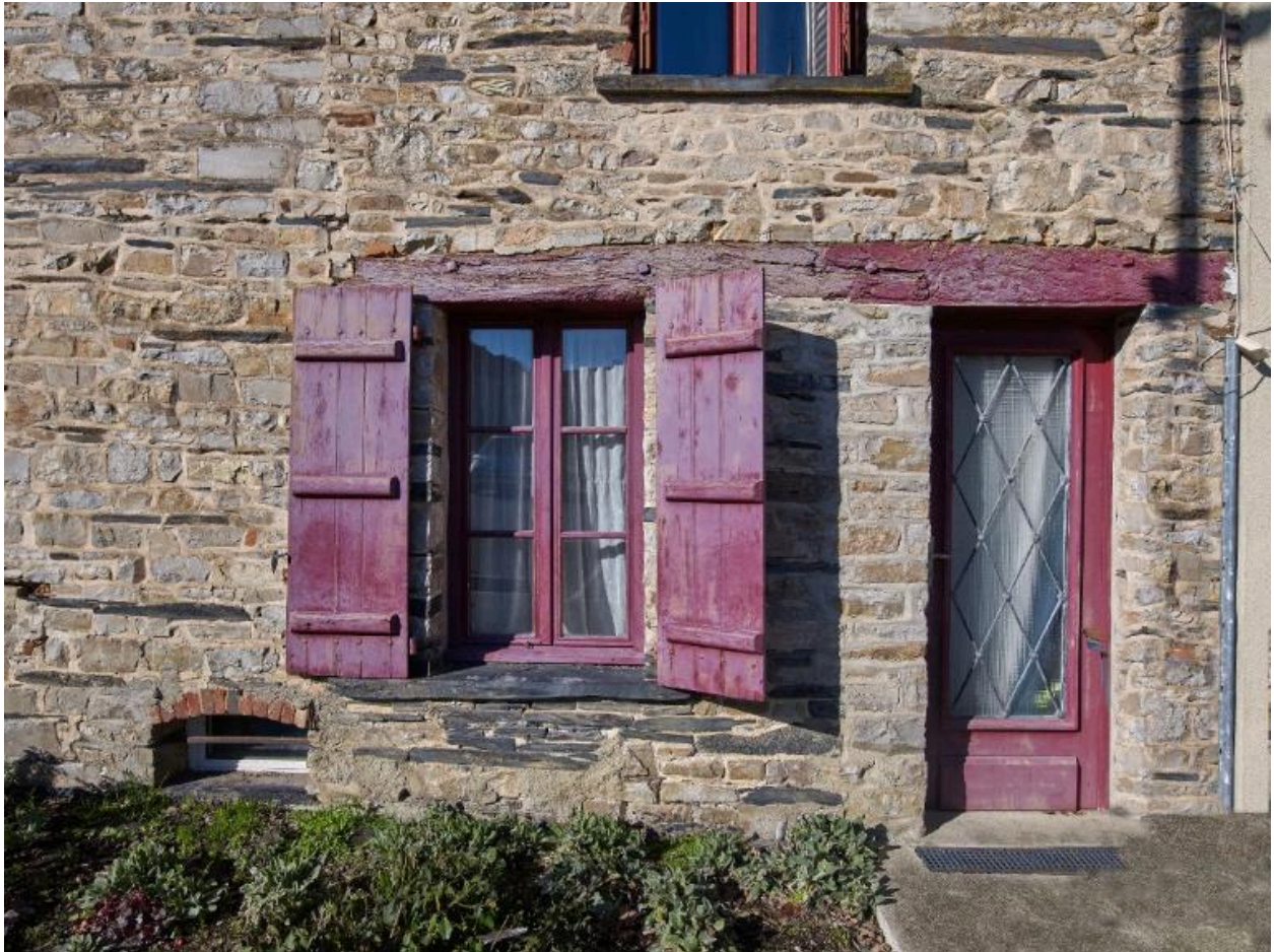
Exemple de linteau filant en bois, 23 place de l'Église
