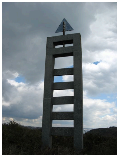
Amer de la pointe de Cornouaille (côté Camaret) Phot. Guillaume Marie IVR53_20082908443NUCA
