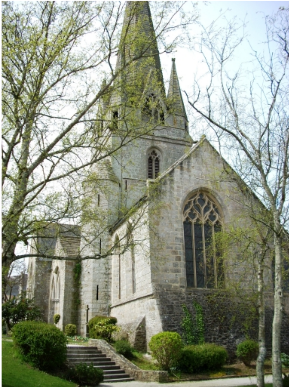
Rosporden, église paroissiale Notre-Dame : vue générale sud-est
