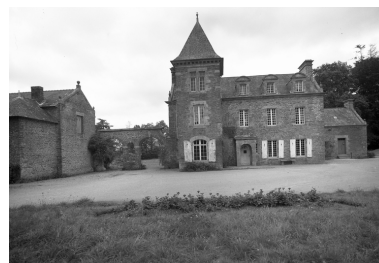
Vue générale sud Phot. François Dagorn IVR53_19775601169V
