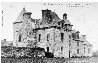
Elévation postérieure, vue de trois-quart Phot. Elise Lauranceau IVR53_20045606240NUCB
