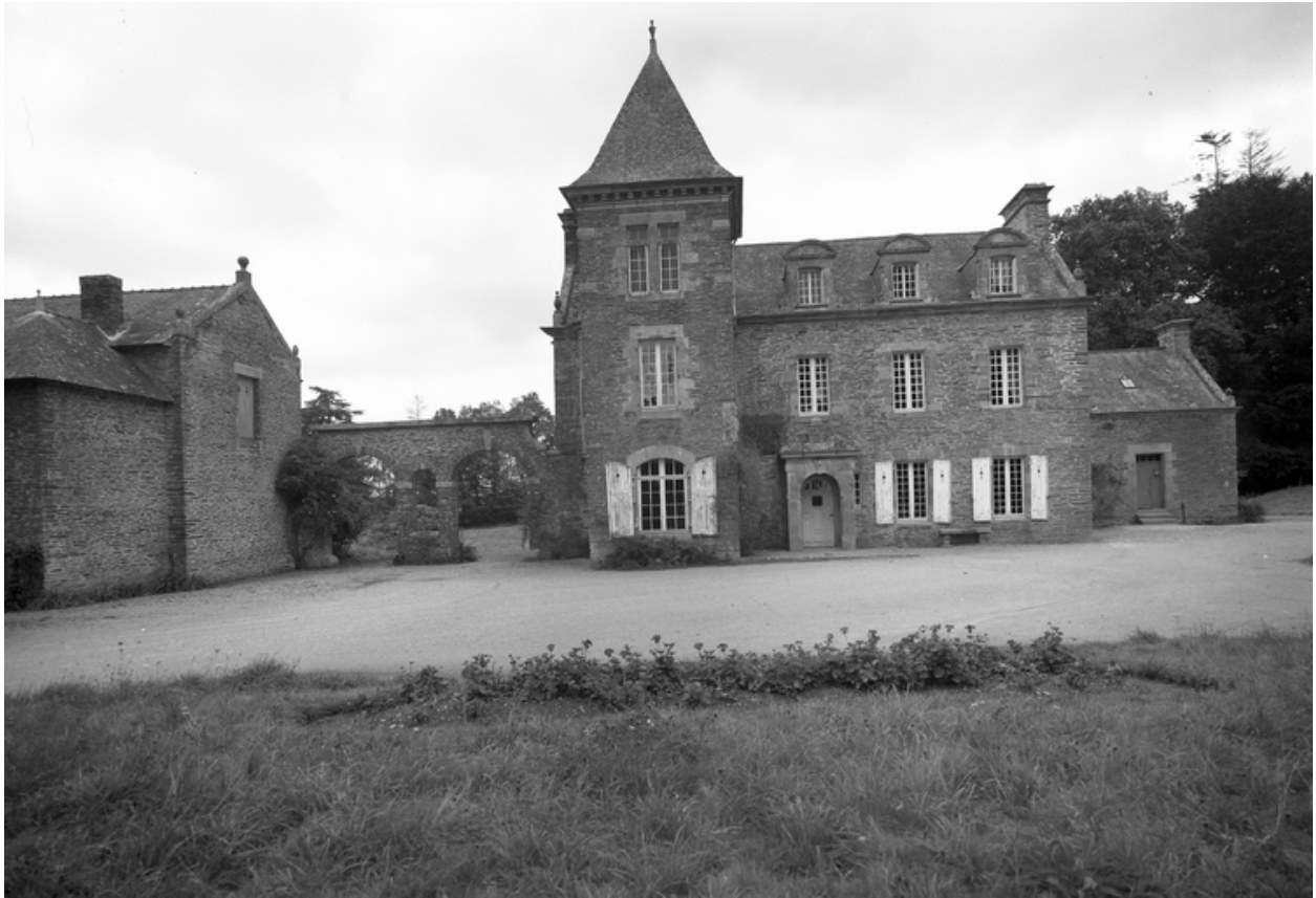
Vue générale sud
