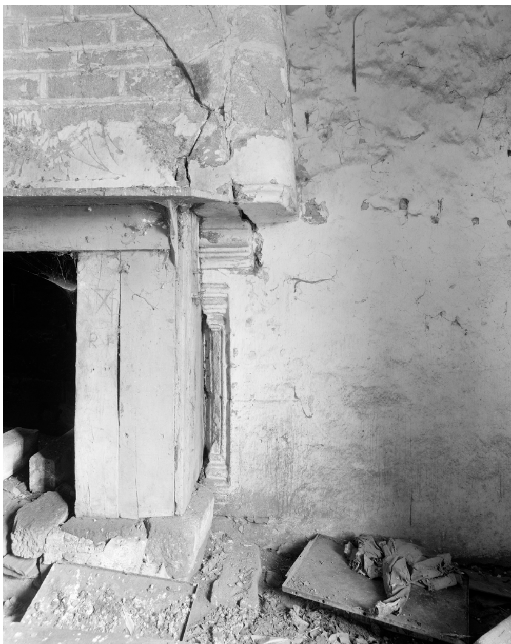
Rez-de-chaussée, salle, détail de la cheminée.
