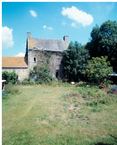
Elévation antérieure sud. Phot. Bernard Bègne IVR53_19975600780XA
