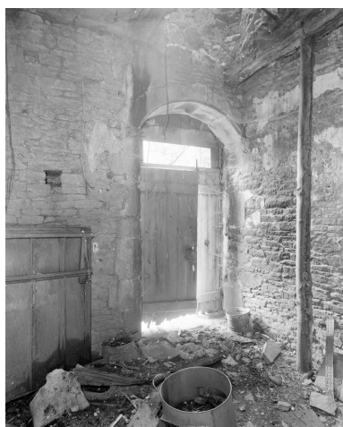
Rez-de-chaussée, porte d'entrée : vue générale. Phot. Bernard Bègne IVR53_19975600716X
