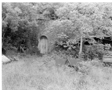
Chapelle, vue générale ouest. Phot. Bernard Bègne IVR53_19975600714X
