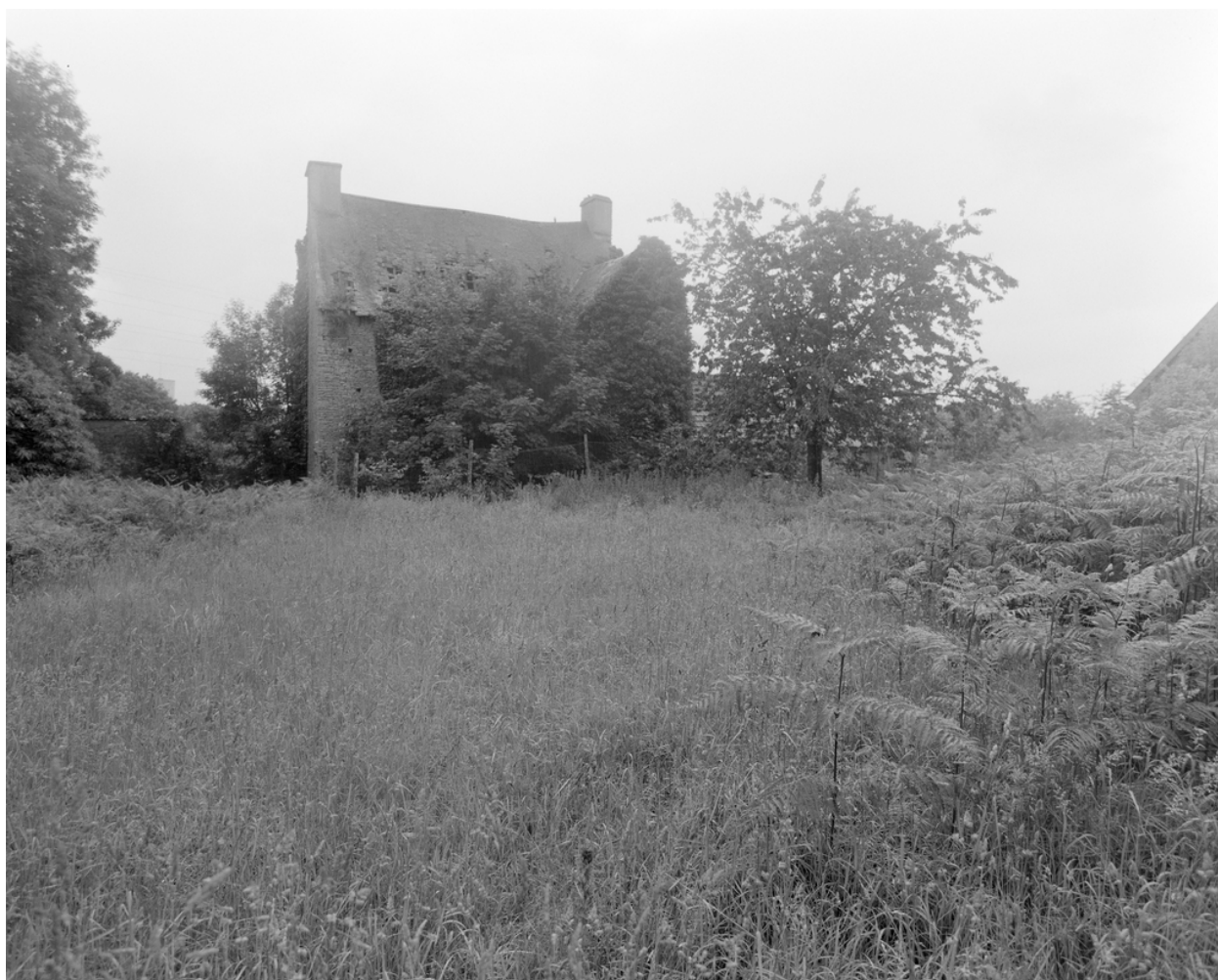
Elévation postérieure nord.
