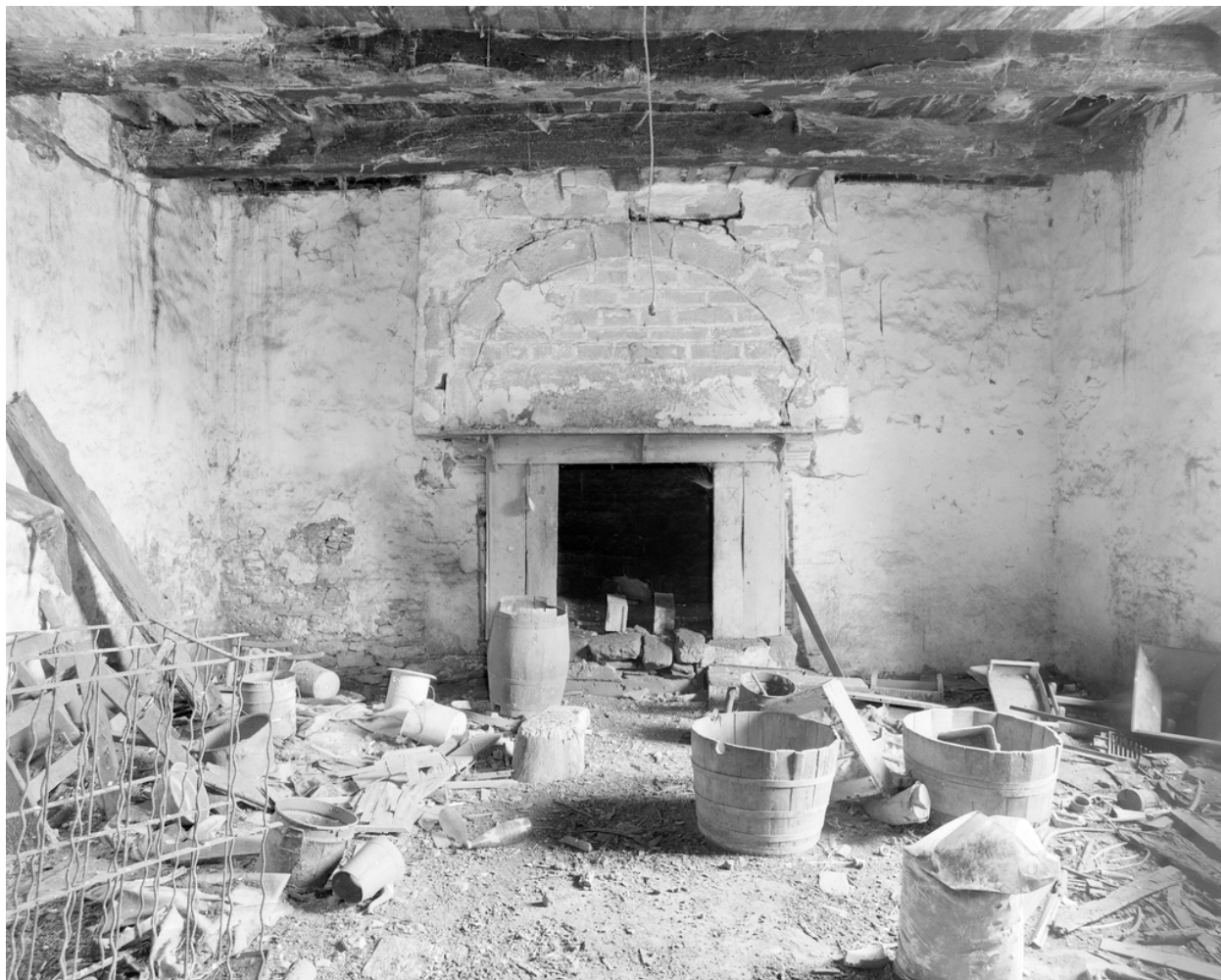
Rez-de-chaussée, vue générale de la salle.
