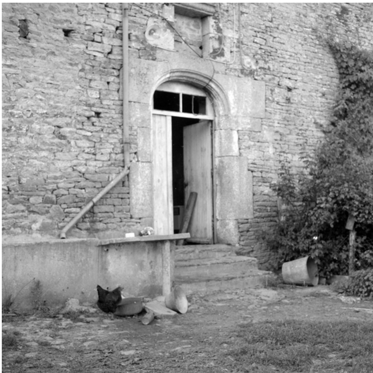
Détail de la porte
