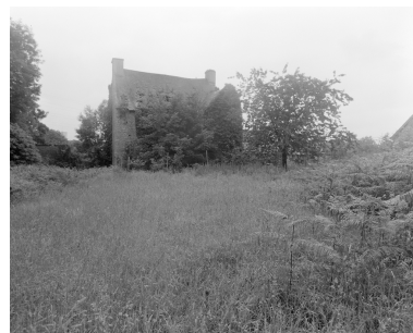
Elévation postérieure nord. Phot. Bernard Bègne IVR53_19975600719X
