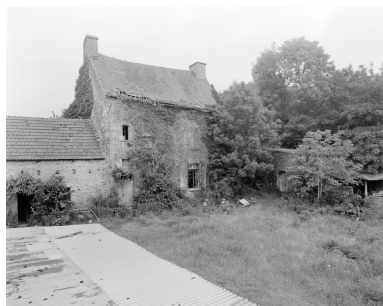
Elévation antérieure sud. Phot. Bernard Bègne IVR53_19975600713X
