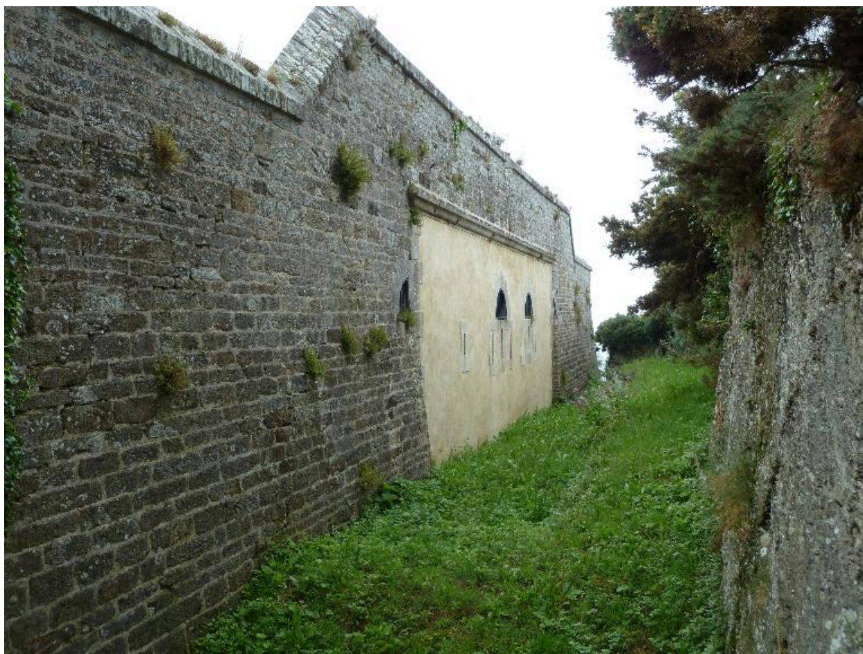
Le Palais, batterie de Ramonette, corps de garde crénelé, façade sud-ouest.
