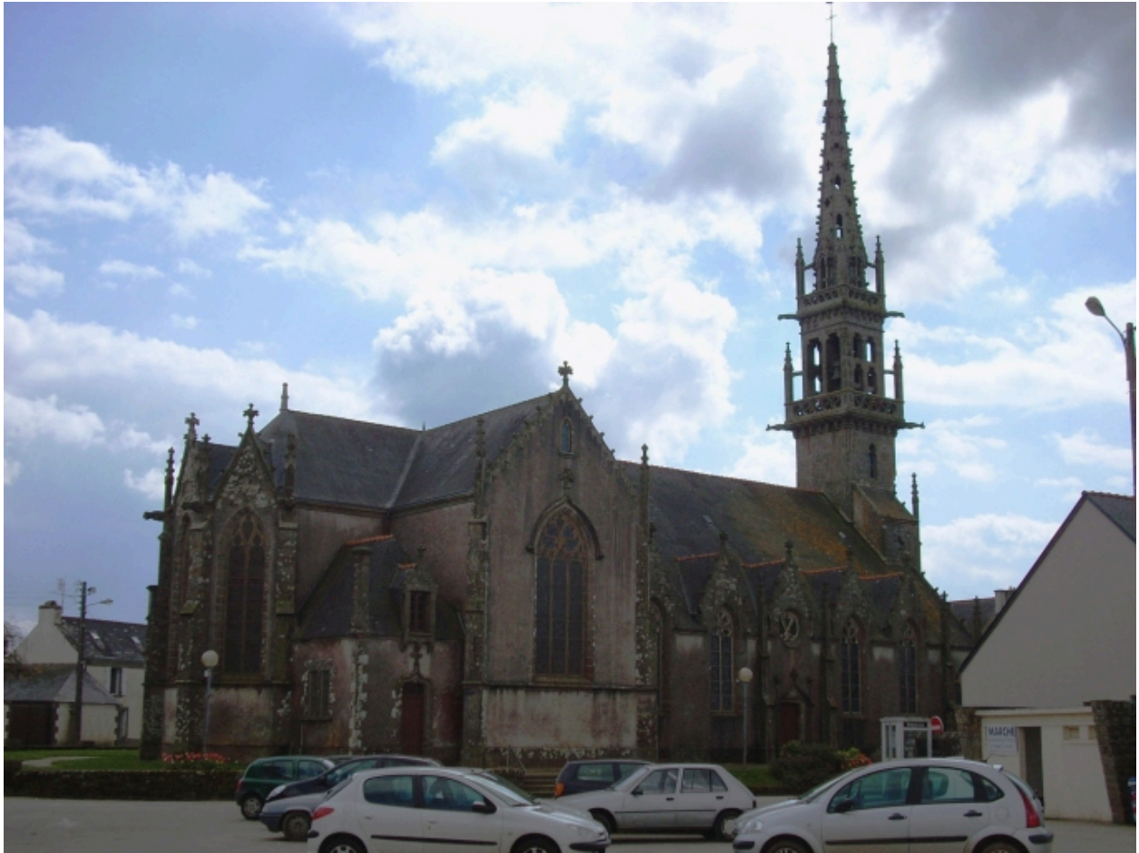
Plonévez-Porzay, église paroissiale Saint-Milliau : vue générale nord-est
