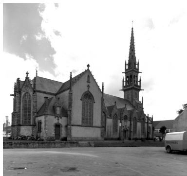
Plonévez-Porzay, église paroissiale Saint-Milliau : vue générale sud, état en 1970 Phot. Service régional de l'Inventaire de Bretagne IVR53_19702900946V
