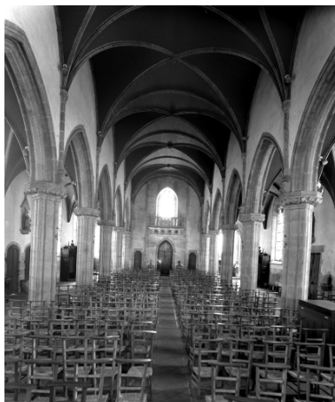
Plonévez-Porzay, église paroissiale Saint-Miliau : nef, vue générale vers l'ouest, état en 1970 Phot. Guy Artur IVR53_19702900949V
