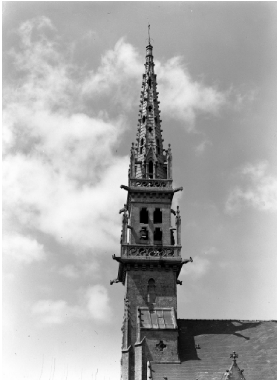
Plonévez-Porzay, église paroissiale Saint-Milliau : Clocher, vue générale, état en 1970
