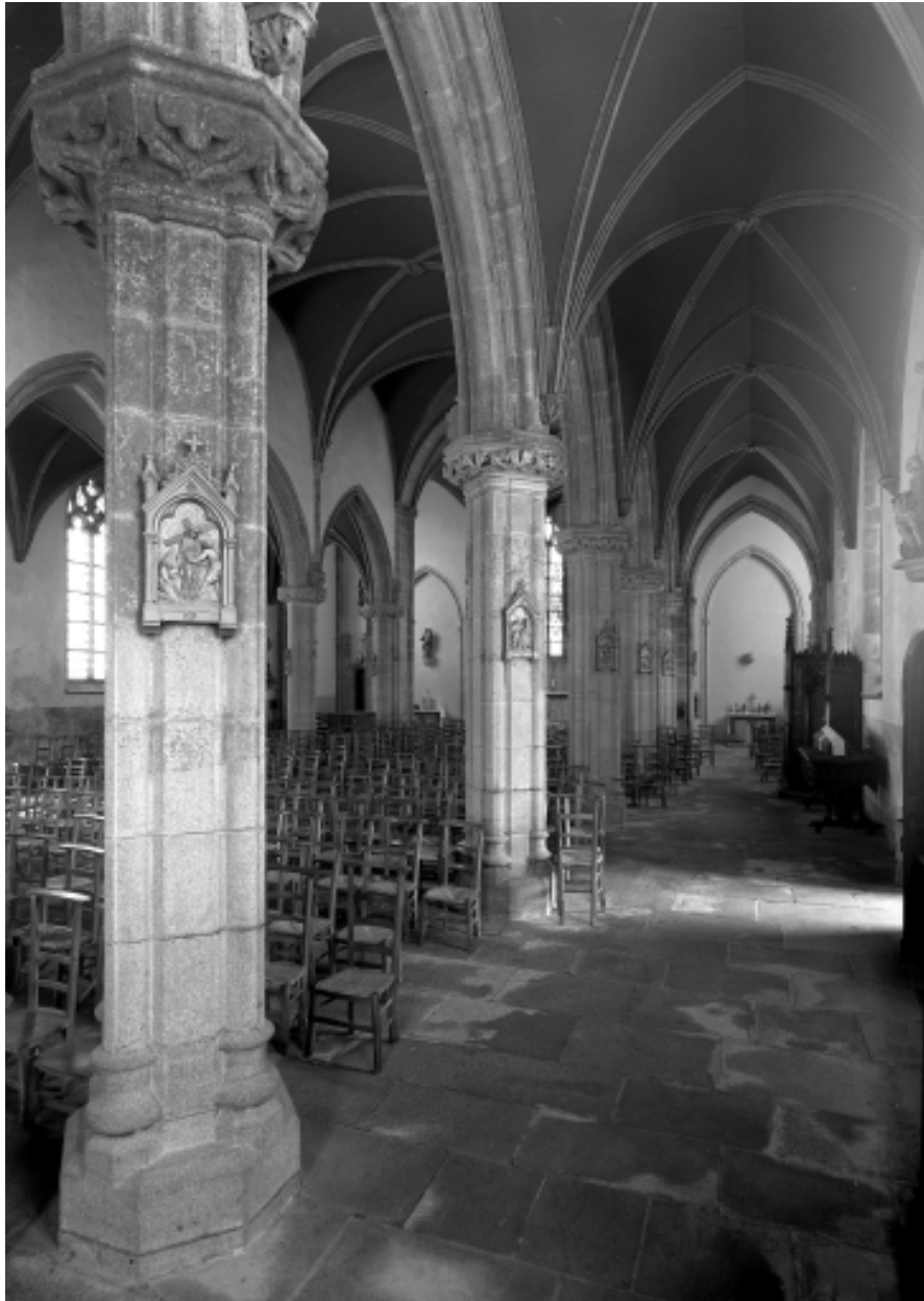
Plonévez-Porzay, église paroissiale Saint-Milliau : bas-côté sud, vers l'est, état en 1970
