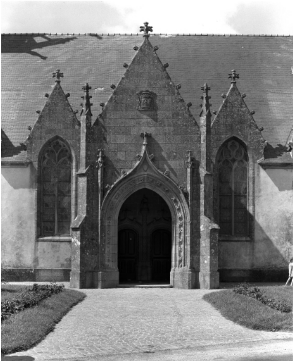
Plonévez-Porzay, église paroissiale Saint-Milliau : façade sud, détail du porche, état en 1970
