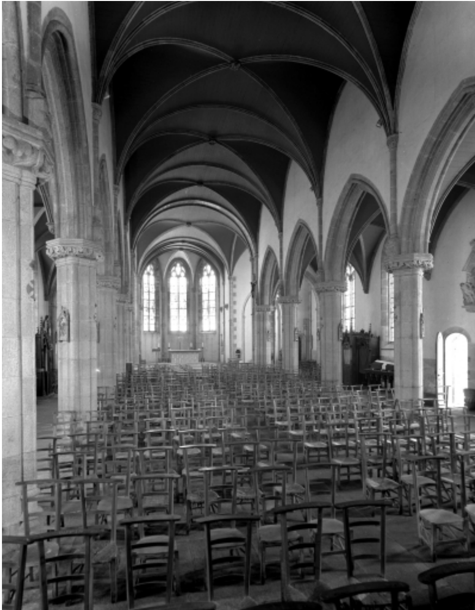
Plonévez-Porzay, église paroissiale Saint-Milliau : nef, vue générale vers l'est, état en 1970
