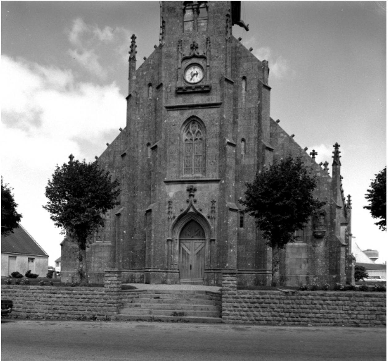
Plonévez-Porzay, église paroissiale Saint-Milliau : façade ouest, état en 1970
