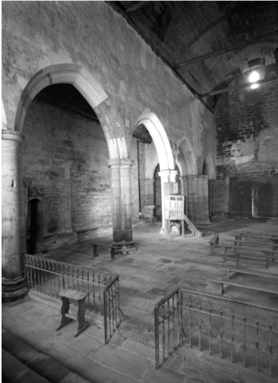
Nef, vue générale vers le sud ouest
