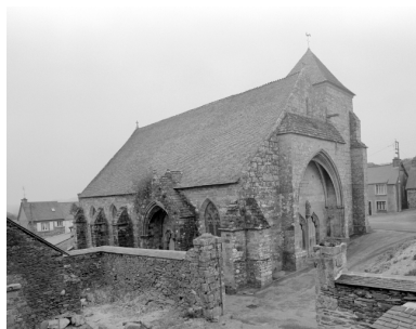
Vue générale nord ouest Phot. Bernard Bègne IVR53_19962200586X
