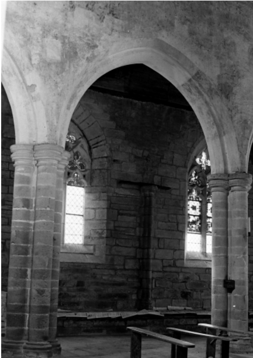
Vue d'une arcade de la nef
