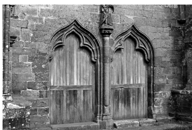
Portes de la façade ouest Phot. M. A. Dubois IVR53_19692205552Z
