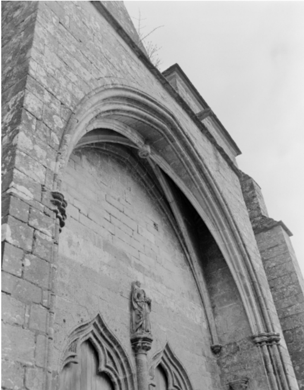
Elévation ouest, voûte du portail
