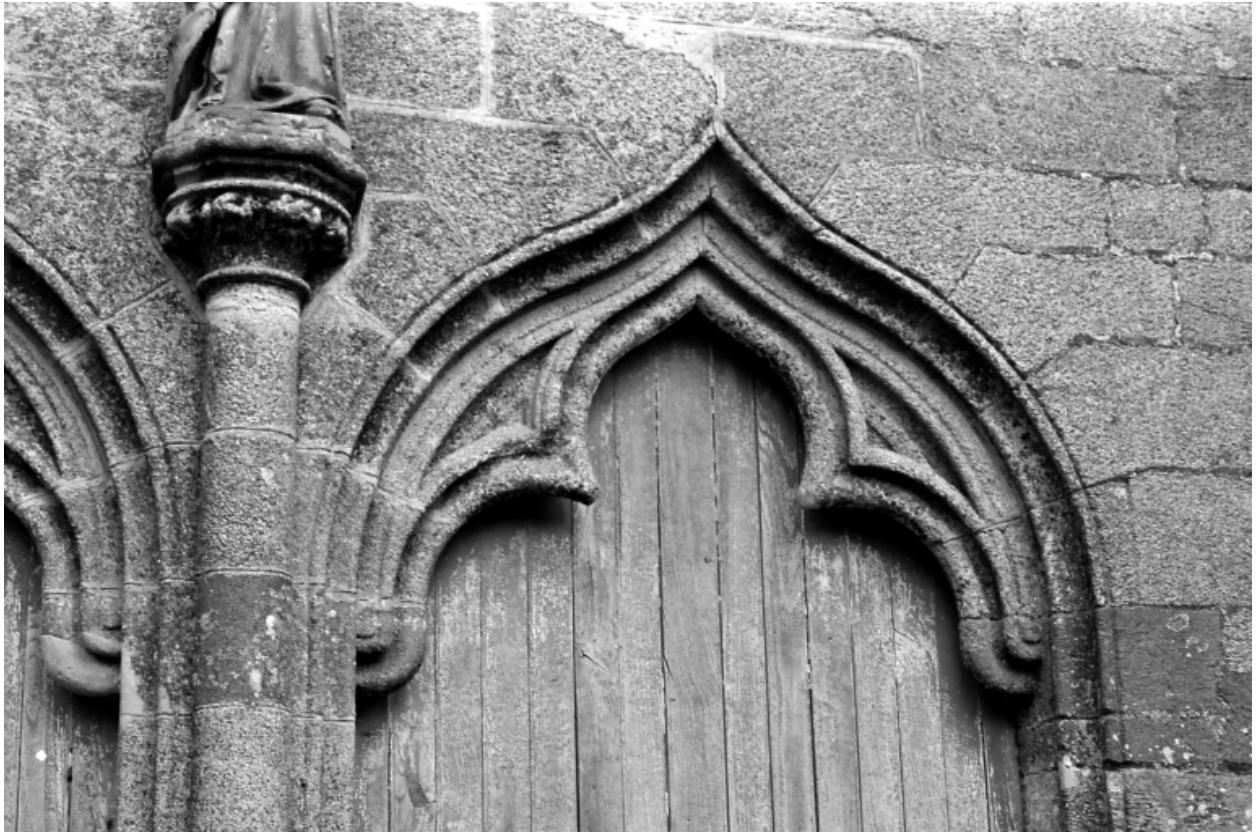
Porche ouest, détail d'une des portes
