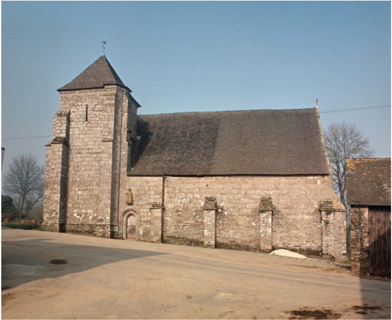
Vue générale sud
