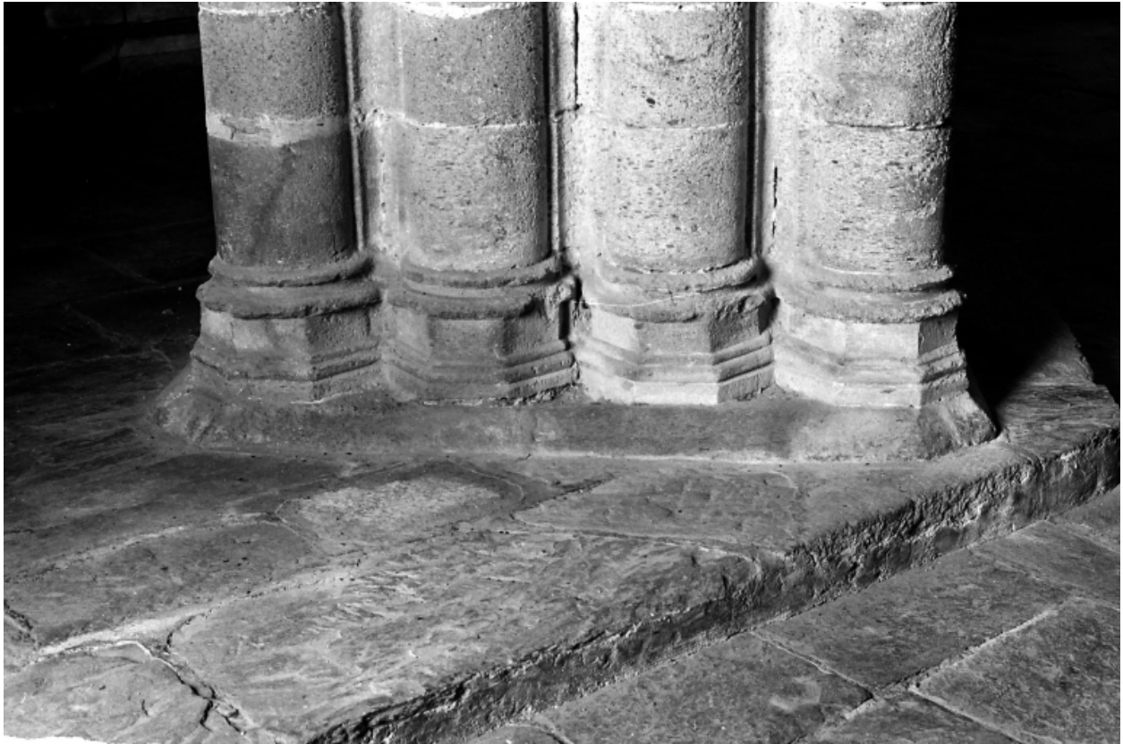
Bases du pilier sud-ouest supportant le clocher
