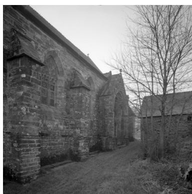
Elévation nord, vue générale Phot. Guy Artur, Autr. Guy Artur IVR53_19902200451V
