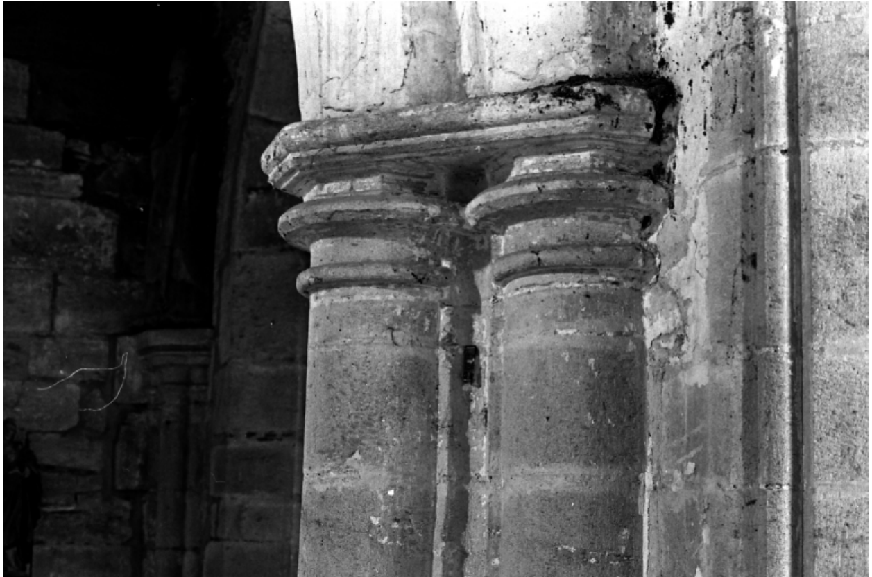
Chapiteaux du pilier adossé au revers de la façade ouest
