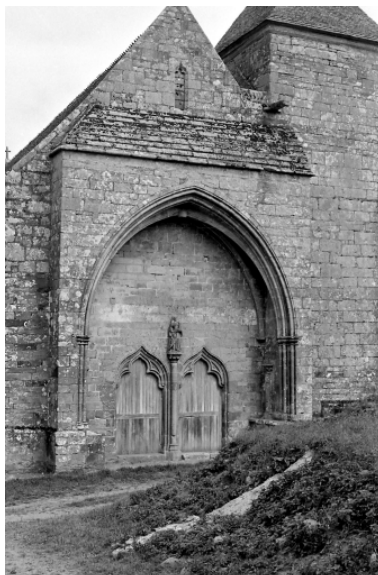
Vue ouest Phot. M. A. Dubois IVR53_19692205273Z
