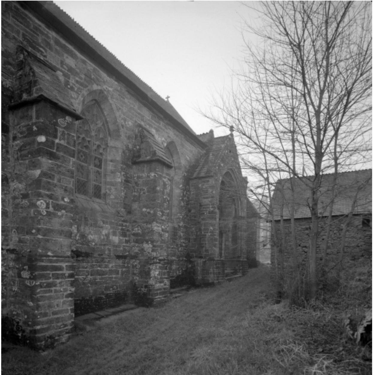
Elévation nord, vue générale
