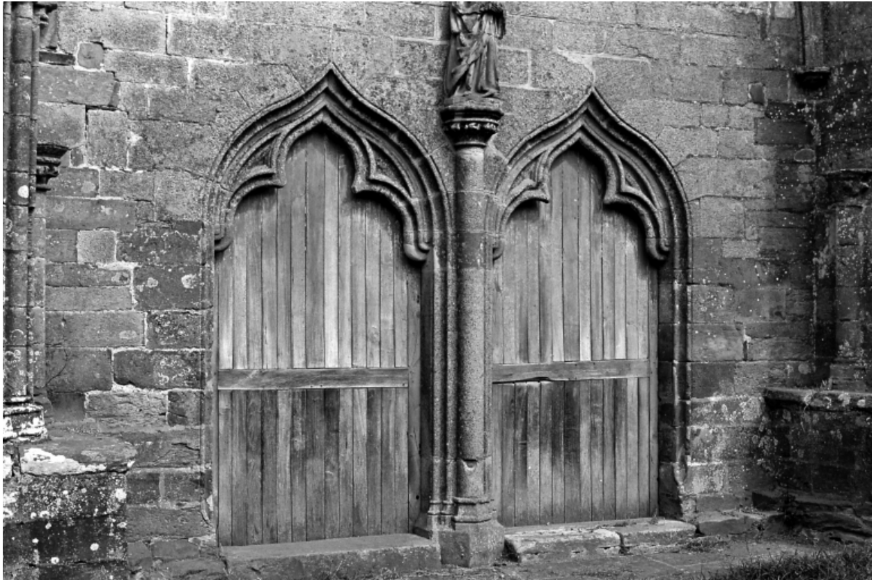
Portes de la façade ouest
