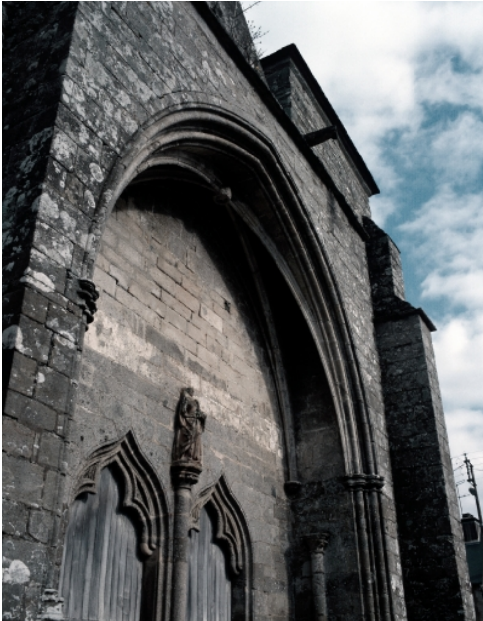
Elévation ouest, voûte du portail
