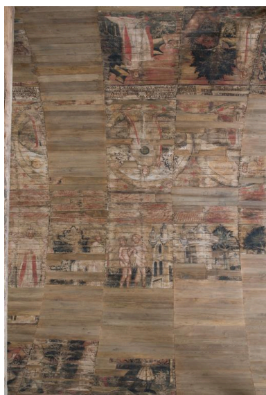
Lambris de couverture de la nef. Scènes de la Genèse, XV e siècle. Adam et Eve chassés du Paradis. Phot. Charlotte Barraud IVR53_20192200868NUCA
