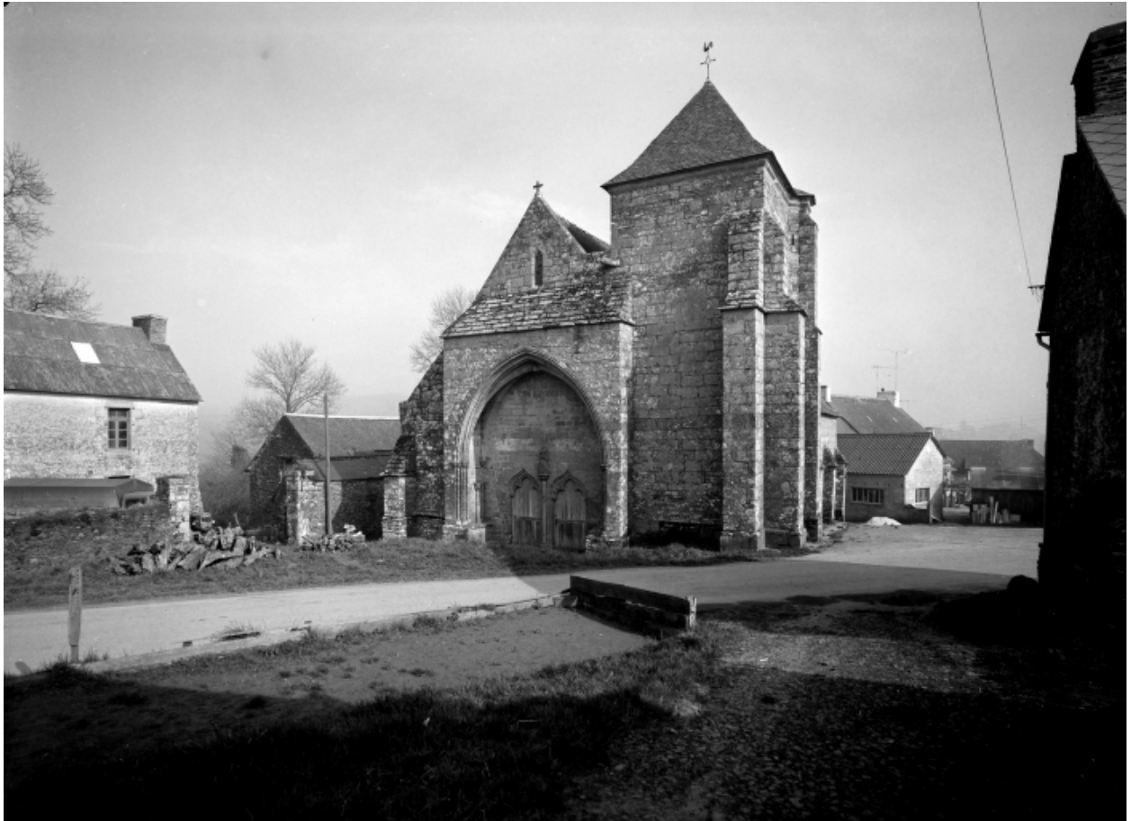
Vue générale ouest
