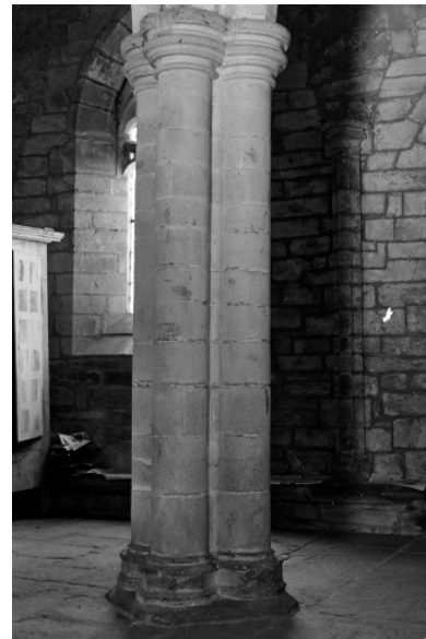
Vue d'une pile de la nef Phot. M. A. Dubois IVR53_19692205242Z
