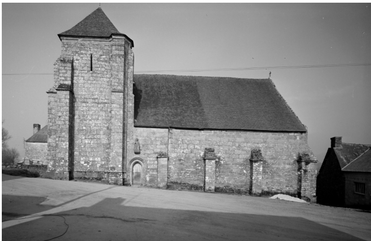
Vue générale sud
