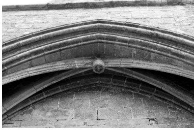
Voûte du portail ouest Phot. M. A. Dubois IVR53_19692205276Z
