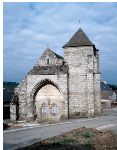
Vue générale ouest (état en 1975) Phot. Guy Artur IVR53_19962200502XA
