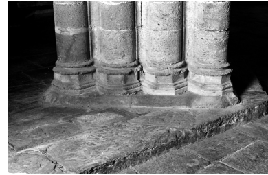
Bases du pilier sud-ouest supportant le clocher Phot. M. A. Dubois IVR53_19692205239Z
