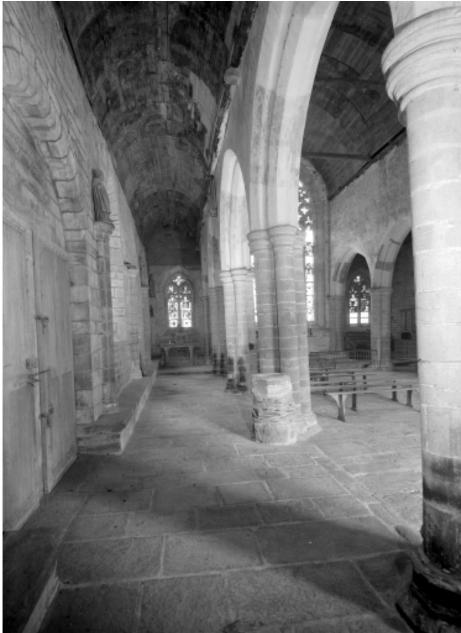
Bas-côté nord, vue vers l'est
