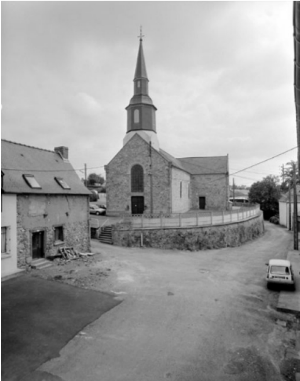
Élévation Ouest : vue générale
