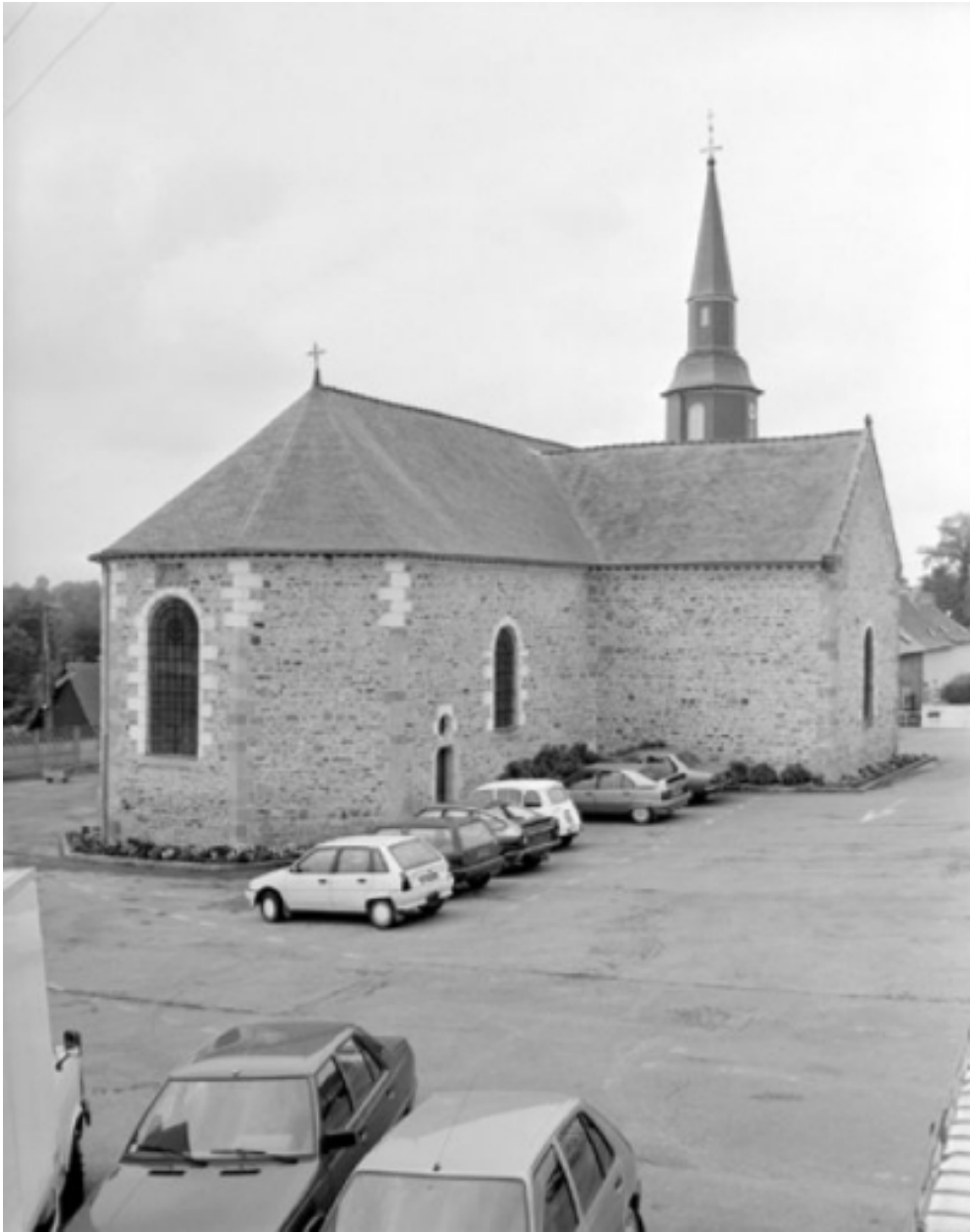
Élévation Nord-Est : vue générale
