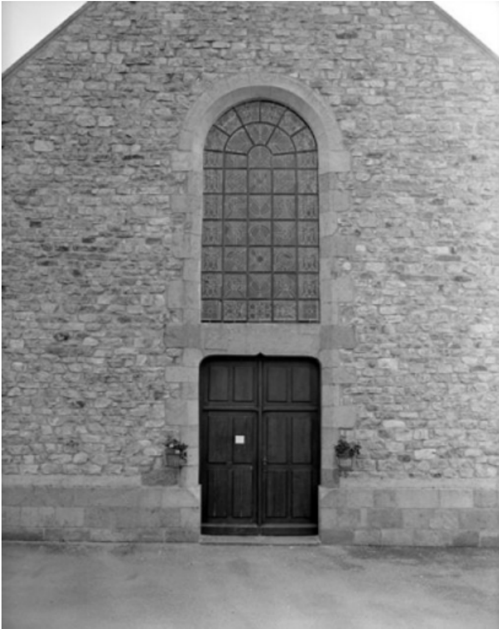
Élévation Ouest, porte : vue générale
