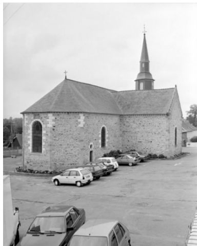
Élévation Nord-Est : vue générale Phot. Guy Artur, Phot. Norbert Lambart IVR53_19943500884X
