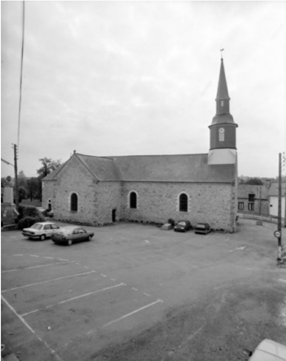
Élévation Nord : vue générale
