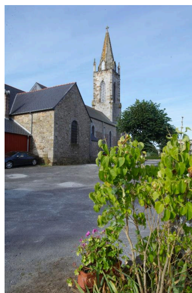
Vue nord-est Phot. Norbert Lambart IVR53_20123501598NUCA
