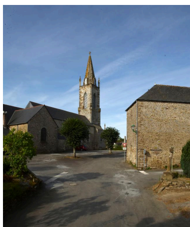
Vue nord-est Phot. Norbert Lambart IVR53_20123501601NUCA
