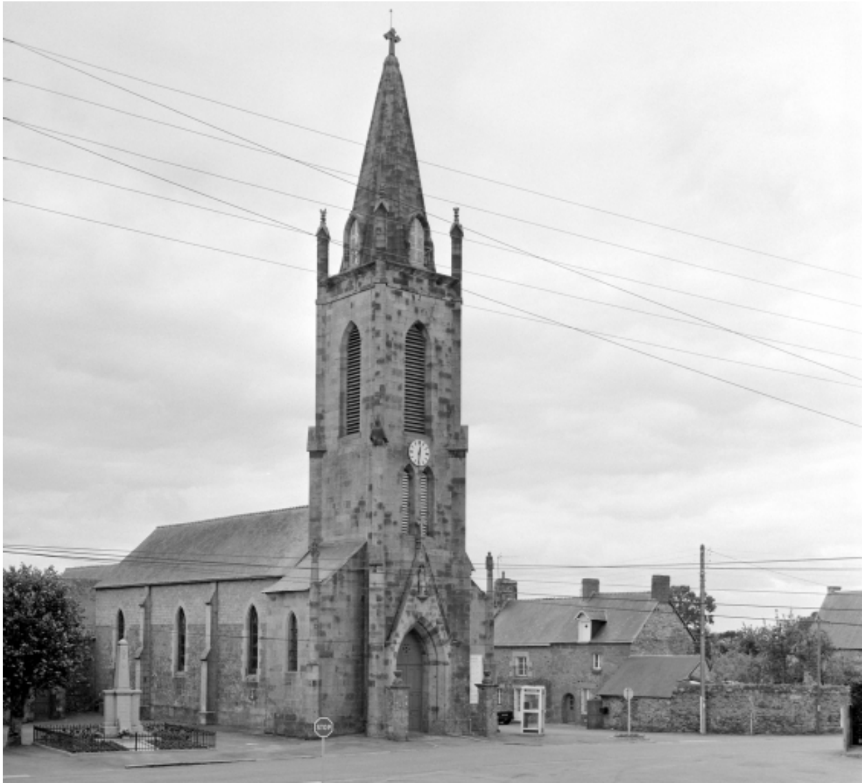
Elévation nord-ouest : vue générale
