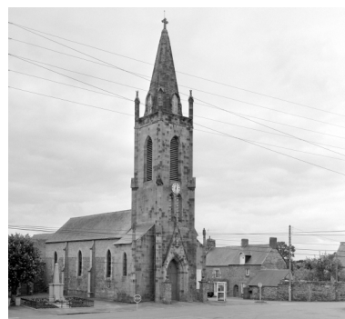
Élévation nord-ouest : vue générale Phot. Guy Artur, Phot. Norbert Lambart IVR53_19943501276X
