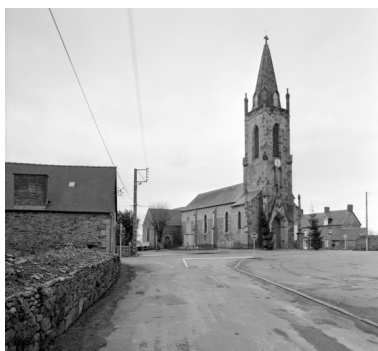
Élévation nord-ouest : vue générale Phot. Guy Artur, Phot. Norbert Lambart IVR53_19943500115X
