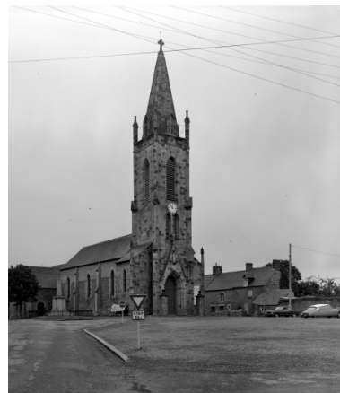
Elévation nord-ouest : vue générale Phot. Guy Artur, Phot. Norbert Lambart IVR53_19773500348V
