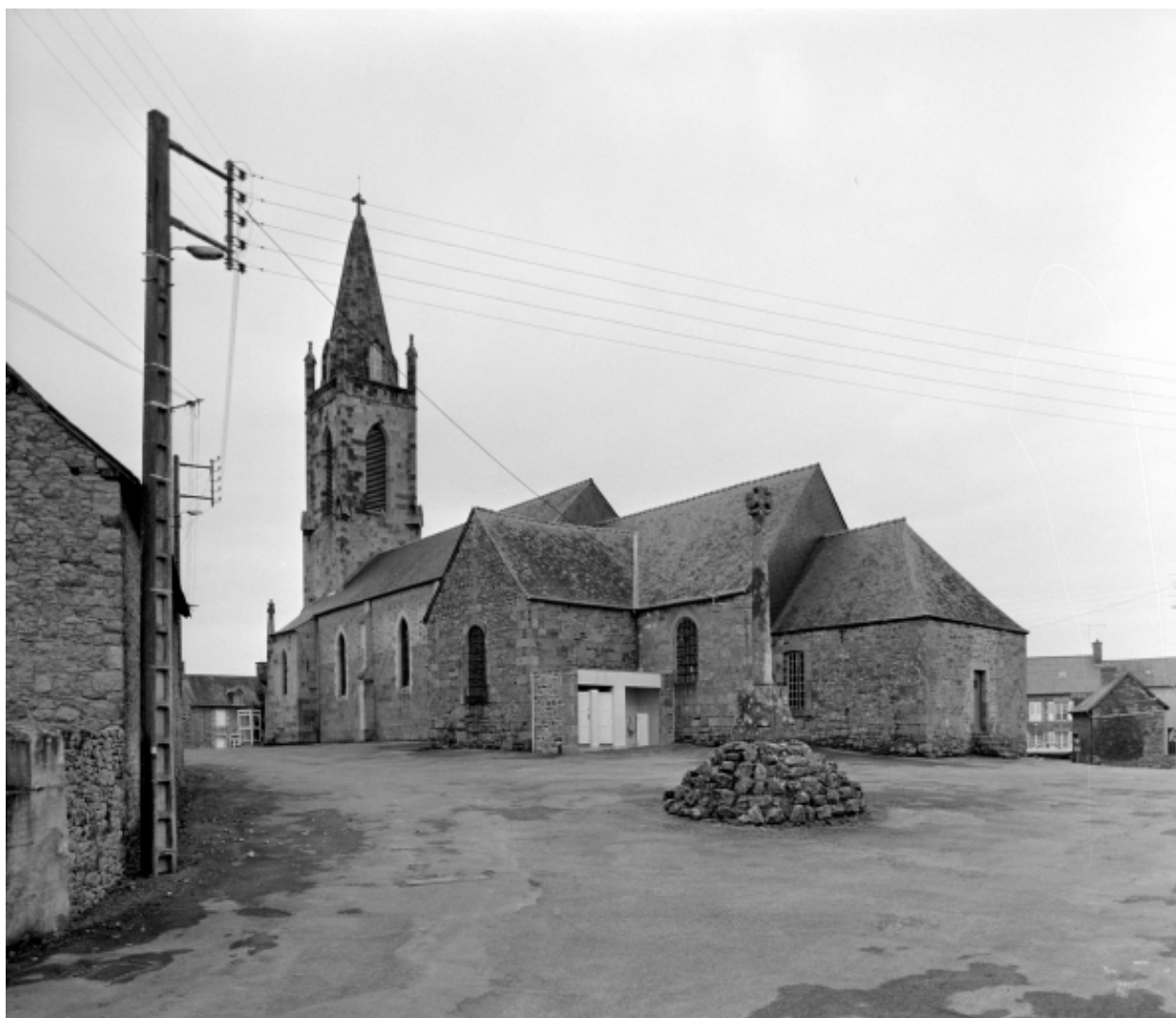
Elévation sud-est : vue générale ; au 1er plan, la croix monumentale
