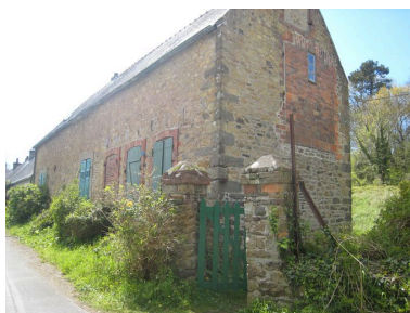
Vue de la villa-pension La Pagode avec ouverture murée sur le pignon nord qui servait aux artistes Phot. Françoise Péron IVR53_20082908413NUCA
