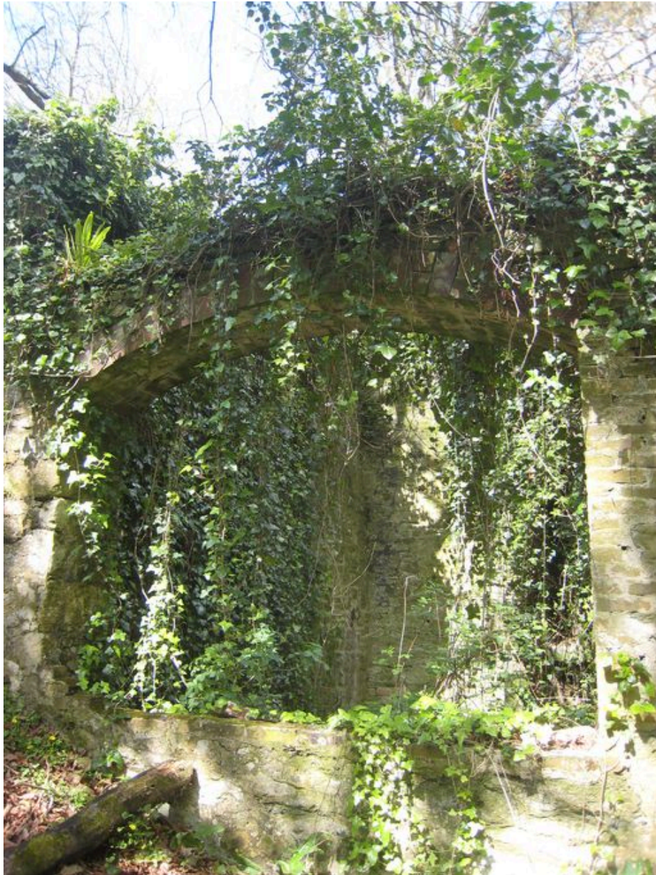
Ruines du bâtiment abritant les deux fours à chaux
