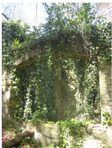
Ruines du bâtiment abritant les deux fours à chaux Phot. Françoise Péron IVR53_20082908415NUCA
