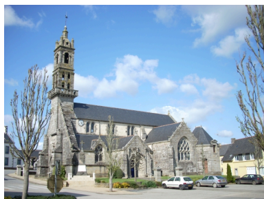
Edern, église paroissiale Saint-Edern : vue générale sud-ouest Phot. Gwénaél Fauchille IVR53_20082905504NUCA
