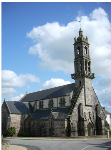
Edern, église paroissiale Saint-Edern : vue générale nord-ouest Phot. Gwénaél Fauchille IVR53_20082905505NUCA
