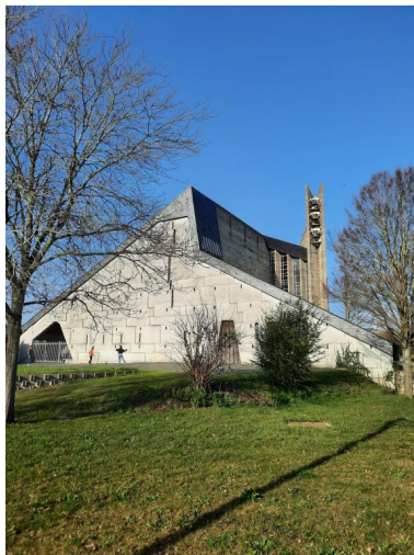
Eglise Saint-Yves, rue du Vieux Puits Phot. Mary Simon IVR53_20222206127NUCA
