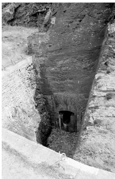
Vue de la batterie de Cornouaille en 1967 : entaille ménagée dans le terre-plein de la batterie pour dégager le champ de tir de l'embrasure de droite de la batterie de rupture
