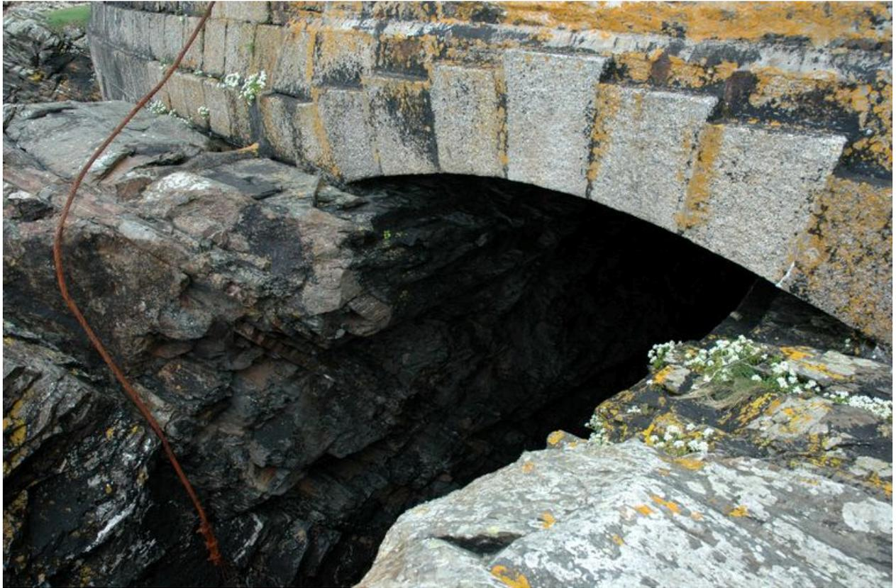
Vue de la batterie de Cornouaille : arc de soutènement du parapet au débouché de l'entaille de l'embrasure de gauche de la batterie de rupture
