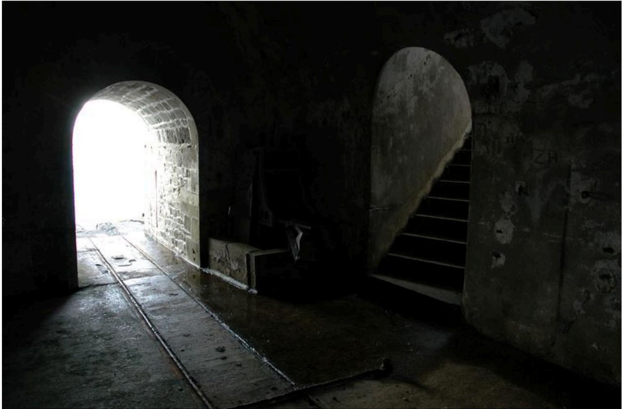
Vue de la batterie de Cornouaille : abri de projecteur (4e quart du 19e siècle) aménagée sous le mur de soutènement de la batterie (4e quart 17e siècle). A signaler : les rails pour le chariot du projecteur
