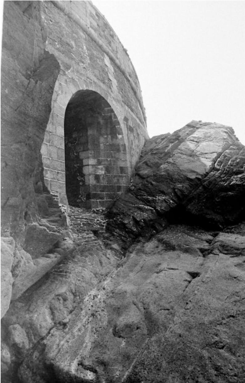
Vue de la batterie de Cornouaille en 1967 : arc de soutènement du parapet au débouché de l'entaille de l'embrasure de droite de la batterie de rupture
