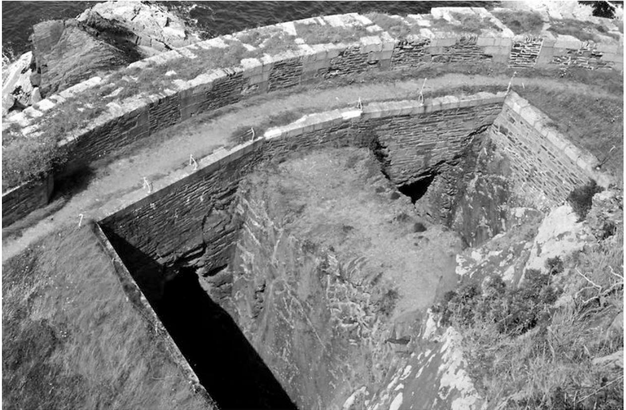
Vue de la batterie de Cornouaille en 1967 : entailles ménagées dans le terre-plein de la batterie pour dégager le champ de tir des embrasures de la batterie de rupture (depuis le haut de la falaise)
