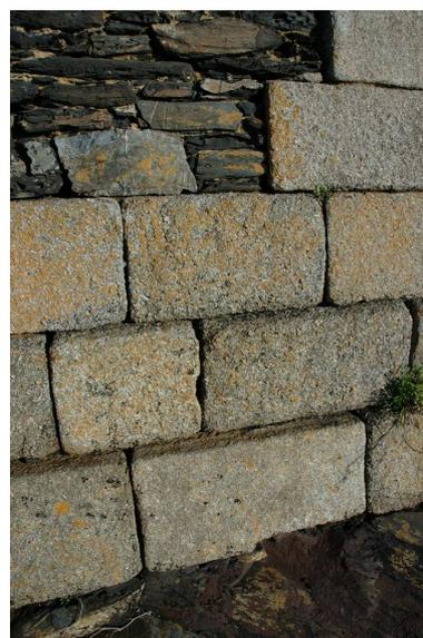
Vue de la batterie de Cornouaille : mur de soutènement de la batterie. Soubassement, chaînes, cordon, gargouilles et encadrement des créneaux en granite, remplissage en moellons de schiste
