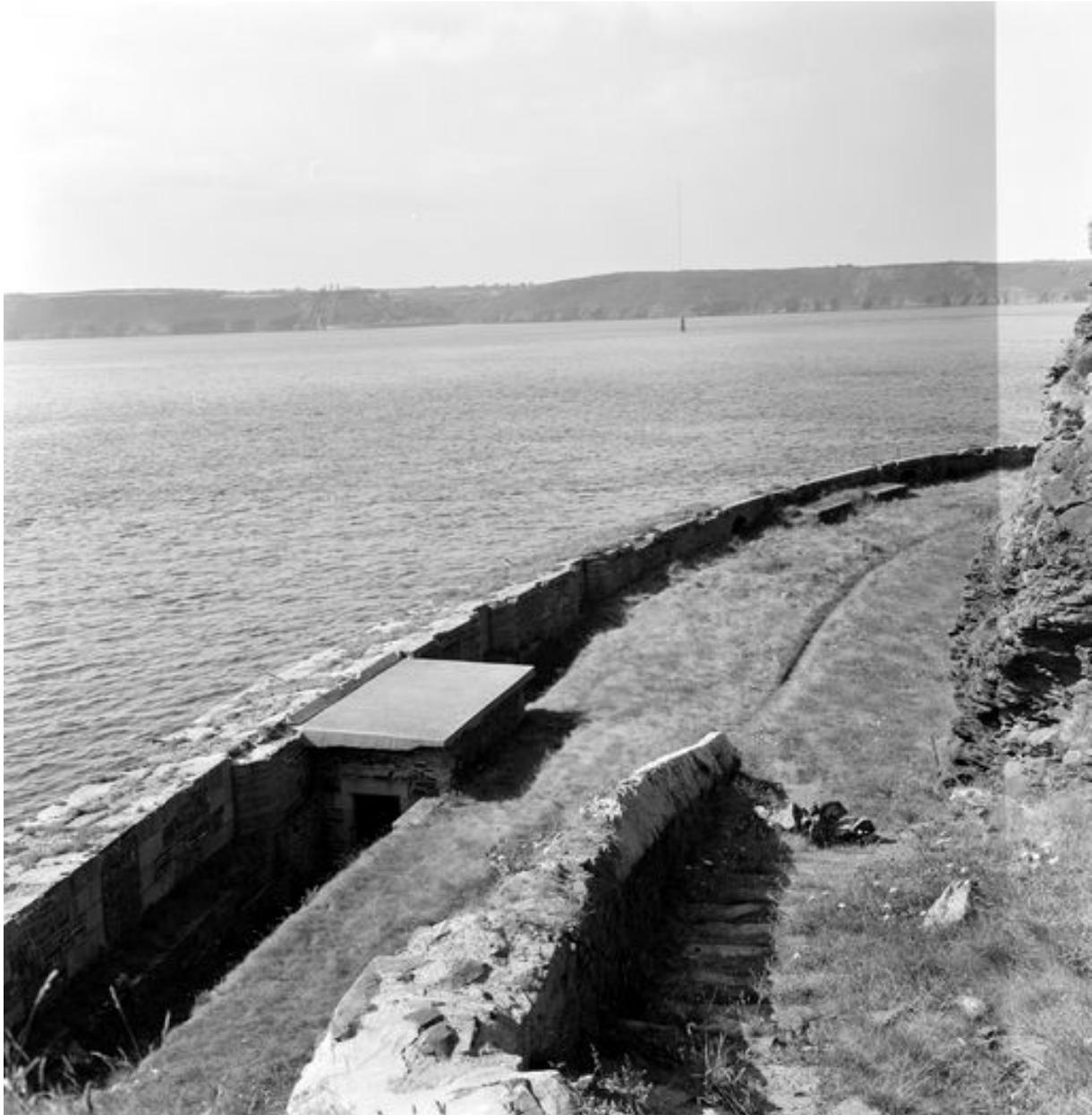
Vue de la batterie de Cornouaille en 1969 : parapet, abri léger avec dalle en béton
