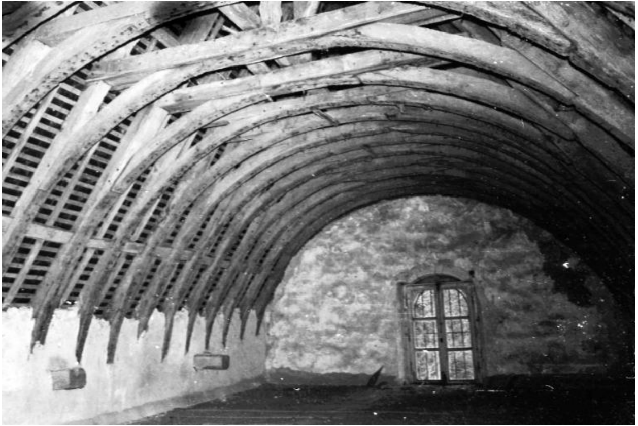
Chapelle, vue générale de la charpente.
