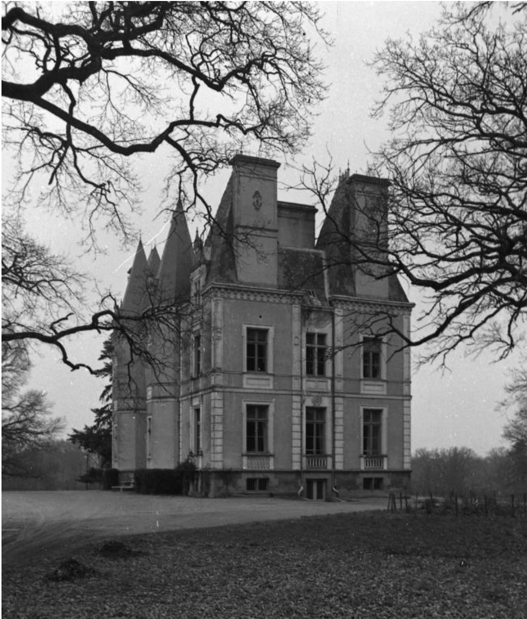
Vue générale de la face est.
