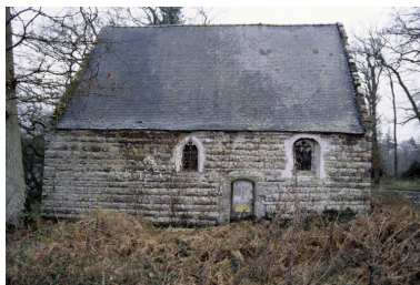
Chapelle - Elévation nord : vue générale. Phot. Claude Quillivic IVR53_19943502600ZA
