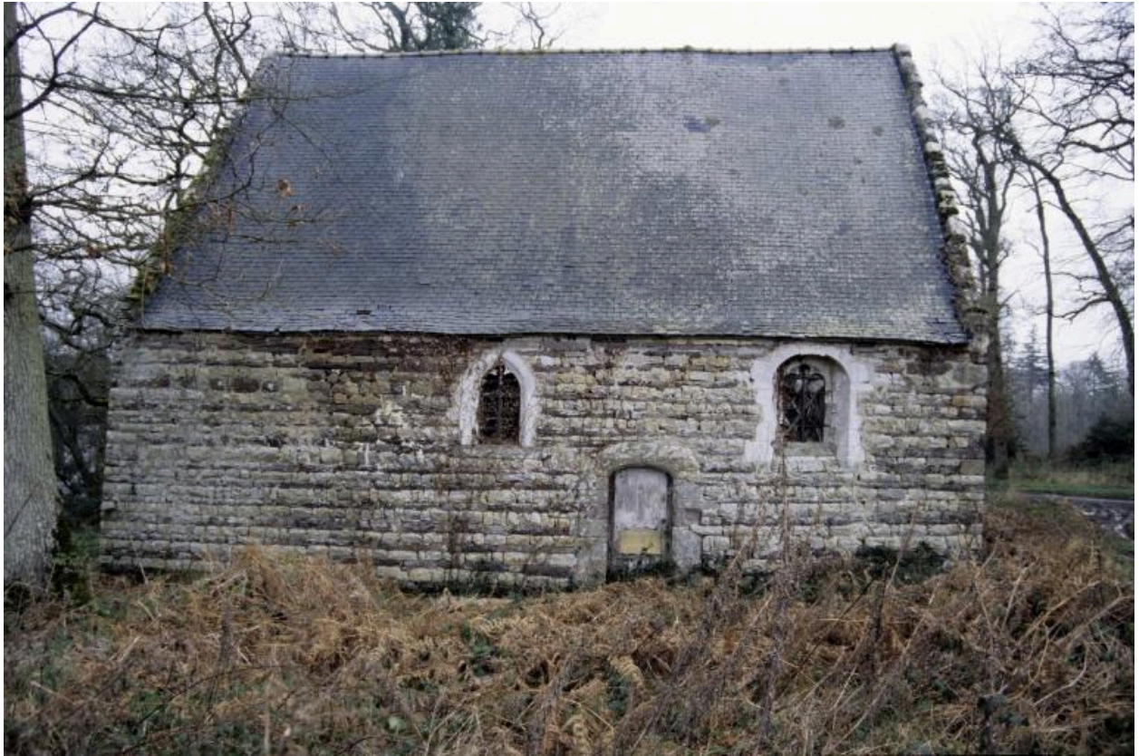
Chapelle - Elévation nord : vue générale.
