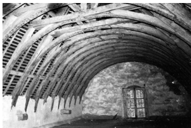
Chapelle, vue générale de la charpente. Phot. Jean-Claude Groussard IVR53_19683500542Z
