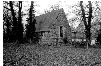
Chapelle, vue sud-est. Phot. Jean-Claude Groussard IVR53_19683500538Z
