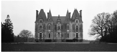
Vue générale de la façade sud. Phot. Jean-Claude Groussard IVR53_19683500543Z
