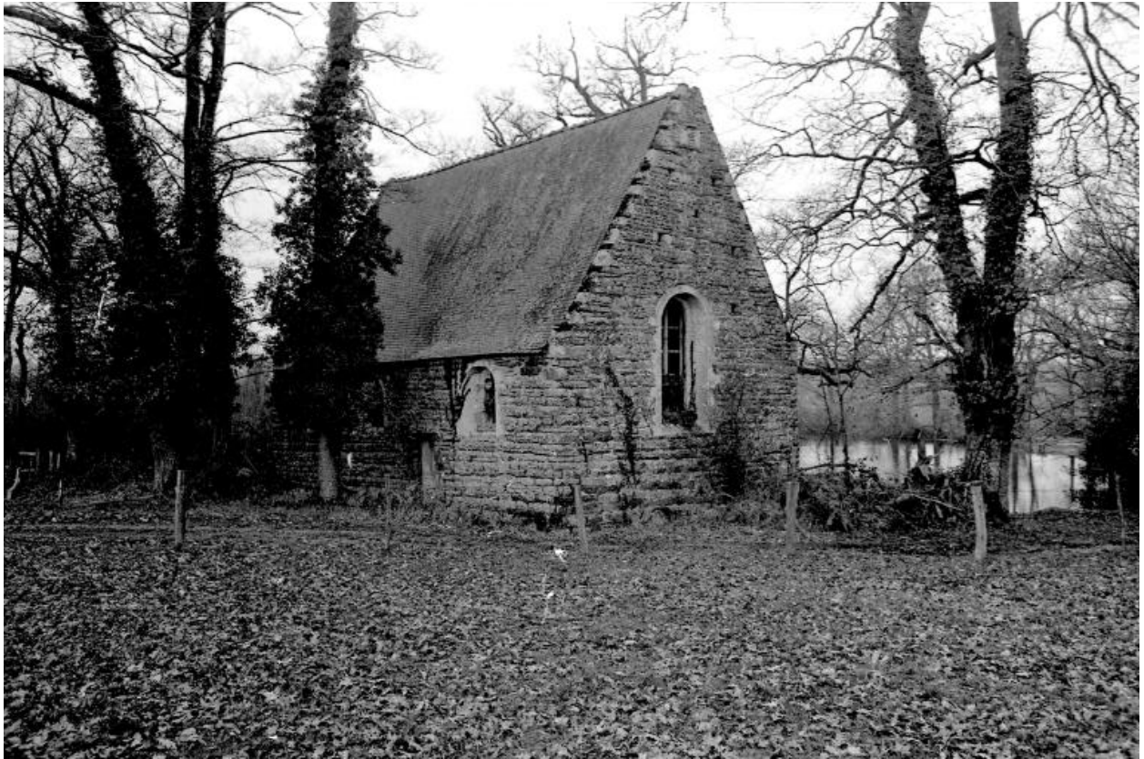
Chapelle, vue sud-est.
