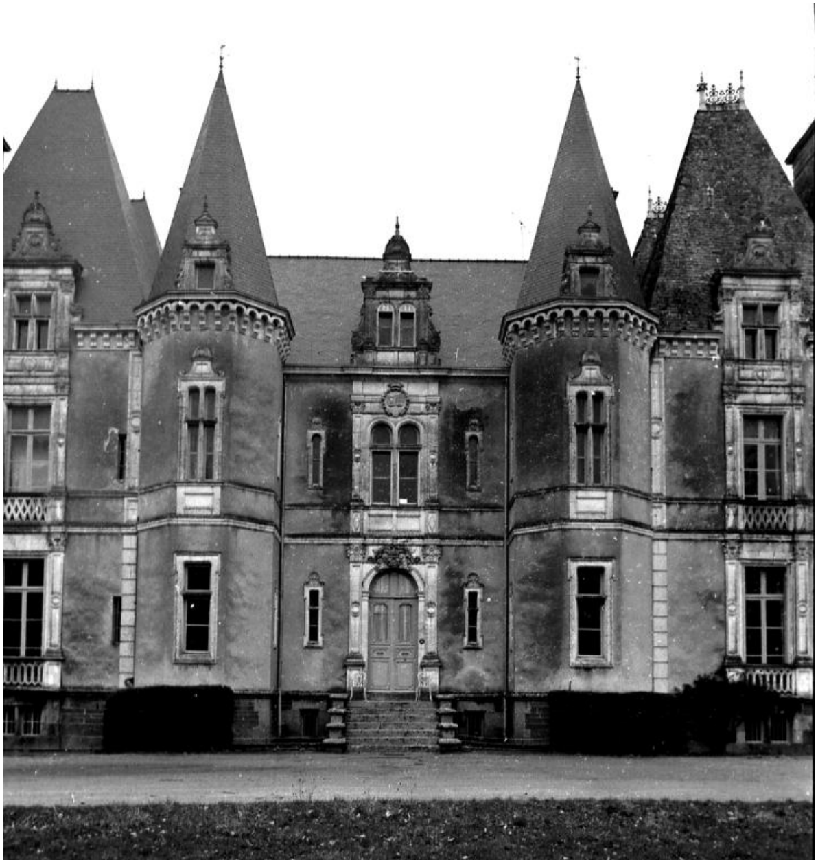
Façade sud, travée centrale.
