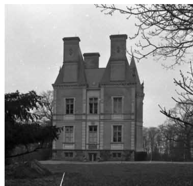
Vue générale de la face ouest. Phot. Jean-Claude Groussard IVR53_19683500547Z
