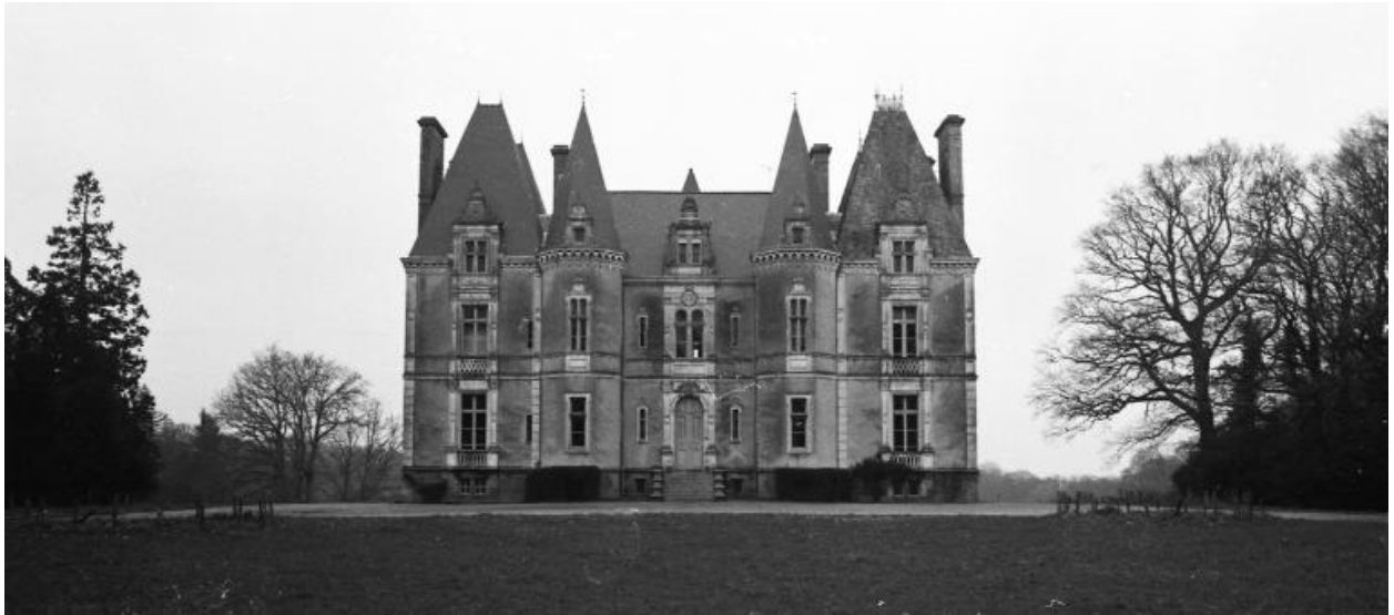
Vue générale de la façade sud.
