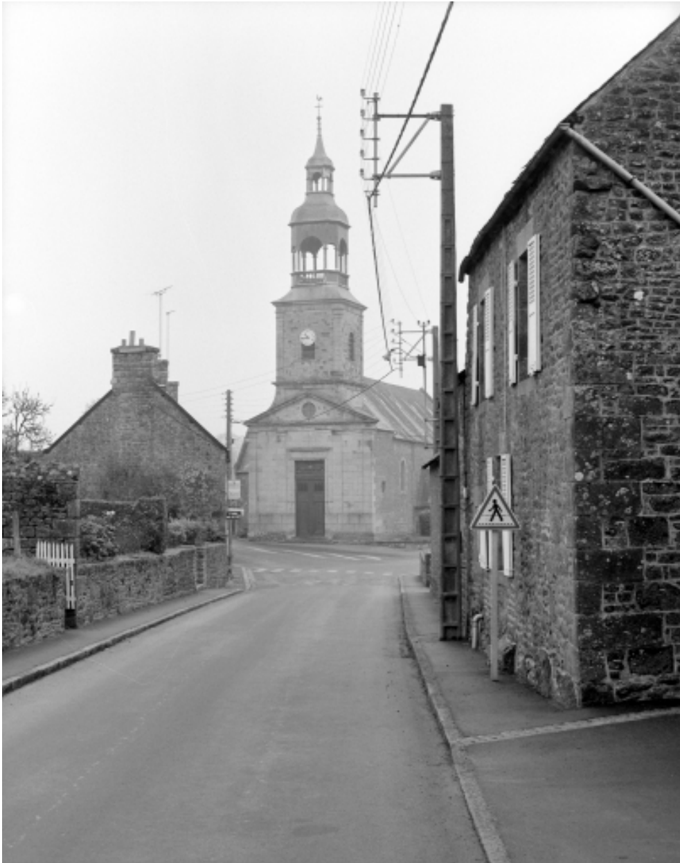
Elévation Ouest, clocher : vue générale
