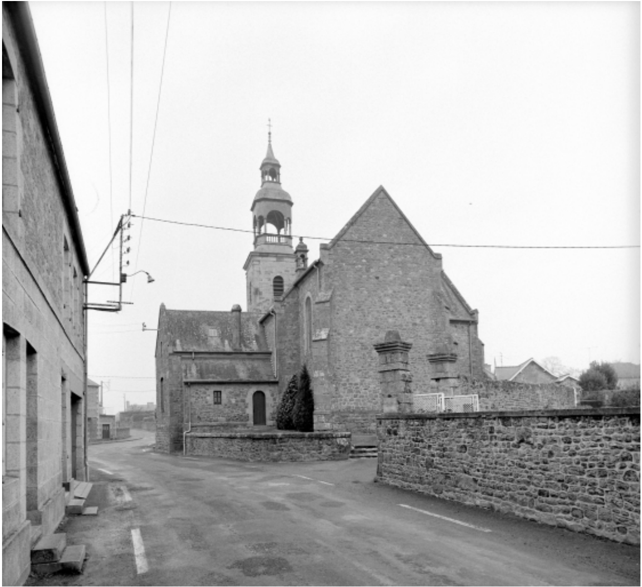
Elévation Nord : vue générale
