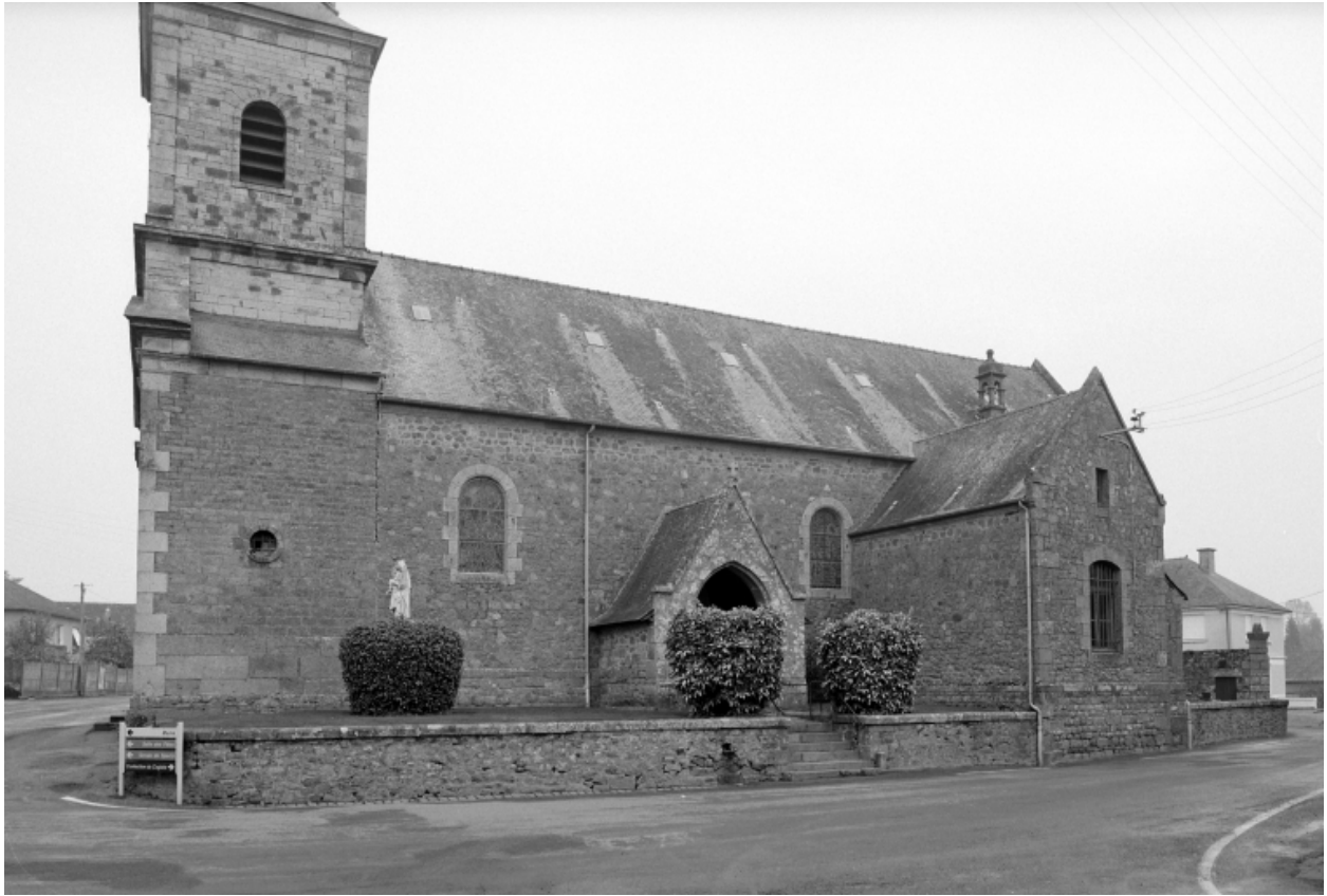
Elévation Sud : vue générale
