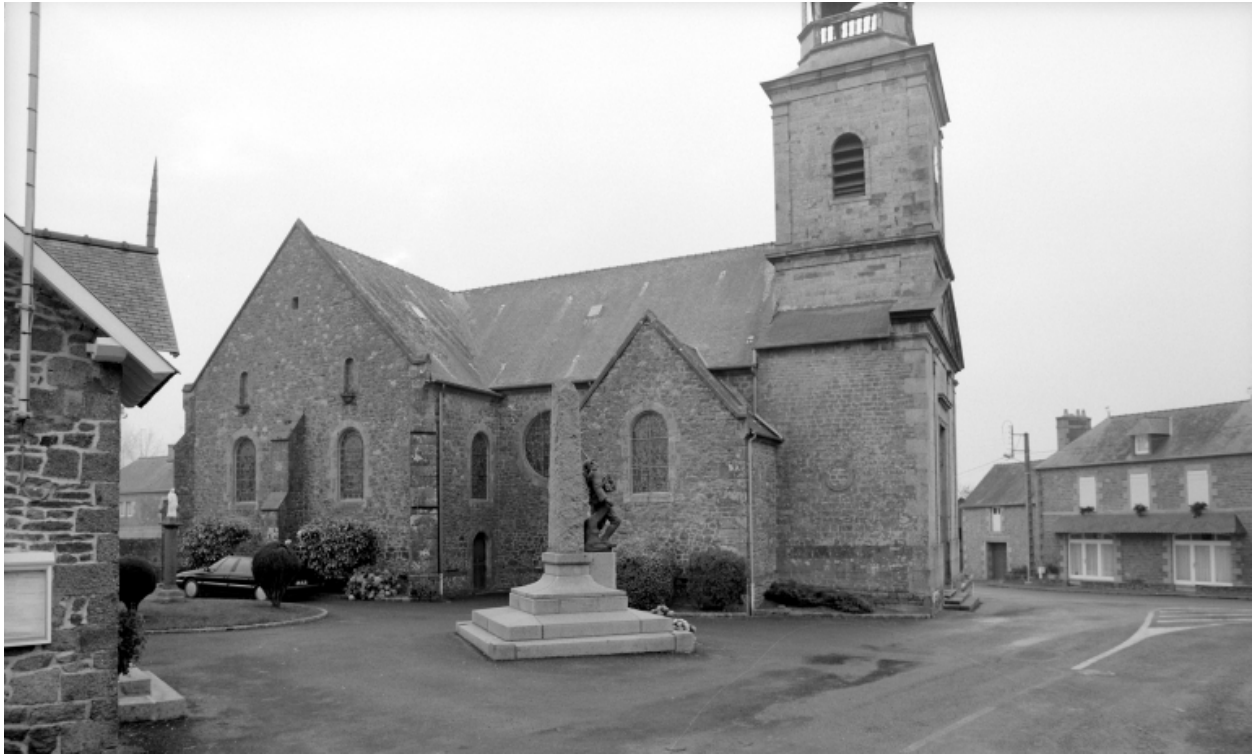
Elévation Est : vue générale
