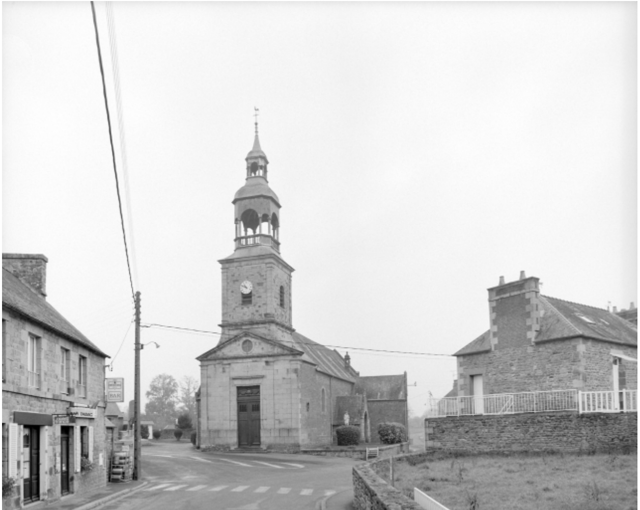
Elévation Ouest : vue générale
