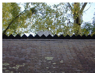
Faîtage, ardoises datées : détail Phot. Xavier Gilbert IVR53_20013512306NUCA
