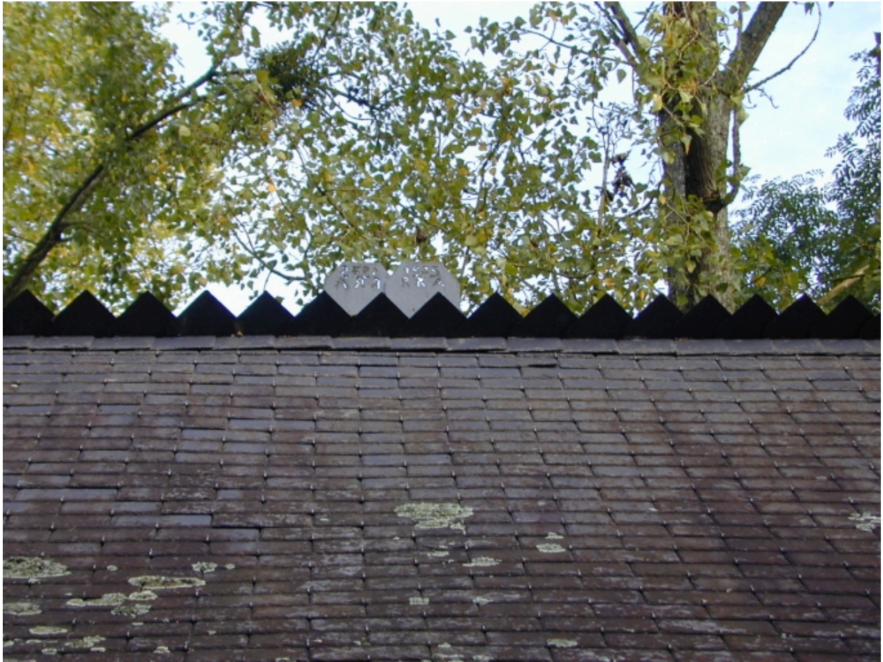
Faîtage, ardoises datées : détail
