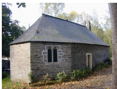
Vue générale nord-est Phot. Xavier Gilbert IVR53_20013512301NUCA
