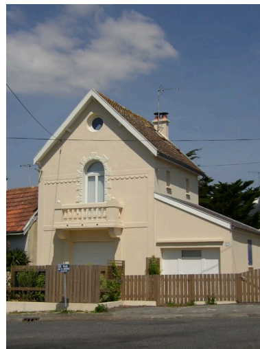
Maison de villégiature du 16 rue de la Marne Phot. Johan Vincent IVR53_20065606514NUCA
