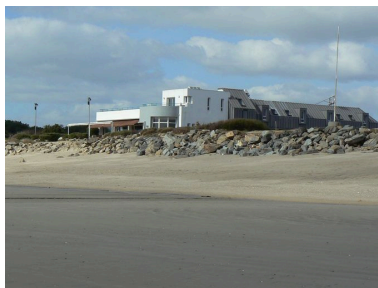
Hôtel-restaurant Les Mouettes Phot. Johan Vincent IVR53_20075605577NUCA
