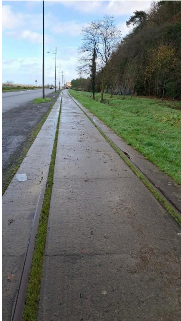
Les voies ferrées du port de Saint-Brieuc-Le Légué : aménagées en piste cyclable.
