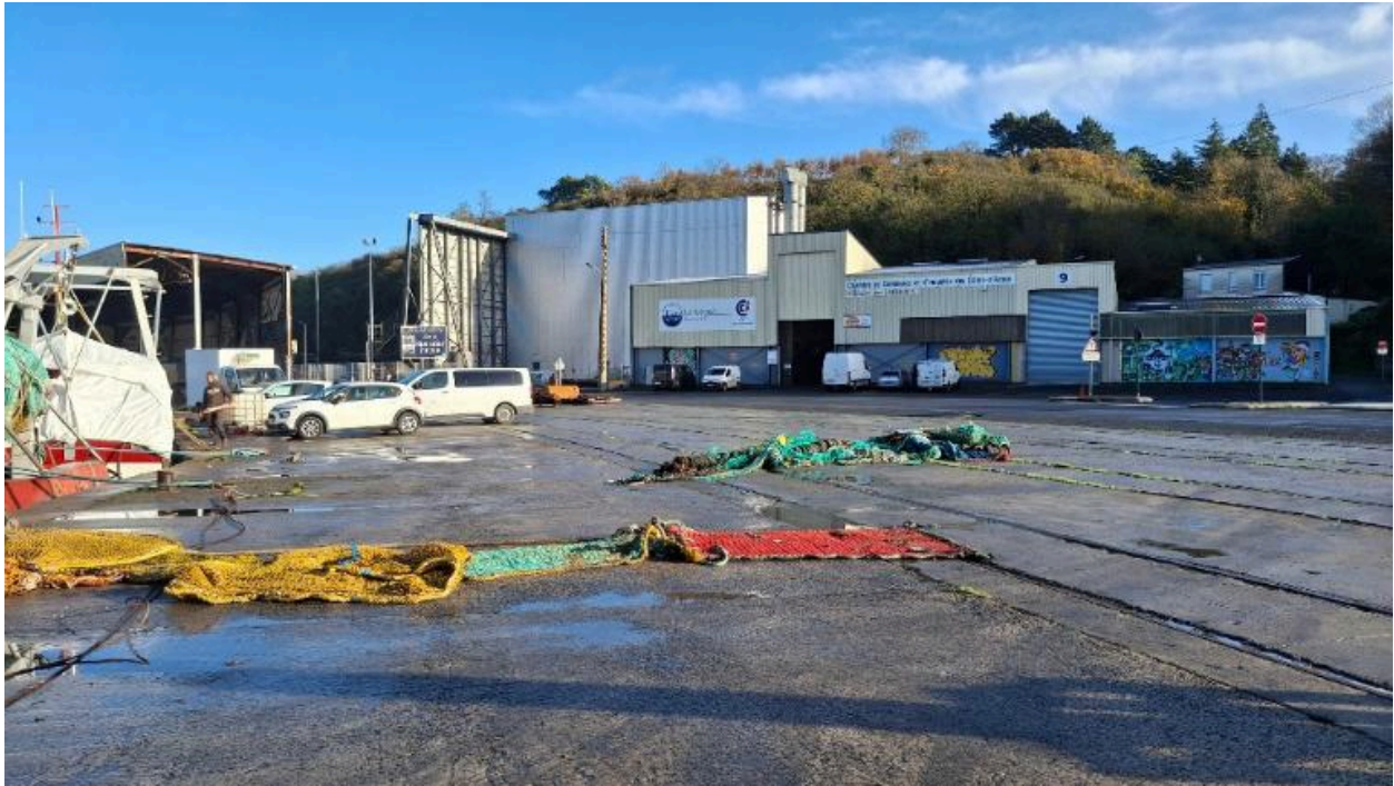
Vestiges de la voie ferrée aux abords du bassin et du site de réparation navale
