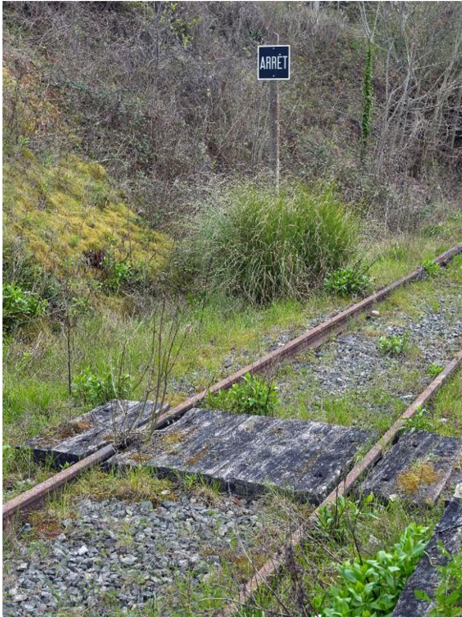
Vestige du réseau ferré du port
