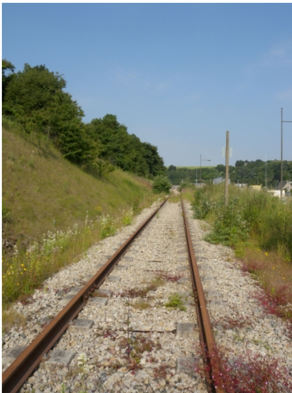
Vue générale de la voie du chemin de fer, rive droite du Légué
